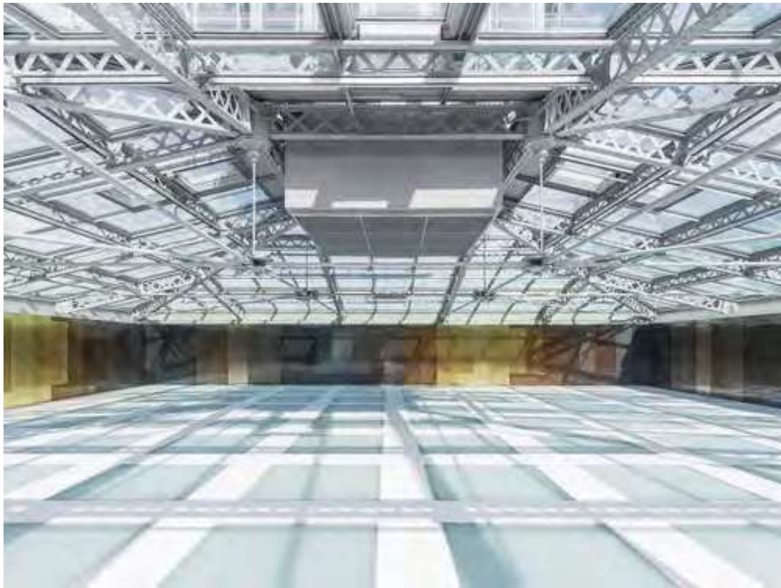
Img 4.17: Fondaco dei Tedeschi - Roof floor (OMA)
