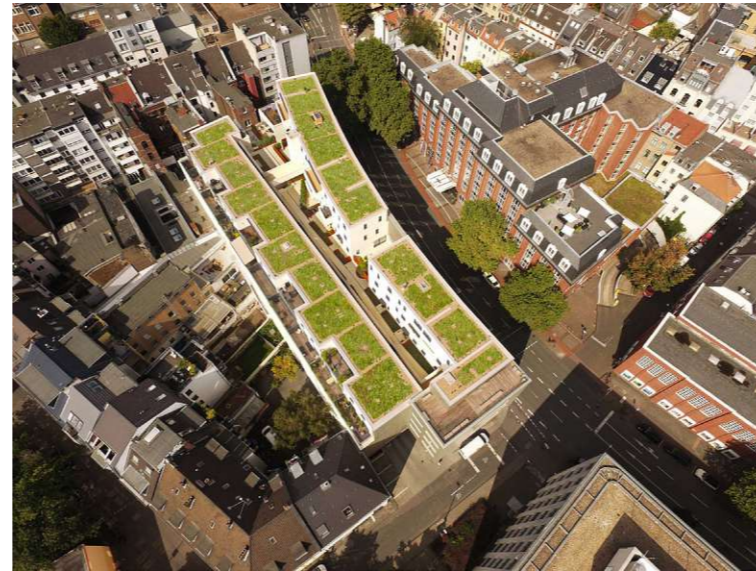
Abb. 6: Vogelperspektive Dachaufbau des Parkhauses
