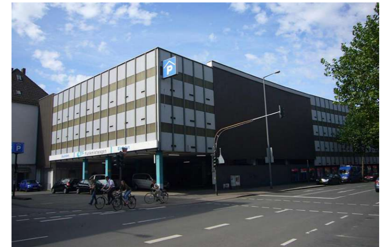
Abb. 8: Das Parkhaus vor dem Umbau
