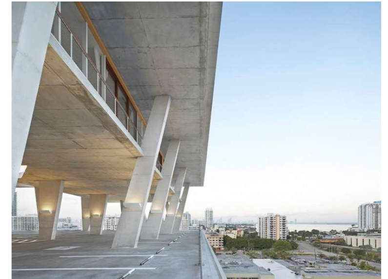
Abb. 5: Geschosshöhen bis zu 9 m
