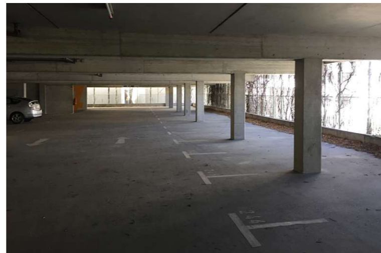
Abb. 30: Fahrbahn-Blick Richtung Feuermauer Obere Donaustrasse
