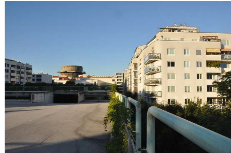
Abb. 18: Direkter Nachbar-Balkone, Loggien, Obere Augartenstrasse 18
