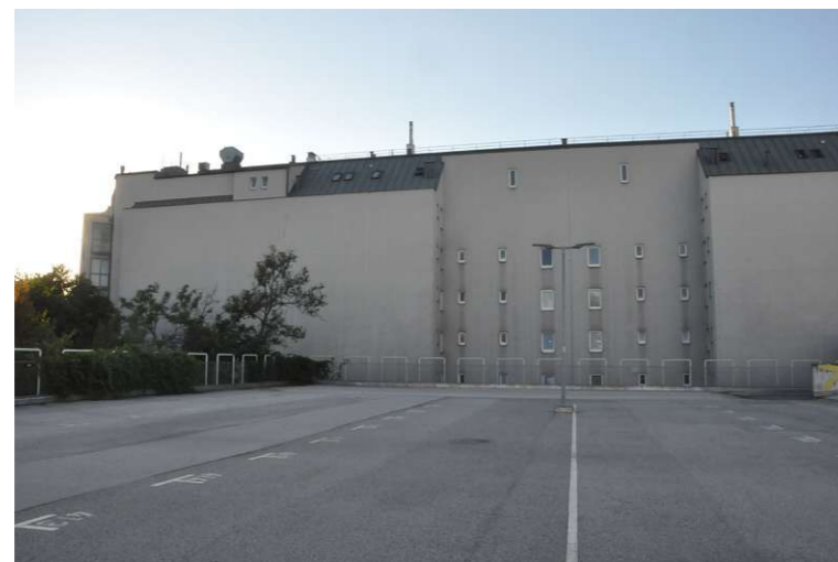
Abb. 17: Blick vom obersten Parkdeck Richtung der Feuermauern, der zurückspringende Mittelteil beinhaltet Nebenräume.
