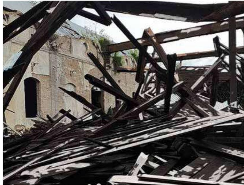
Abb. 38 - A Collage eingestürztes Dach
