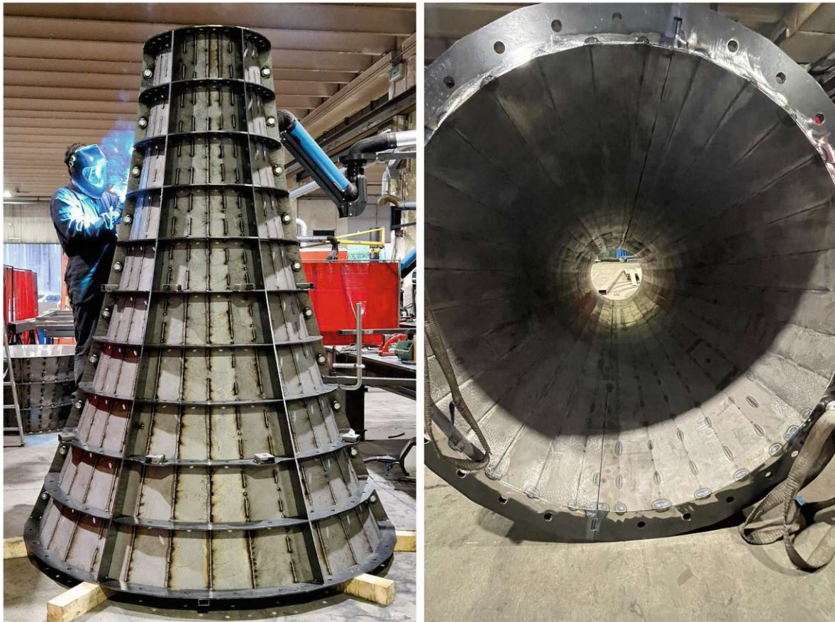
Abb. 4.6: Montage- und Schweißarbeiten an einem Segment der Säulenschalung (Quelle: Eigene Aufnahme)
