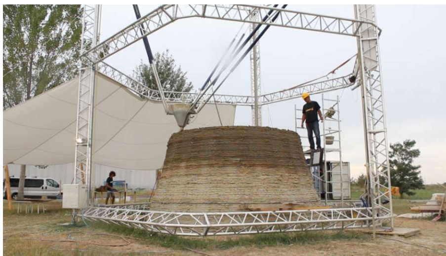
Abb. 3.7: Lehm 3D-Drucker Big Delta des italienischen Unternehmens Wasp (Quelle: Rodgers [72])
