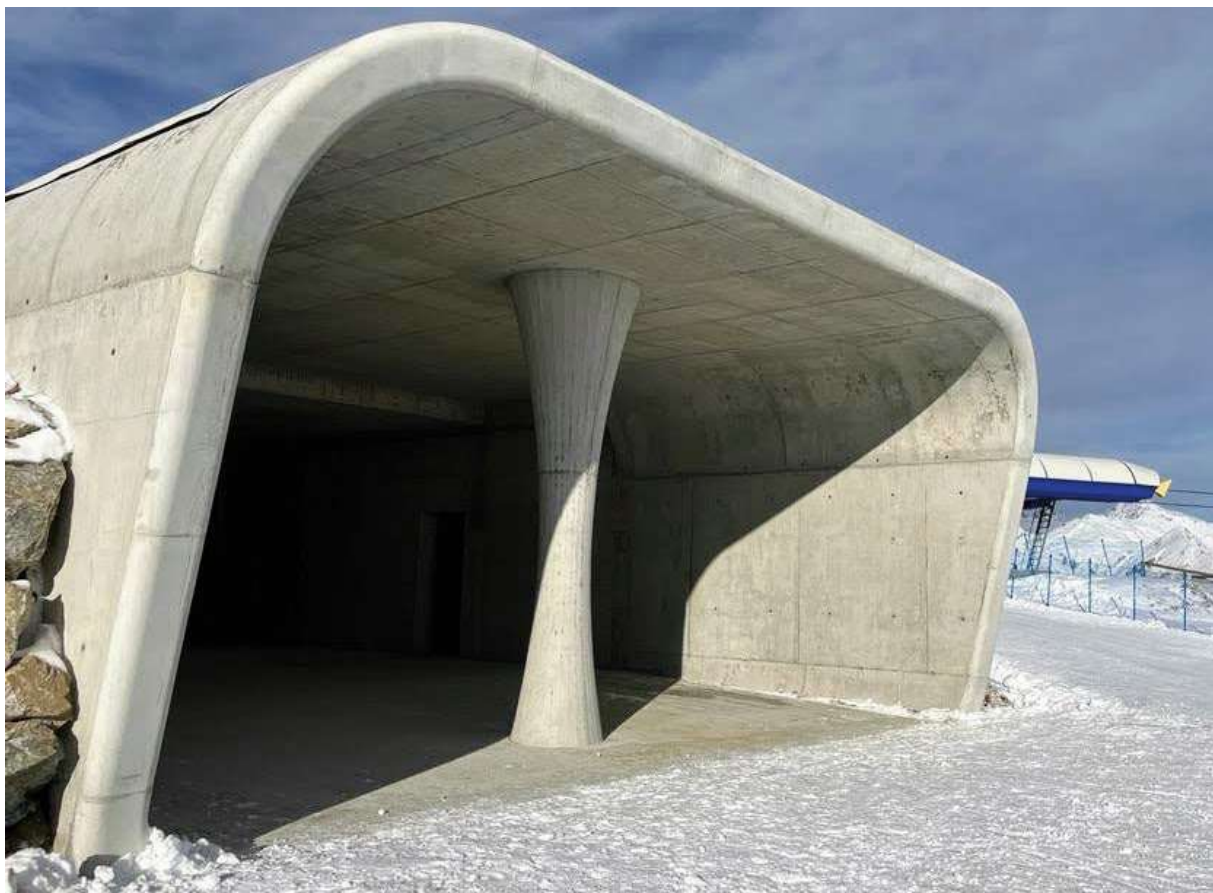
Abb. 4.1: Eingangsportal für Fußgänger an der Bergstation der Seilbahn Prà Rodont im Skigebiet Pinzolo - Stahlbetonsäule mit Spezialschalung aus Stahl Version H= 4 m (Quelle: Eigene Aufnahme)
