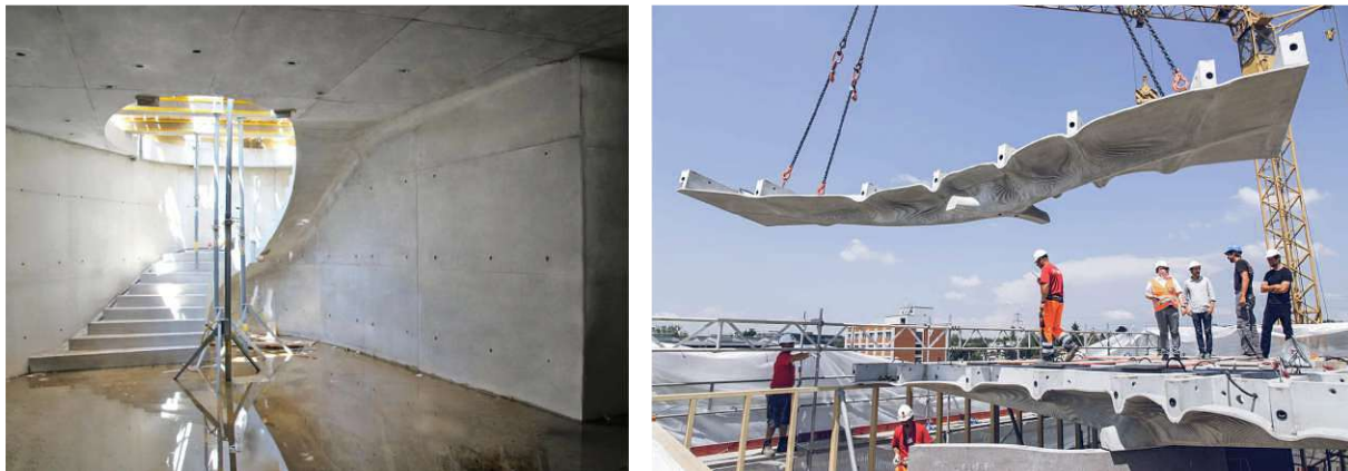
Abb. 3.19: Mehrfach gekrümmte Treppenunterseite aus Kombination von 3D-gedruckter und konventioneller Schalung hergestellt (links). Verlorene Schalung für eine statisch optimierte Betonplatte (rechts) (Quelle: Voxeljet [92])
