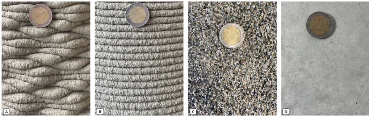
Abb. 5.4: Oberflächenstruktur - 3DCP (A+B), SPI (C), Schalung aus Stahl (D) (Quelle: Eigene Aufnahmen)
