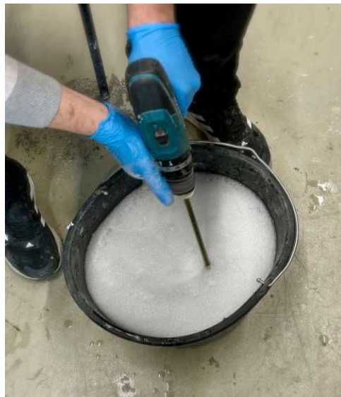
Abb. 14 Vorbereitung der PVA-Emulsion
