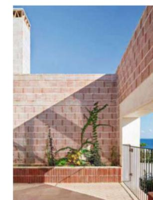
Abb. 67 Detail Ziegel mit Kalkmörtel
