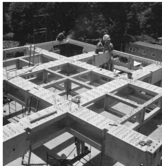
Abb. 31 Zusammensetzung der Betonträgerelemente
