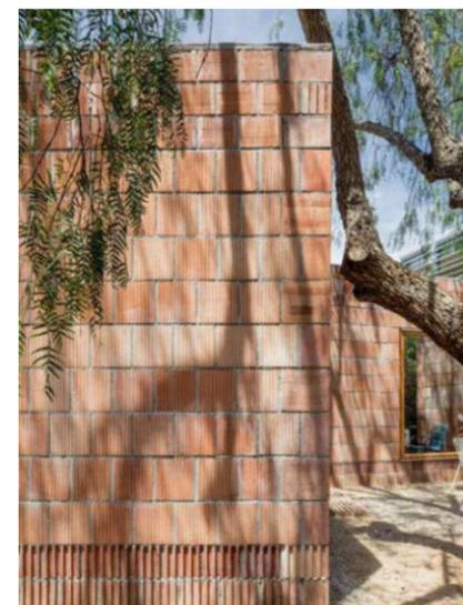
Abb. 64 Außenfassade mit Porotonziegeln
