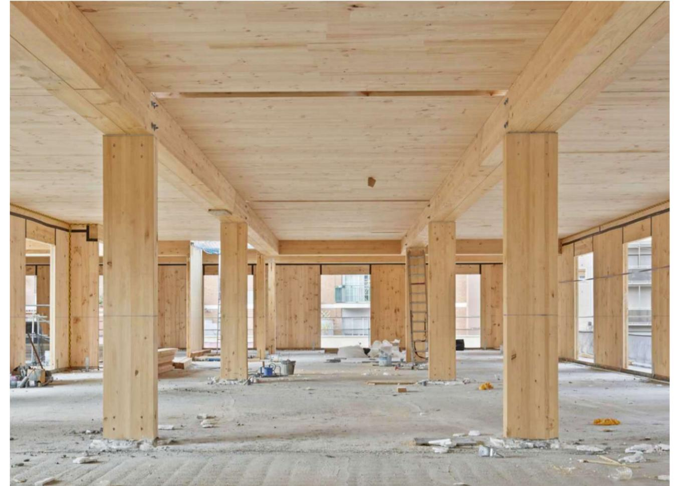
Abb. 26 Tragwerk aus Holzstützen und -unterzügen
