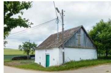
Abb. 3.24: Grafensulz, Hintaus . Störende Stromleitung auf dem Dach.
