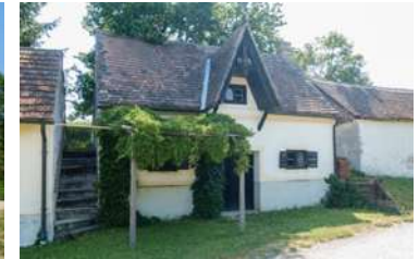
Abb. 3.30: Gebmanns, Südliches Ortsende Unpassende Spitzgaube und zu hoher Sockel, sowie außen liegende Fenster.
