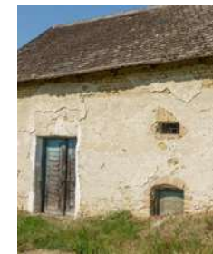
Abb. 4.185: Niederleis, Kalkgrube. Gaitloch mit Holztür.
