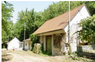
Abb. 3.46: Absdorf, Absberg Großflächig fehlender Putz und falsche Dacheindeckung mit Biberschwanzziegeln.
