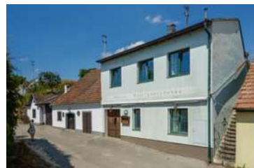
Abb. 3.53: Fels am Wagram, Zwerigraben Scheinbar nachträgliche Aufstockung eines Presshauses mit viel zu großen Fenstern.
