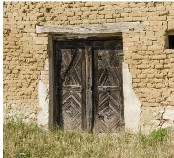
Abb. 4.175: Nodendorf, Gaisbüglweg . Holzüberlager in einem Lehmziegelmauerwerk.
