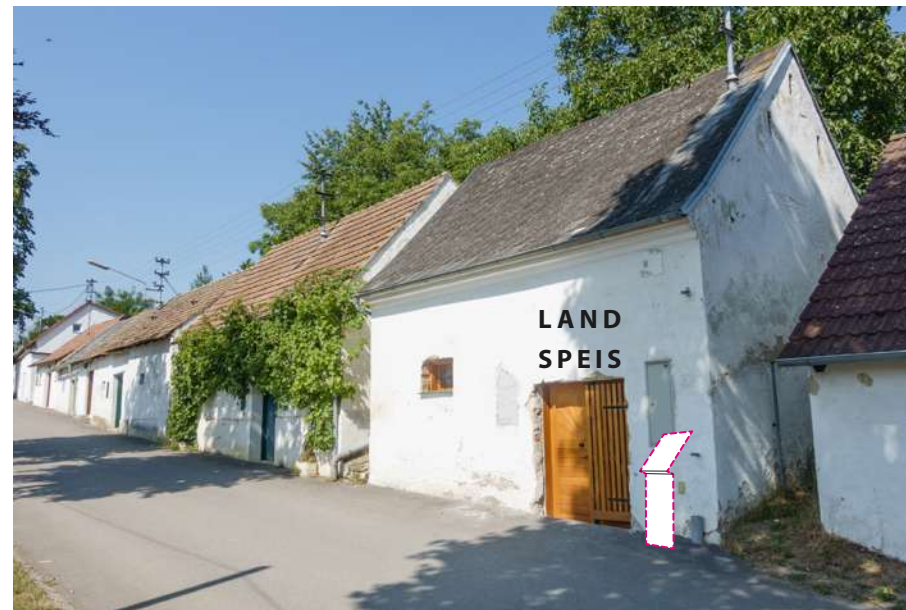
Abb. 5.29: Siebenhirten, Bahnkellergasse. Landspeis Presshaus
