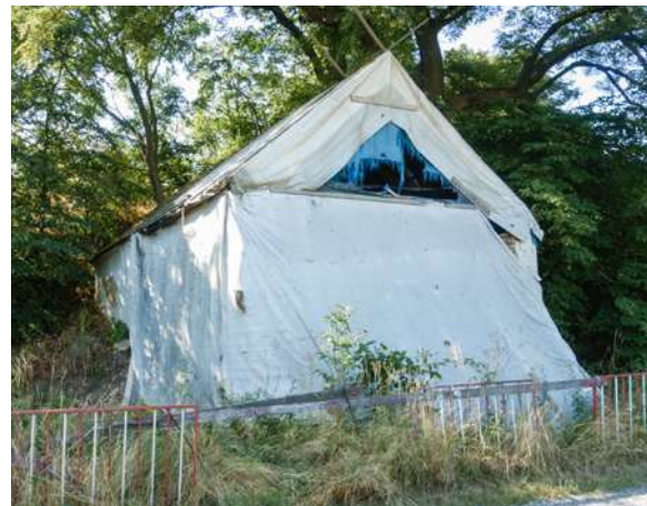
Abb. 4.13: Wollmannsberg, Untern Weyer. Vorübergehende Konservierung eines Presshauses mit Planen.
