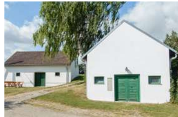
Abb. 3.18: Paasdorf, Karl König Straße . Zu weit außen eingesetzte Fenster und der glatte Putz mindern die ansonsten sehr schöne Ansicht des Presshauses.
