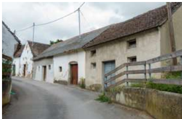
Abb. 3.21: Grafensulz, Hintaus . Unpassende Dachdeckung (Wellplatten). Beeinträchtigt Gesamteindruck durch Stromleitungen auf den Dächern.
