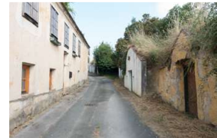
Abb. 2.16: Drasenhofen, Untere Kellergasse
