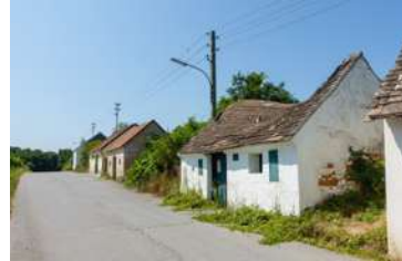
Abb. 3.13: Kleinhadernsdorf, Schnellern Keller . Desolater Dachstuhl. Sanierung dringend notwendig.
