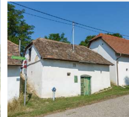
Abb. 4.189: Siebenhirten, Bahnkellergasse . Krüppelwalmdach. Der Krüppelwalm wurde aus formalen Gründen gebaut, um die Härte eines großen Giebels zu mildern. (Leierer 2018: 30)
