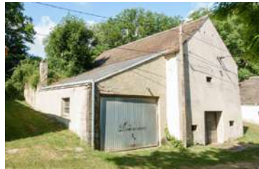
Abb. 3.17: Paasdorf, Karl König Straße . Stark veränderte Gebäudekubatur durch später hinzugefügten Anbau.
