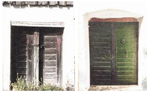
Abb. 4.179: Eine östliche (links) und westliche Kellertür (rechts)
