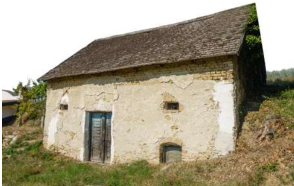
Abb. 4.174: Niederleis, Kalkgrube . Maueröffnungen am Beispiel eines traufständigen Presshauses.
