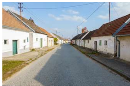
Abb. 2.66: Wetzelsdorf, Große Kellergasse
