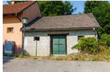
Abb. 3.27: Niederleis, Beim Kindergarten Die Sanierung mit Betonschalsteinen widerspricht jeder Auffassung eines vernakulären Presshauses.
