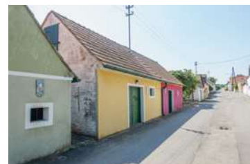
Abb. 3.9: Kleinhadersdorf, Schnellern Keller . Unpassende Farbgestaltung. „Einheitliches“ Kunstprojekt in der gesamten Kellergasse.
