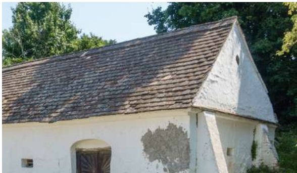
Abb. 4.195: Großrußbach, Sulzweg/Heideweg . Traufständiges Presshaus mit gemauerten Staffelgesims und Giebelgesims. Die seitlichen Stützmauern wurden voraussichtlich aus statischen Gründen nachträglich erstellt.
