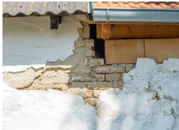
Abb. 4.11: Siebenhirten, Bahnkellergasse . Erneuerung der Mauerabschluss mittels Hochlochziegel. Scheinbar im Zuge der Errichtung eines neuen Dachstuhls.
