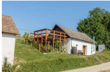
Abb. 3.26: Niederleis, Kalkgrube Gestörter Gesamteindruck durch Terrassenanbau und deplatzierten Edelstahlschornstein an der Vorderseite.
