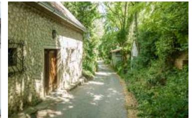
Abb. 3.20: Garmanns, Kellergasse . Absolut unpassende Putzoptik und Fenstergitter.
