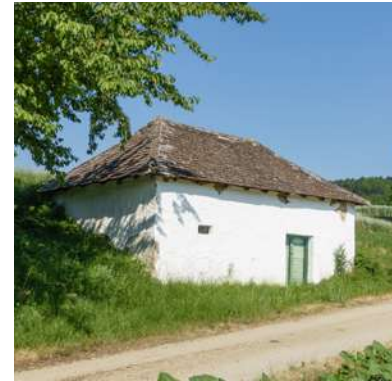
Abb. 4.188: Niederleis, Kalkgrube . Walmdach. Kommt eher selten vor und nur bei freistehenden Presshäusern.
