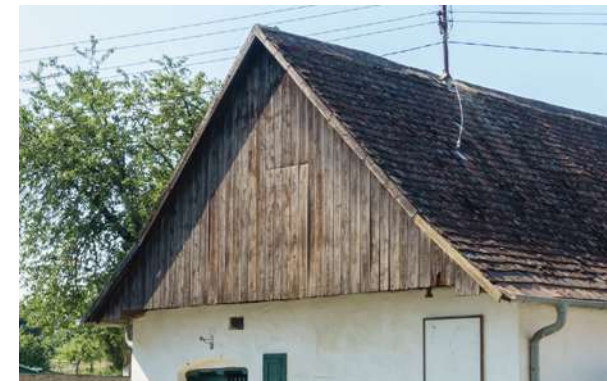
Abb. 4.197: Siebenhirten, Hintaus . Giebelschalung mit geradem Abschluss der unteren Kante.
