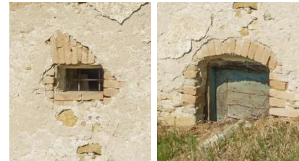
Abb. 4.176: Niederleis, Kalkgrube . Fenster mit Scheitrechten Bogen und Gaitloch mit Segmentbogen.
