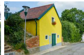
Abb. 3.4: Stützenhofen, Kellerweg Unpassende Farbgestaltung. Zu glatter Putz und überbordende Verblechungen.
