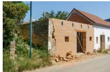
Abb. 3.32: Großrußbach, Flurstraße Sanierung eines ruinösen Presshaus. Die Wahl von Hochlochziegel hat jedoch bauphysikalische Vorteile gegenüber Beton.
