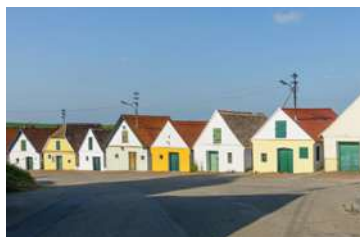
Abb. 3.5: Falkenstein, Oagossn Bunte Farbgestaltung und beeinträchtigter Gesamteindruck durch Stromleitungen auf den Dächern.
