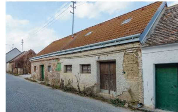
Abb. 4.201: Wetzelsdorf, Große Kellergasse . Saumrinnen haben in einer Kellergasse nicht verloren.
