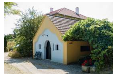
Abb. 3.54: Etsdorf, Kellergasse Unpassende Farb- und Fassadengestaltung.
