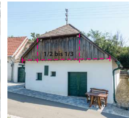
Abb. 4.192: Kleinhadersdorf, Grundern . Die Breite des Krüppel- oder Schopfwalm sollte etwa ein Drittel bis die Hälfte der Giebelbreite ausmachen. (vgl. Leierer 2018: 30)
