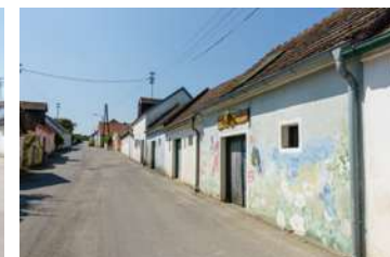
Abb. 3.10: Kleinhadersdorf, Schnellern Keller . Unpassende Farbgestaltung. „Einheitliches“ Kunstprojekt in der gesamten Kellergasse.
