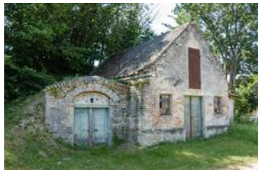
Abb. 3.31: Hipples, Bei der Kapelle Desolater Zustand von Presshaus und Schildmauerkeller. Fehlender Putz und
