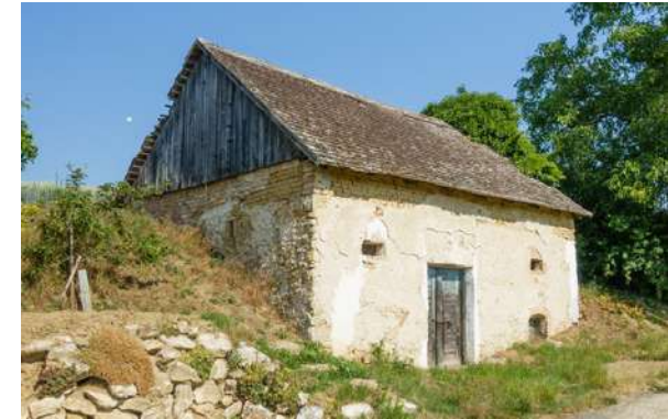
Abb. 4.196: Niederleis, Kalkgrube . Giebelschalung mit geradem Abschluss der unteren Kante.
