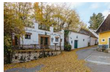
Abb. 3.6: Poysbrunn, Franzensberg Adaptierung einer Dachterrasse mit desaströsen Geländerabschluss.
