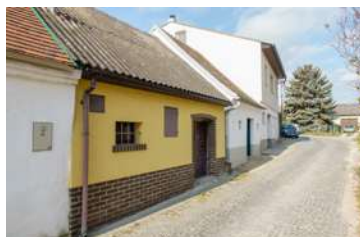
Abb. 3.8: Poysdorf, Radyweg Unpassende Farbgestaltung, Dacheindeckung (Wellplatten) und Sockelausbildung.
