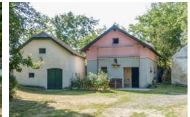
Abb. 3.35: Leitzersdorf, Kellergrund Unpassende Farbgebung und viel zu glatter Putz.
