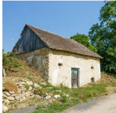
Abb. 4.187: Niederleis, Kalkgrube . Satteldach mit verbrettertem Giebel. Die häufigste Dachform bei Presshäusern.
