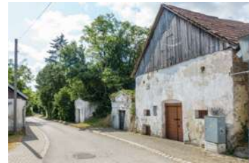
Abb. 3.19: Paasdorf, Karl König Straße . Dringend notwendige Instandsetzung. Unvorteilhafte Platzierung des Stromverteilerkasten.
