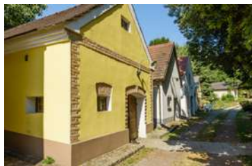
Abb. 3.36: Leitzersdorf, Kellergrund Unpassende Farbgebung und Ziegelfaschen um Tür und Fenster, sowie inkorrekte Sockelausbildung.
