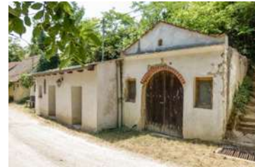
Abb. 3.44: Stetteldorf, Gugans Rundbögen sind in einer Kellergasse fehl am Platz, wie auch die zu großen Fenster.
