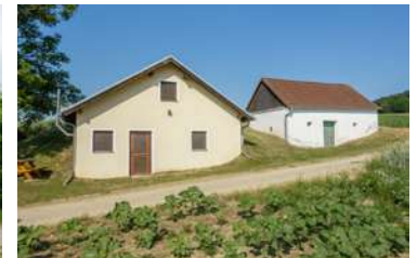
Abb. 3.25: Niederleis, Kalkgrube . Umbau eines Presshauses in ein Wochenendhäuschen mit viel zu großen Fensteröffnungen und unpassend glatten Putz.
