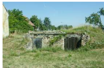
Abb. 3.37: Unterzögersdorf, Tullnerstraße Ruinöse Struktur eines Schildmauerkeller.
