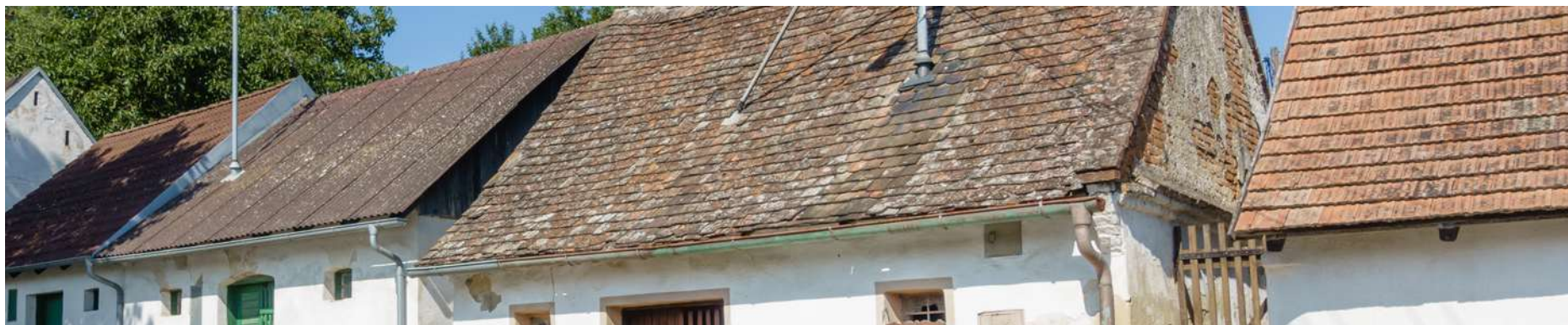
Abb. 4.193: Niederleis, Bahnzeile. Dachdeckungen im Vergleich. Wellblech (Links), eckige und abgerundete „Wiener Taschen“ (Mitte) und Falzziegel (Rechts).
