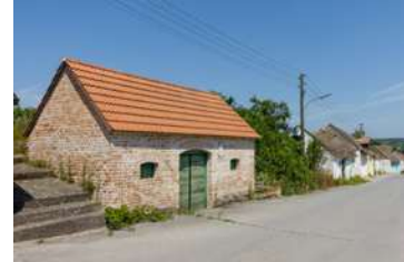
Abb. 3.14: Kleinhadernsdorf, Schnellern Keller . Unpassend saniertes Presshaus. Dacheindeckung zu „clean“ und Sichtziegelmauerwerk ohne Putz.
