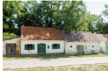
Abb. 3.43: Gaisruck, Zum Himmelreich Zu große Fenster (links) und partielle Putzschäden (rechts).
