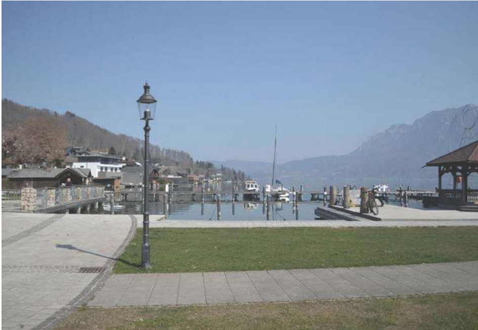
Abb. 44 | Blick auf Steg von Bootsanlegestelle.
