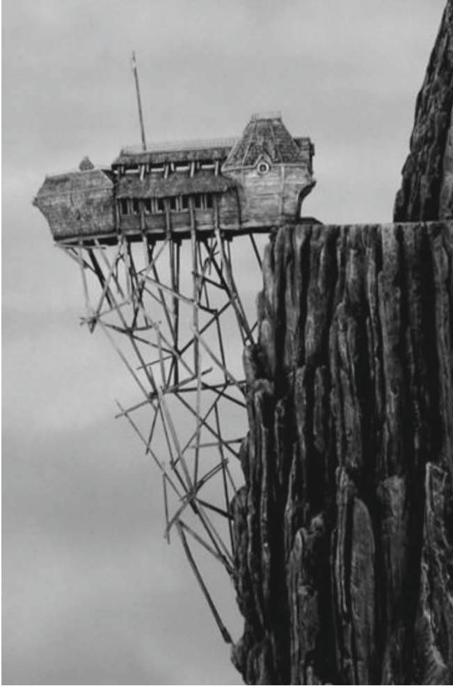
Abb. 50 | Unbekannter Fotograf. Bauwerk auf Gerüst.
