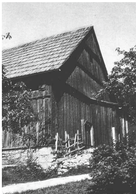
Abb. 16 | Verschalte Giebelwände. Stadel in Hörndl. Bad Goisern.
