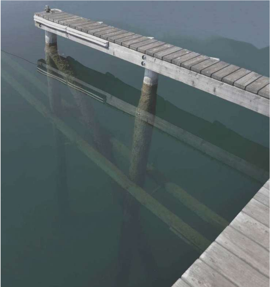
Abb. 6 | Holzkonstruktion des Klimstegs in Unterach am Attersee.
