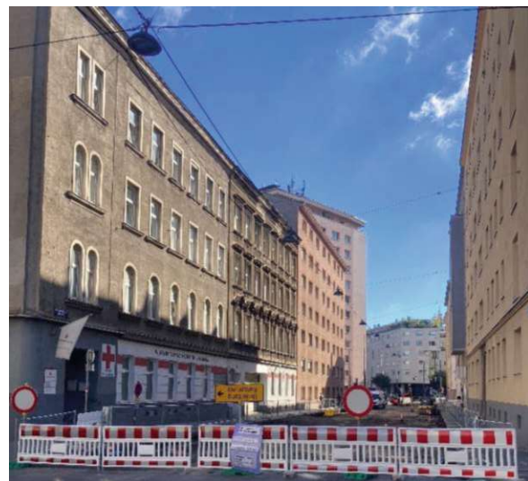
Abbildung 42: Bauarbeiten Landgutgasse 10. Bezirk; eigene Aufnahme
