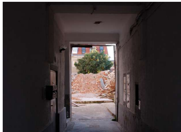
Abb. 24: Abbruch im Hof Neulerchenfelder Straße
