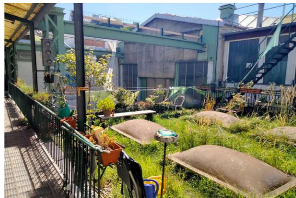
Abb. 35: Begrüntes Dach Steinergasse
