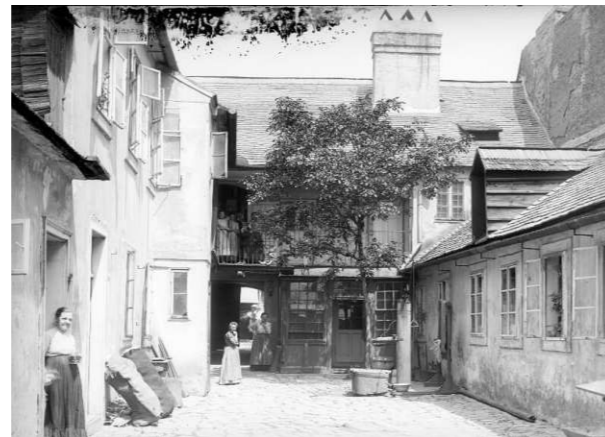
Abb. 20: Hinterhof Neulerchenfelder Straße 41, 1904
