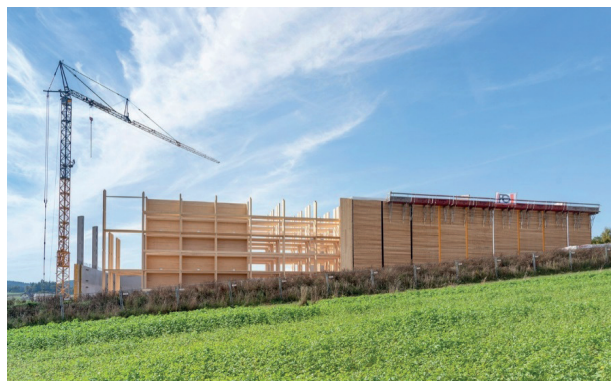
Abbildung 26: Hochregallager der Firma Sonnentor
