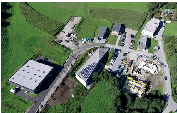
Abbildung 6: Luftbild des Unternehmerzentrum A-L-S (Land Tirol; Brandhuber)
