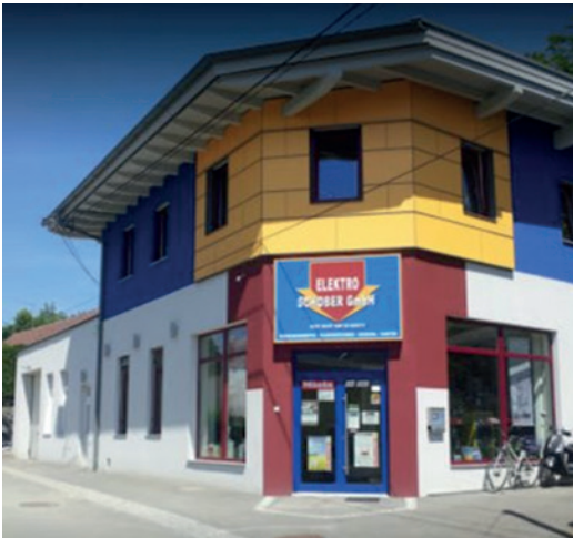
Abbildung 8: Elektriker in Großweikersdorf
