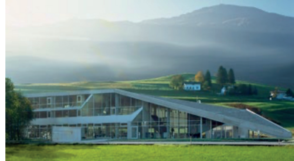
Abbildung 8: Betriebsgebäude der Fa. World Direct im Unternehmerzentrum A-L-S (World Direct)
