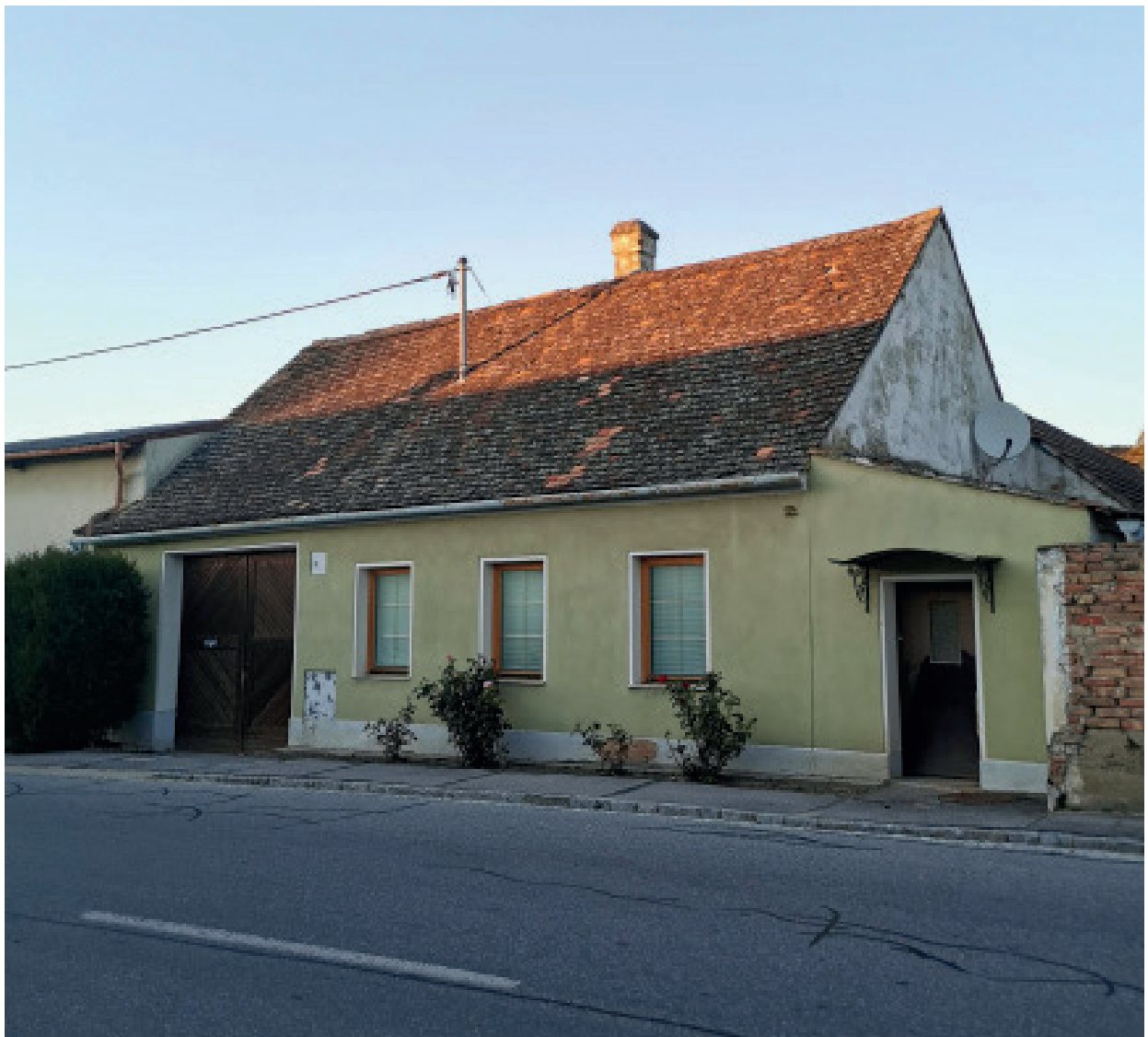
Abbildung 2: Leerstand eines Einfamilienhaus im Ortszentrum, Hauptstraße 124, 2184 Hauskirchen, Quelle: eigene Aufnahme 10/2021
