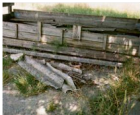
21 Juni 2023 Reste der Abflussrohre vermutlich einer Baracke ragen aus den Fundamentresten im Boden und sind überlagert von Gras, Holzresten und Schutt. Eine genaue zeitliche Zuordnung ist schwierig. Die Aufnahme wurde auf dem Gelände aufgenommen.
