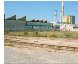
121 September 2024 Die Aufnahme zeigt die Rückseite der ehemaligen Saurer-Werke . Die Dächer sind als Sheddächer ausgeführt, im Hintergrund sind die für die Gegend prägenden Schornsteine zu sehen.
