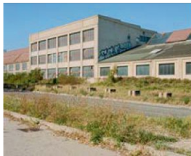
118 September 2024 Aufnahme des Gebäudebestands der ehemaligen Saurer-Werke in Simmering in der Haidestraße . Heute werden die Hallen zum Teil von den Wiener Werkshallen als Eventlocation genutzt.
