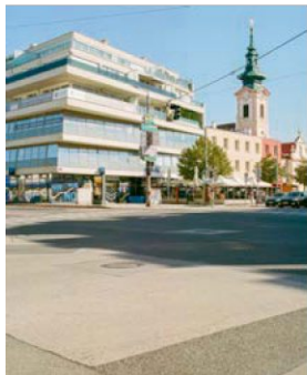
78 September 2024 Die Aufnahme zeigt den Standort des ehemaligen Popper-Brauhaus am Hauptplatz Nr. 3 in Schwechat. Heute steht hier ein Neubau. Der Standort wurde ebenso zur Flugzeugproduktion genutzt.
