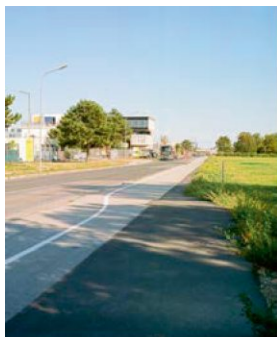
9 September 2024 Die Aufnahme aus der IZ Niederösterreich Süd Straße 3 zeigt die ehemalige Haupterschließungsstraße der Flugmotorenwerke Ostmark , eine heute viel befahrene Straße im Industriegebiet. Der Blick ist auf den mehrfach umgebauten und erweiterten Hochbunker gelenkt, eines der wenigen heute noch bestehenden Gebäude der Flugmotorenwerke . Für den Bau wurden auch KZ-Häftlinge als Arbeitskräfte eingesetzt.
