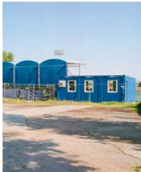
54 September 2024 Aufnahme der Rückseite der Tribünenanlage des FAC Sportplatzes. Die Anlage ist eingezäunt, hinter der Tribüne ist ein Flutlichtscheinwerfer erkennbar.
