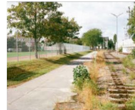
71 September 2023 Aufnahme der Gleisanlage neben dem Phönixsportplatz. Zwischen den Gleisen und dem eingezäunten Sportplatz verläuft ein asphaltierter Fußweg.
