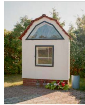
25 September 2023 Eine Aufnahme vom Gedenkstein an der Industriestraße. Die zwei Gedenksteine befinden sich hinter Glas in einer verputzten Umhausung. Diese steht auf einem gemauerten Sockel, der Abschluss ist Mansardenartig ausgeführt und wird durch Dachziegel gebildet. Der kleine Vorplatz ist gepflastert. Ein Behälter steht neben dem Stein, davor sind zwei Grabkerzen und ein Blumenstrauß abgelegt. Im Hintergrund ist Gebüsch zu sehen.
