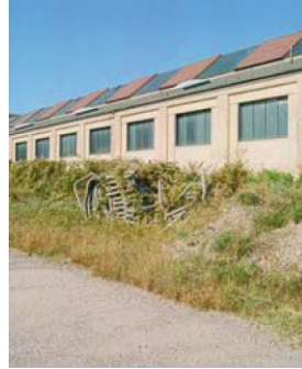
119 September 2024 Aufnahme des Gebäudebestands der ehemaligen Saurer-Werke in Simmering in der Haidestraße . Zwischen Gehweg und Gebäude sind Schutt und Metallreste abgelegt.
