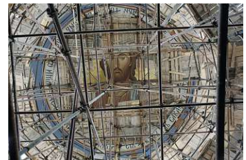
Abb. 61-62: Erstellung der Kuppelmalereien auf einem Gerüst mit Acrylfarben
