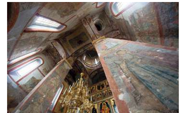
Abb. 33: Blick in den Kuppelraum der Kirche: vollflächige Wandmalereien
