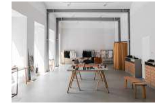
↑ Abb. 3.3 Adaptierung und Umnutzung eines Gründerzeithauses durch Einzug von Stahlprofilen. Geschäftslokal in der Neustiftgasse, Wien
