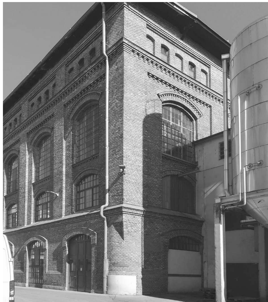
← Abb. 6.7 Gebäudetrakt der Ottakringer Brauerei in der Eisnergasse
