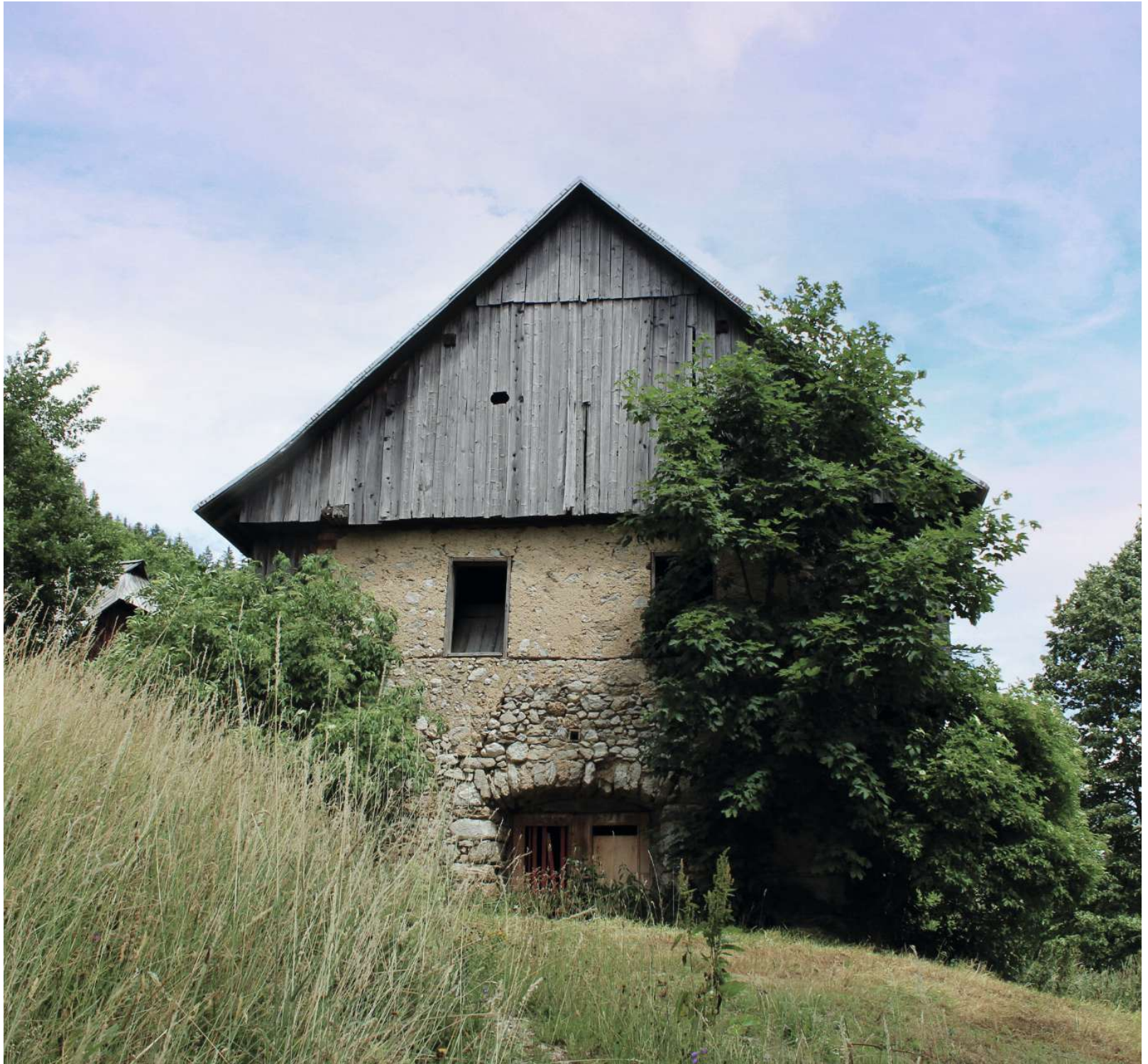
Abb.58: Die neue Scheune
