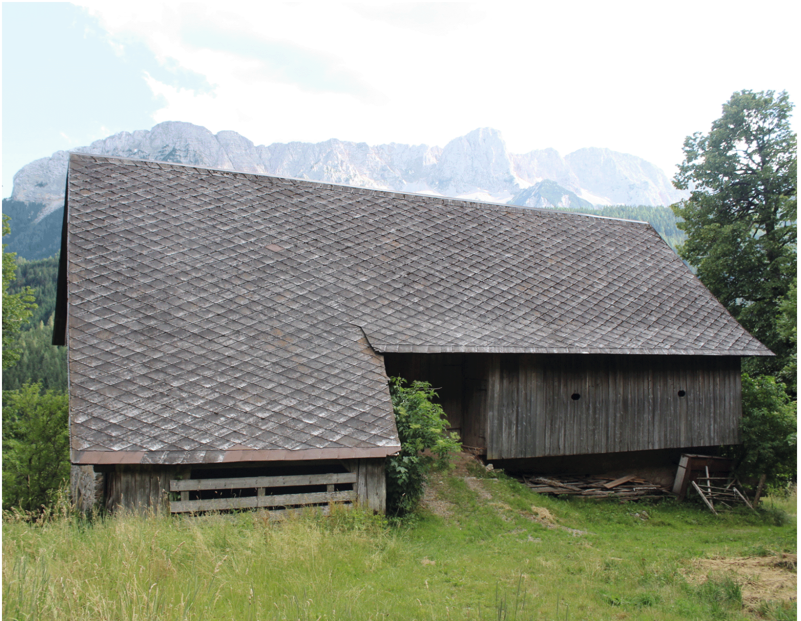
Abb.59: Die neue Scheune – Ansicht Nord
