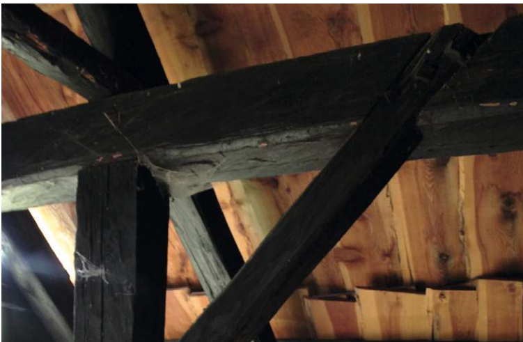
Abb.28: Dachstuhl Detail vom Hauptwohnhaus – Krištan Hof
