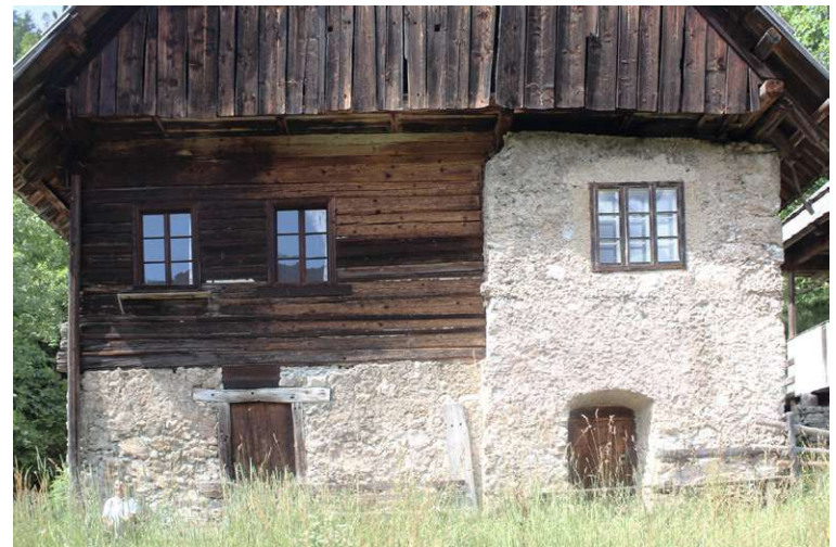
Abb.20: Fassade vom Hauptwohnhaus – Krištan Hof
