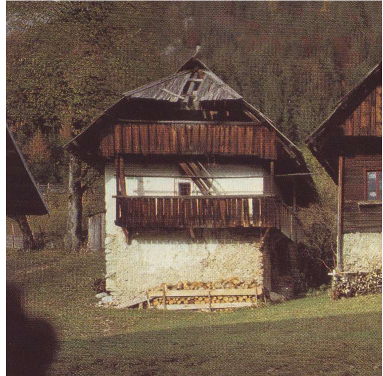
Abb.54: Der Speicher (1991) – heute nicht mehr bestehend
