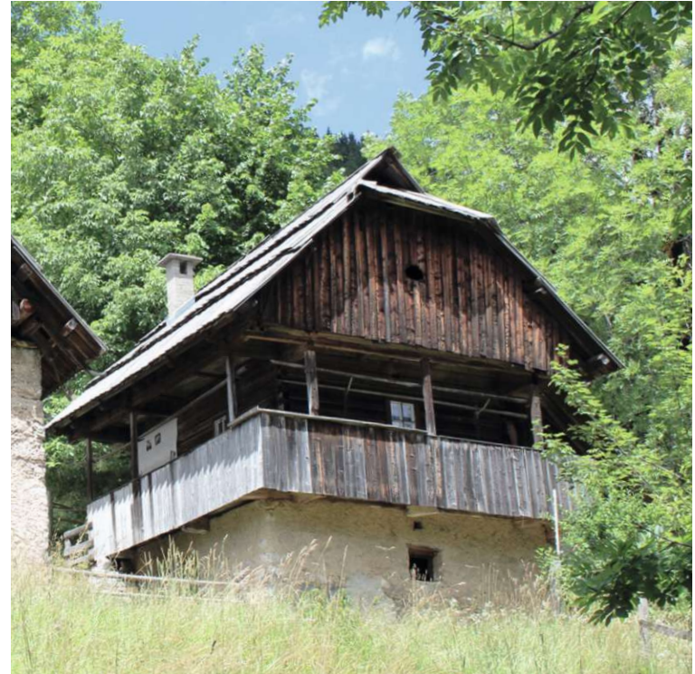
Abb.55: Der neue Speicher/Austraghaus (2021)
