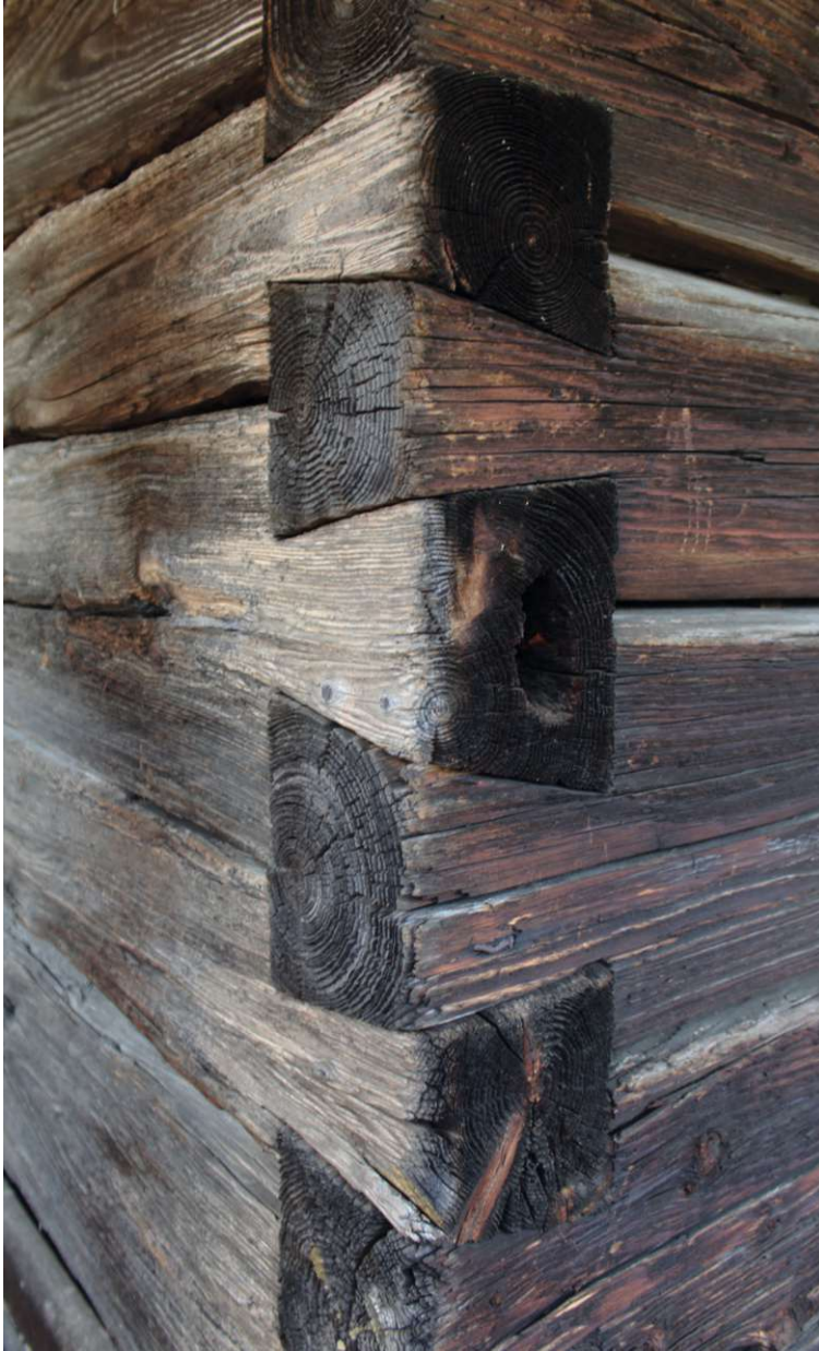
Abb.24: Blockverband mit verzinktem Eckverband beim Kriřtan „Neuer Speicher“
