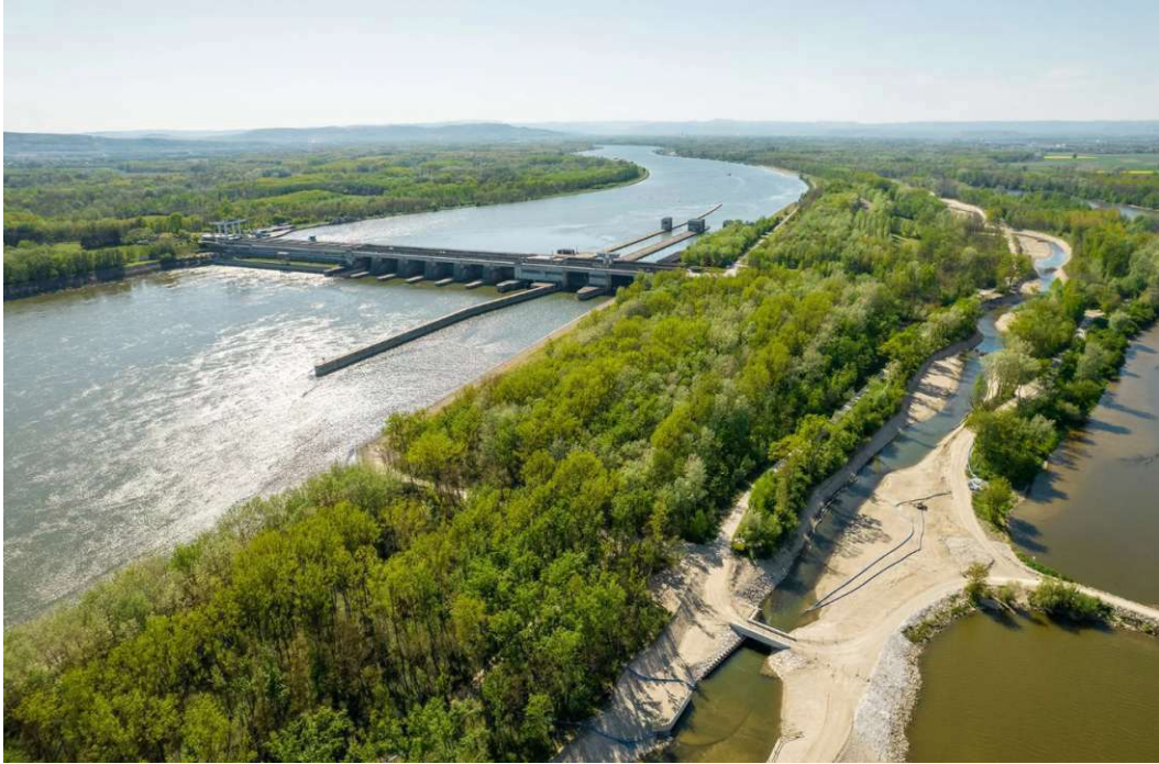
Abbildung 3.1.35: Donaukraftwerk Altenwörth [VERBUND, 2024a].
