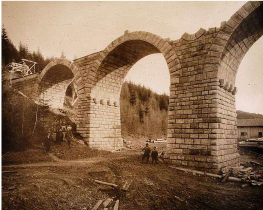
Abbildung 3.1.30: Baustelle der II. Hochquellenleitung beim Aquädukt über das Brentenmais in Niederösterreich (vor 1910) [Stadt Wien, 2024f].
