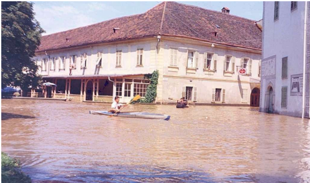
Abbildung 3.1.16: Hochwasser in Bad Radkersburg im Jahr 1965 [Stadtgemeinde Bad Radkersburg, 2024].
