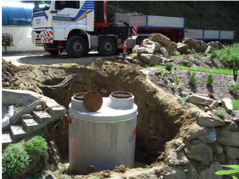
Abbildung 3.1.4: Installation einer Kleinkläranlage der Firma Wagner Umwelttechnik aus Niederösterreich [Wagner Umwelttechnik, 2024].
