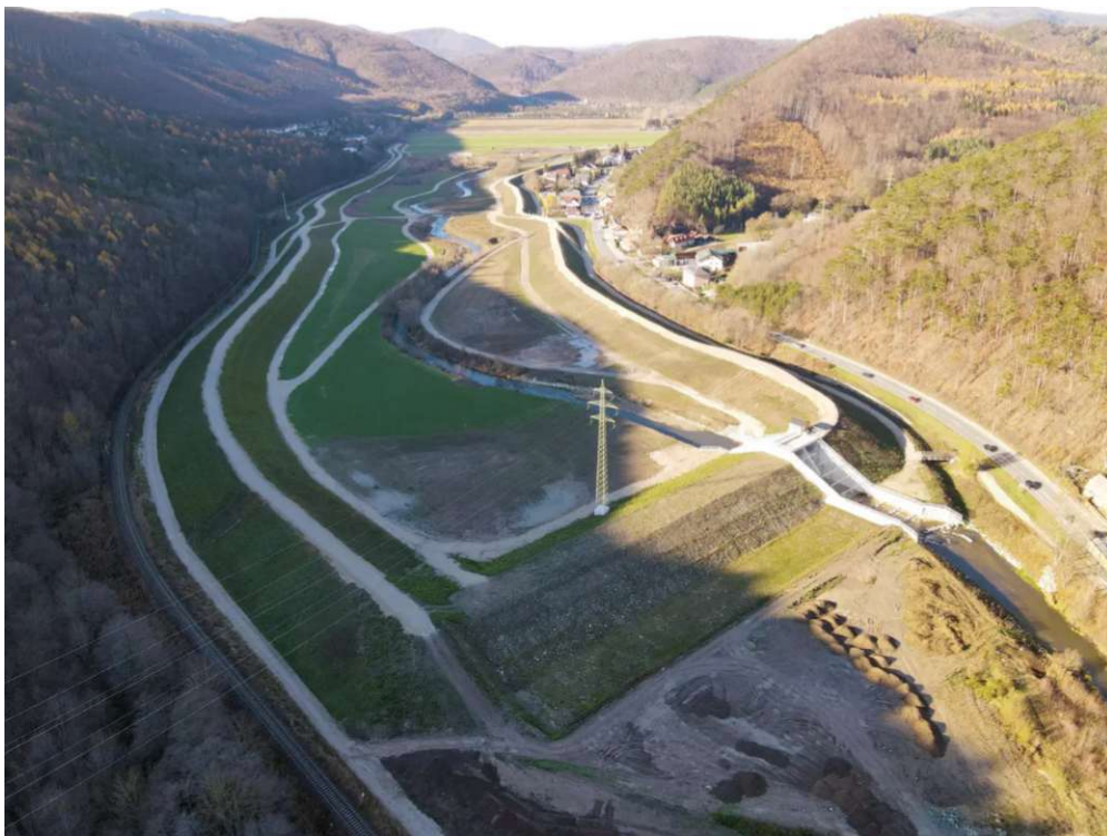
Abbildung 3.2.4: Rückhaltebecken in Fahrafeld im Triestingtal [Triesting Wasserverband, 2024].
