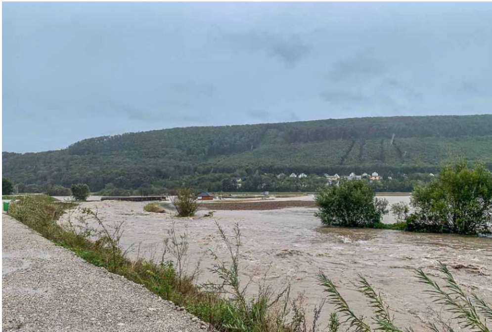
Abbildung 3.2.5: Aufnahme des Rückhaltebeckens in Fahrafeld, veröffentlicht am 16.09.2024 [Zeiler, 2024].
