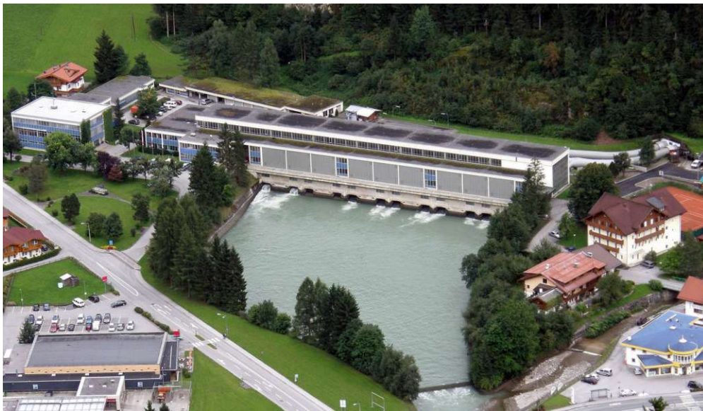
Abbildung 3.1.34: Speicherwerk Mayrhofen [Mauruszat, 2011].
