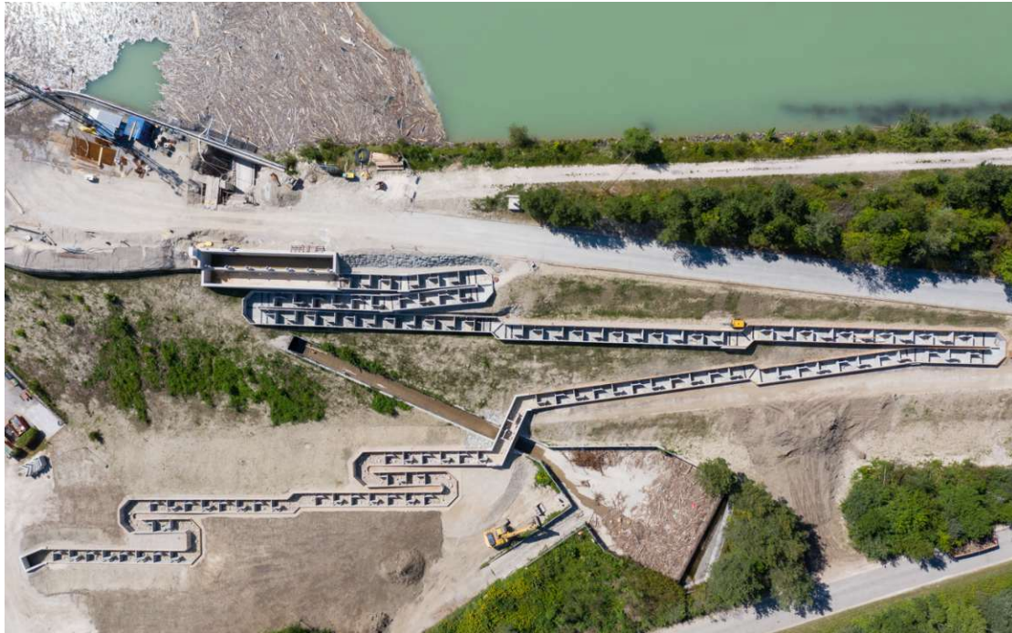
Abbildung 3.1.23: Baustelle der Fischwanderhilfe Annabrunn [VERBUND, 2020]
