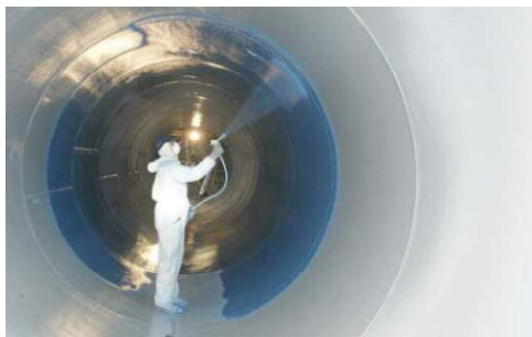
Abb. 26 Aufbringen einer Korrosionsschutzschicht auf die Panzerung 4
