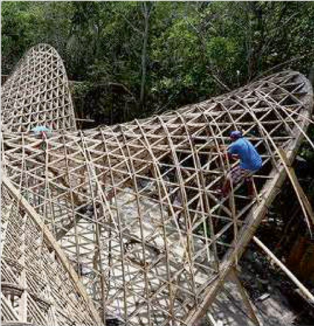
Abbildung 13: Konstruktion aus Bambus
