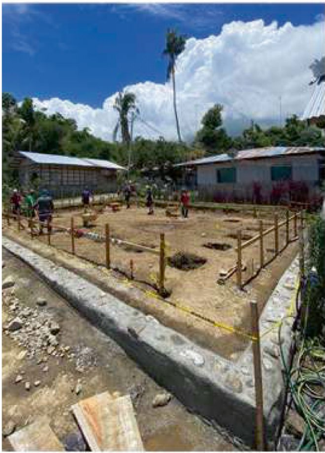
Abbildung 50: Aufstellung der Schutzwand
