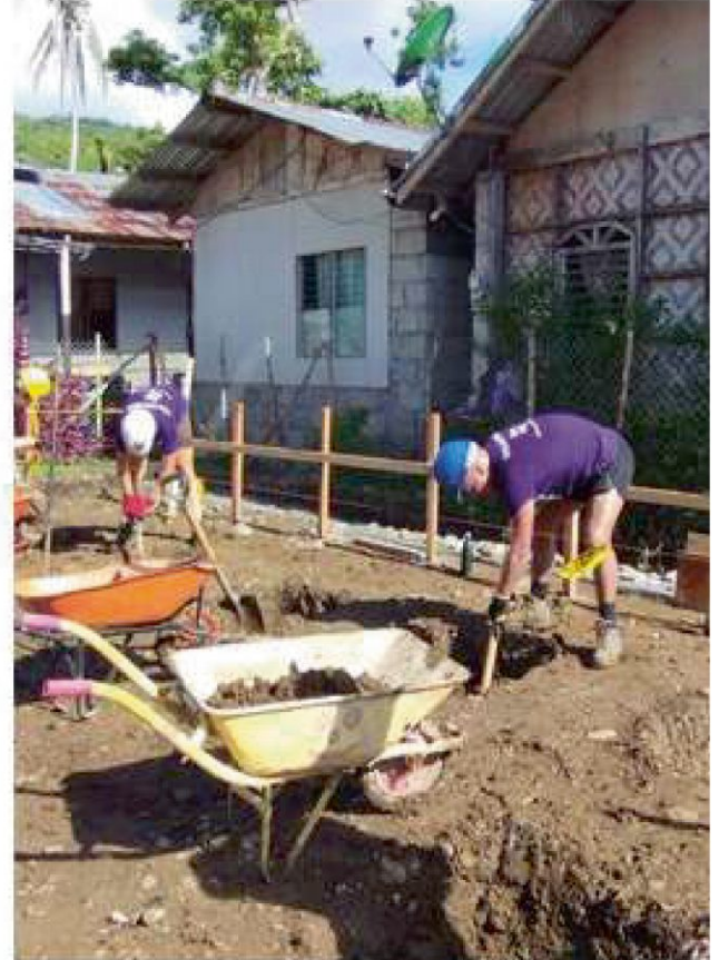
Abbildung 49: Ausgrabungen der Fundamente
