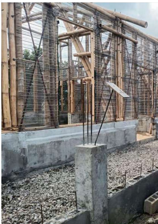
Abbildung 84: Stütze Laubengang - Rohbauzustand
