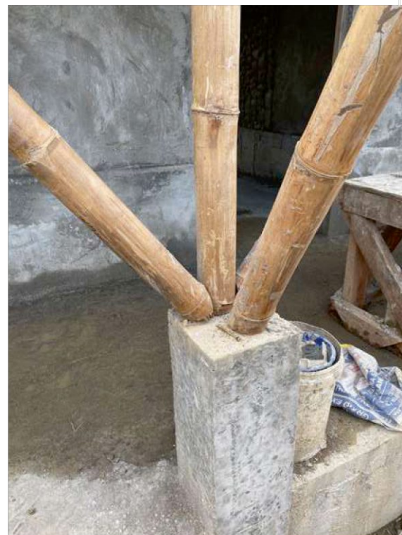
Abbildung 85: Stütze Laubengang - Rohbauzustand
