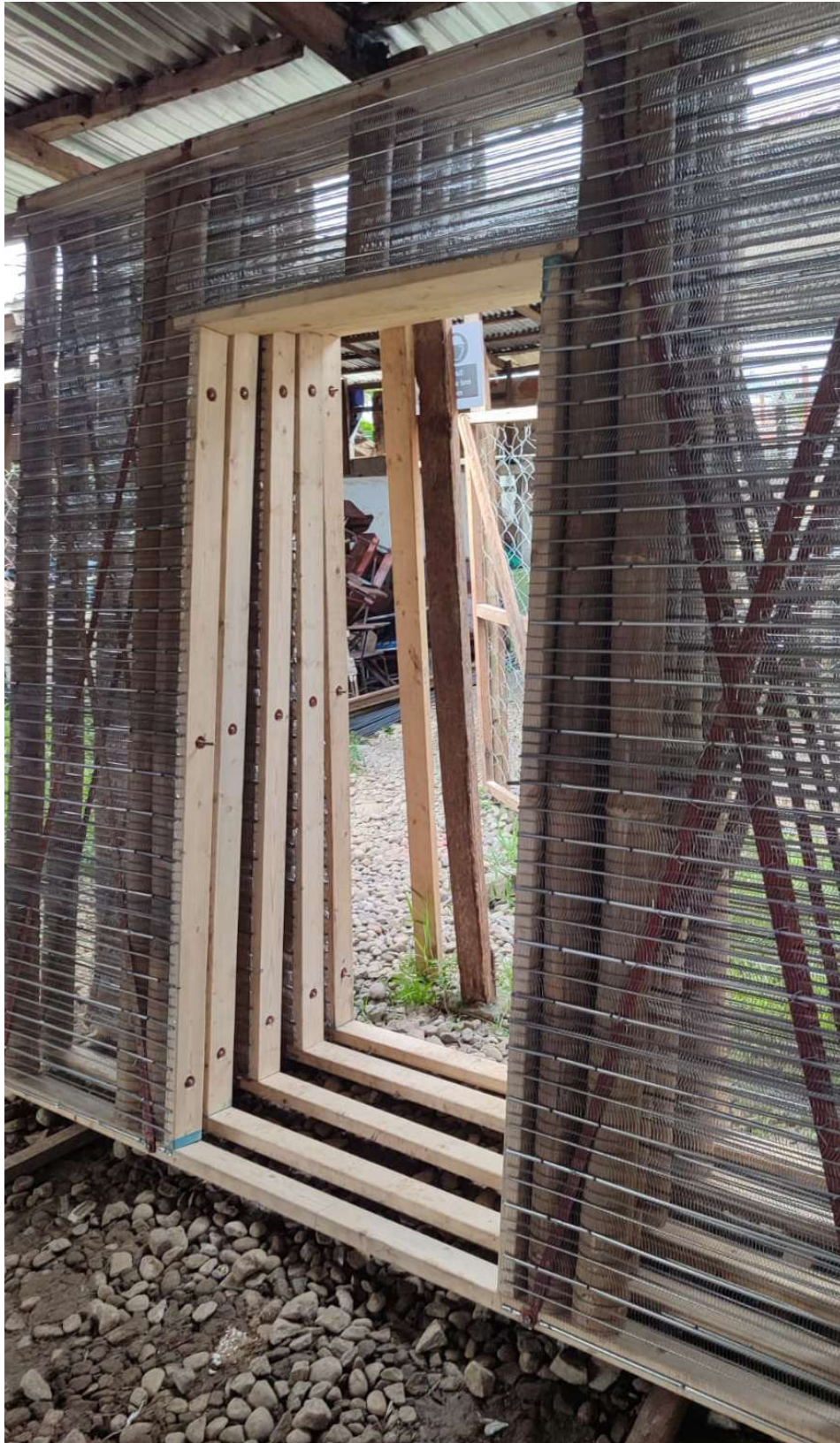
Abbildung 82: Vorgefertigte Wand (eigene Aufnahme)
