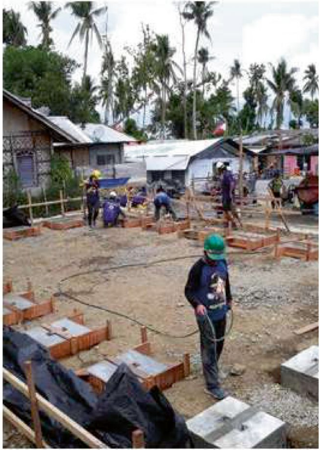
Abbildung 51: Fundamente gegossen
