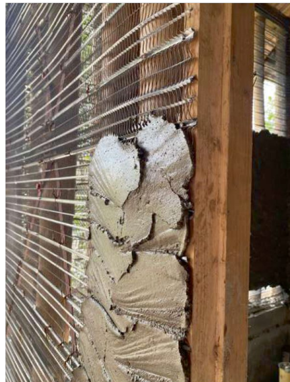
Abbildung 81: Putzgitter mit Zementputz
