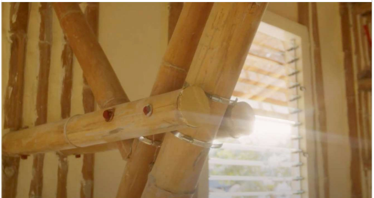
Abbildung 15: Verbindung CBFT (Eigene Aufnahme)
