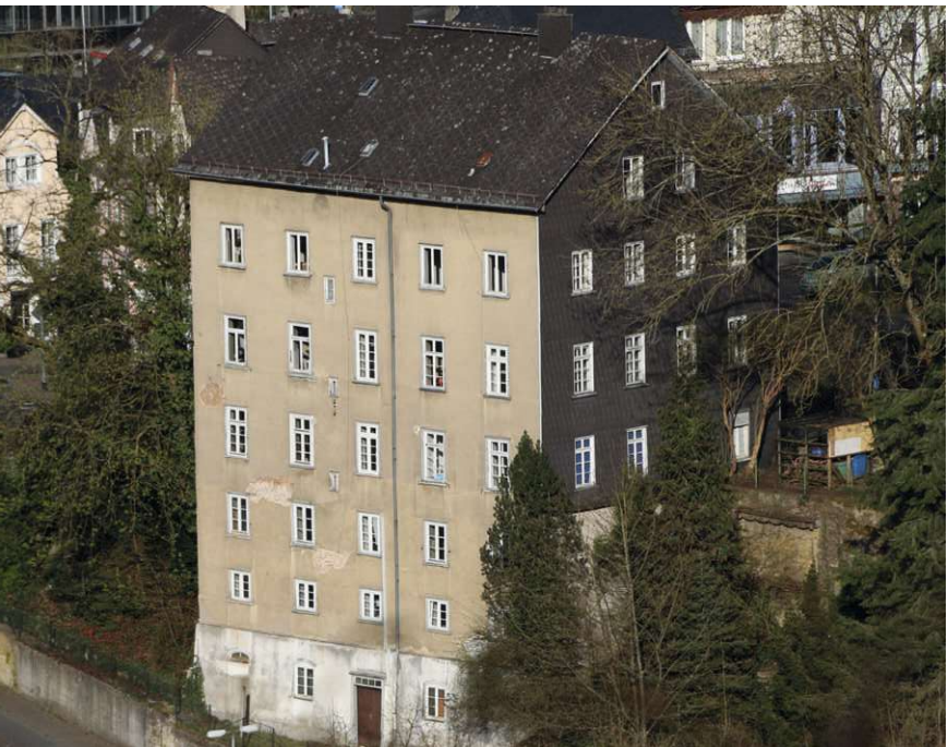
Abb. 07 - Pisé-Haus in Weilburg
