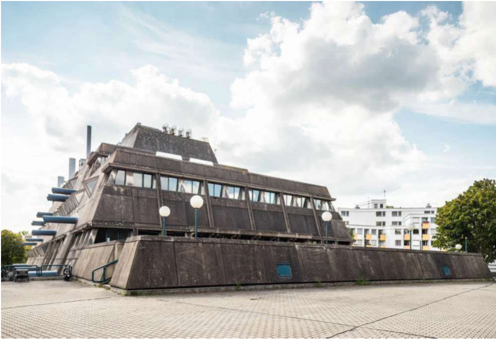
Abb.59 'Mäusebunker' mit Vorplatz, Felix Torkar.
