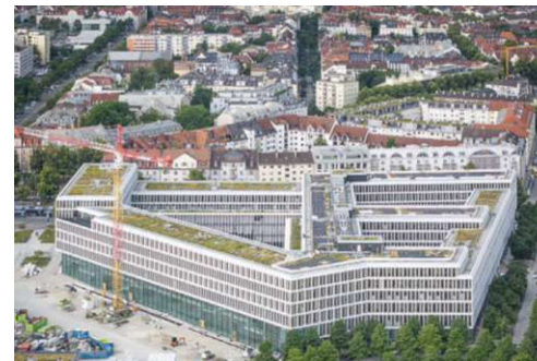
Abb.80 Ersatzneubau am Leonrodplatz, 2024.
