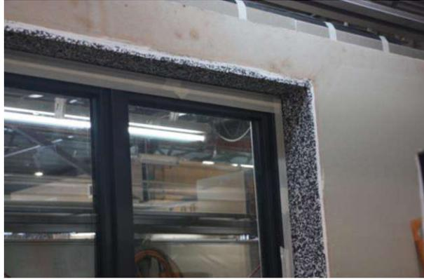
Abbildung 10 Fenstermontage im Werk am stehenden Wandelement (Quelle: eigene Aufnahme)
