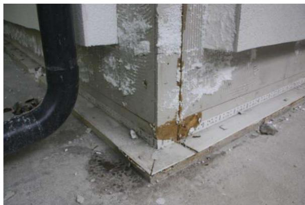
Abbildung 18 fehlende Fassadendämmung in den Anschlussbereichen (Quelle: eigene Aufnahme)
