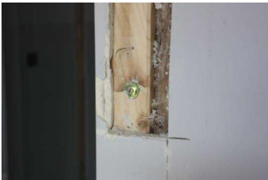
Abbildung 14 Verschraubung Wände hinter Beplankung (Quelle: eigene Aufnahme)
