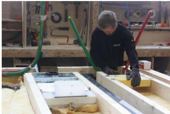
Abbildung 9 Montage Spülkasten inklusive. Verrohrung (Quelle: eigene Aufnahme)
