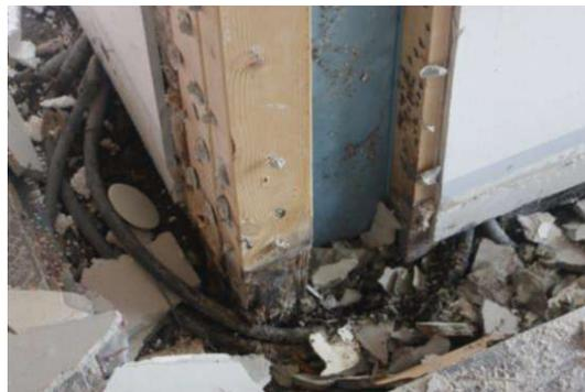
Abbildung 15 zerstörte Beplankung Innen für Demontage (Quelle: eigene Aufnahme)
