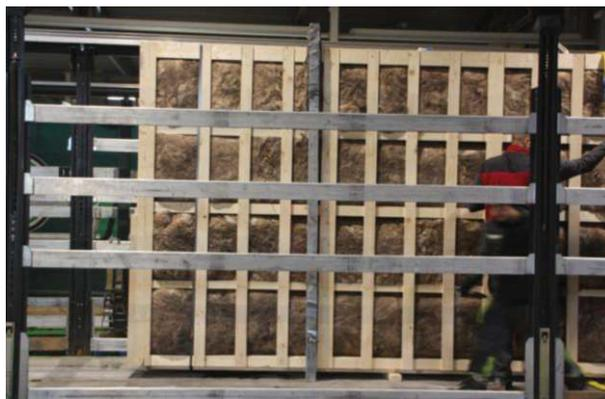
Abbildung 11 Deckenelemente beim Verladen auf den LKW (Quelle: eigene Aufnahme)
