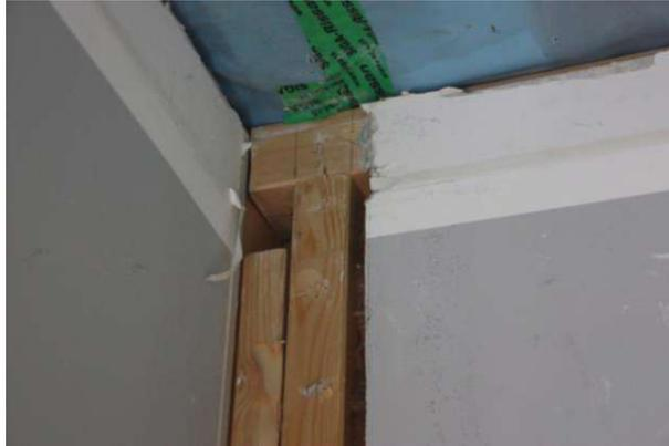
Abbildung 19 verstärkte Konstruktion im Anschlussbereich der Innenwand (Quelle: eigene Aufnahme)
