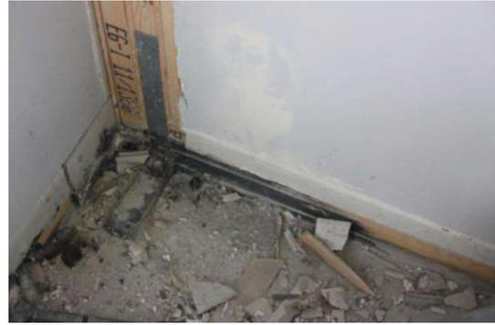
Abbildung 16 Montagewinkel Wand zu Bodenplatte (Quelle: eigene Aufnahme)
