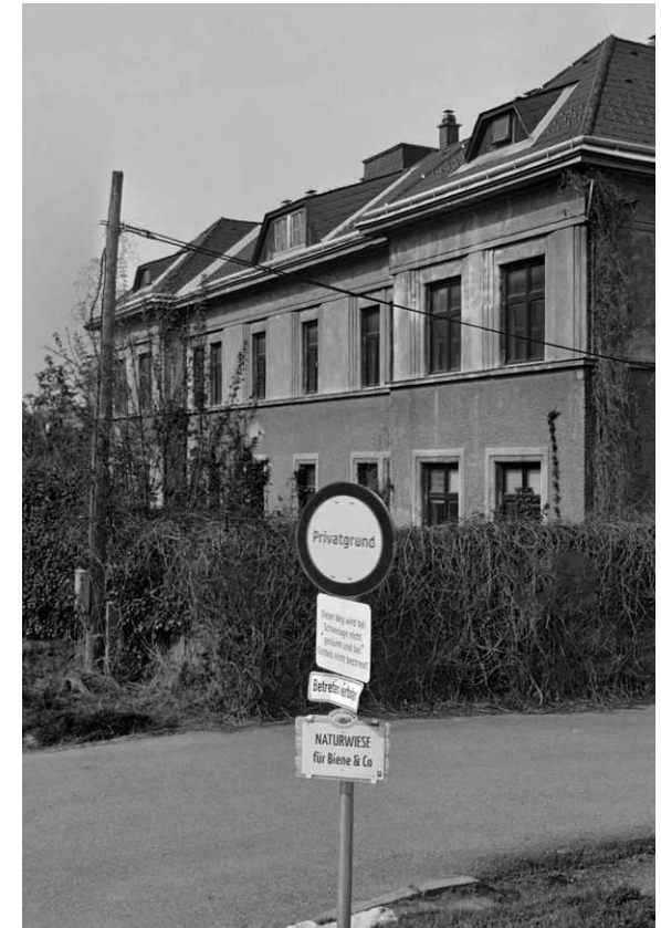
Abb. 74 : Unterkünfte-Gebäude im Kasernenareal
