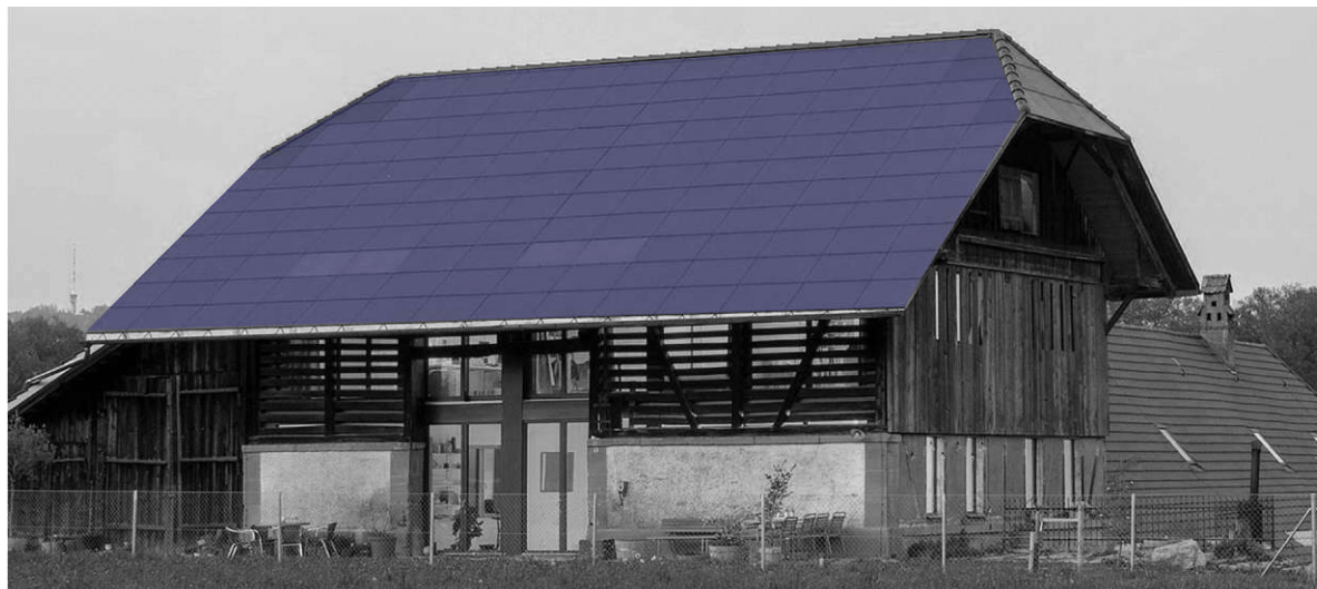
Abb. 51: Altes Bauernhaus mit PV-Anlagen auf dem Dach
