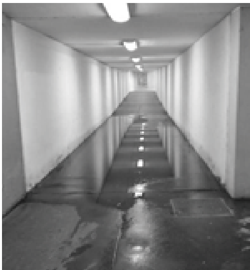
Abb. 39: Unterführung bei Bahnhof Weidling
