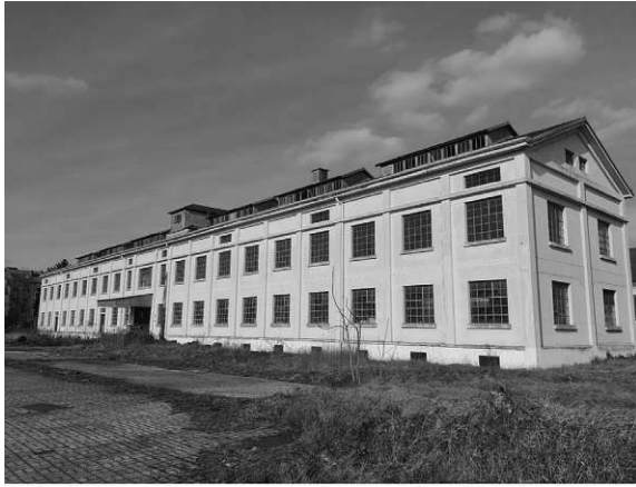
Abb. 60: Das alte Lager- und Werkstättengebäude
