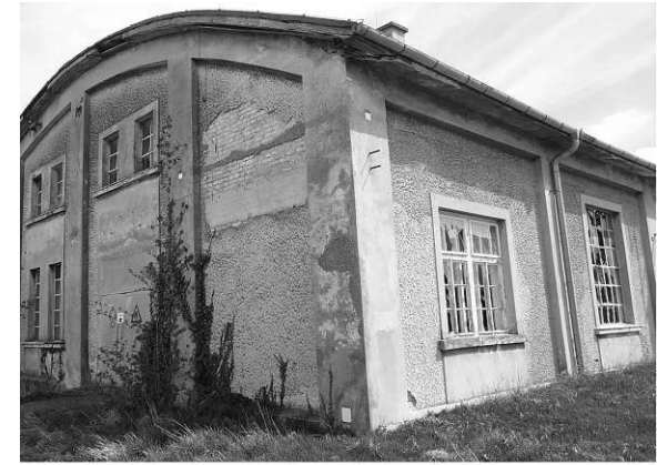
Abb. 62: Das alte Lagerhalle
