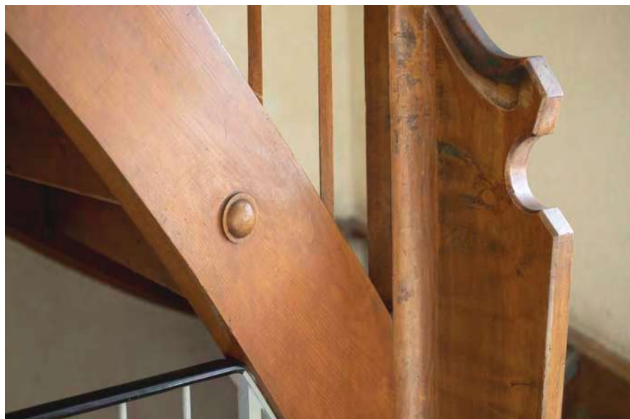
Detail der bauzeitlichen Treppe zu den Wohngeschossen (Abb. 203).
