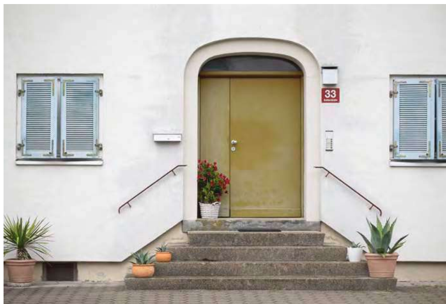
Eingangssituation mit Pyramidentreppe beim Objekt Kehlerstraße 33 (Abb. 119).
