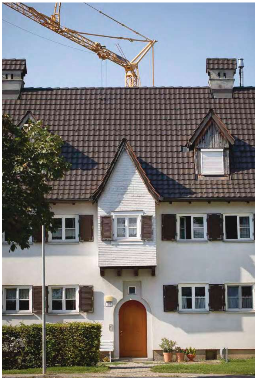
Objekt Heimkehrerstraße 13 (Abb. 92).
