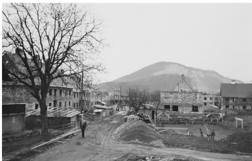
Die Anlage im Bau, ca. 1941 (Abb. 179).
