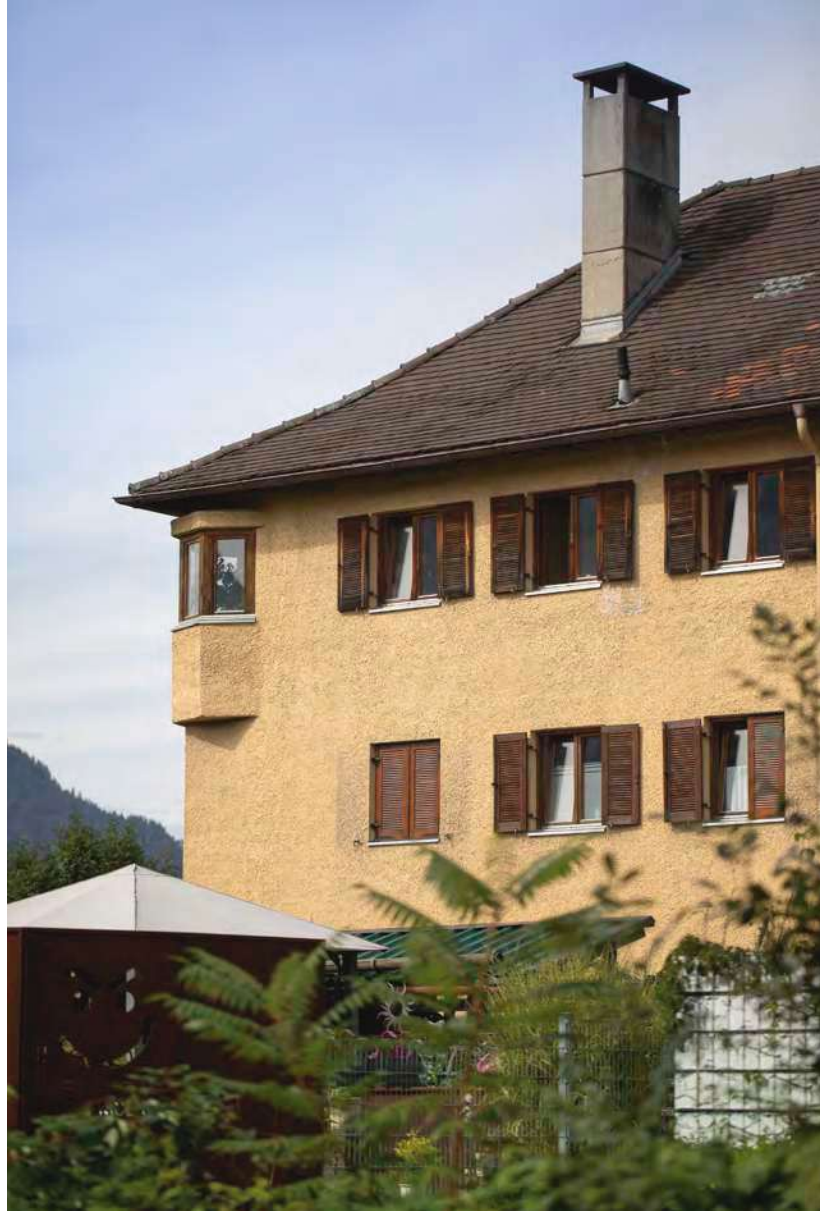
Eckerker beim Gebäude Boznerstraße 18 (Abb. 241).
