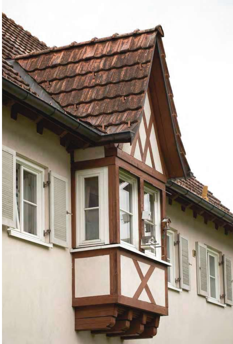
Erker mit Sichtfachwerk und Giebedach (Abb. 122).
