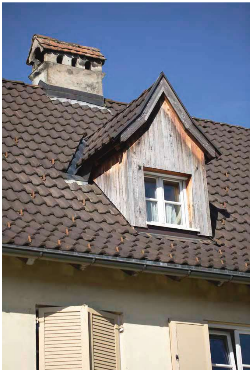
Holzverschalte Giebelgaube mit geknicktem Dach (Abb. 8o).
