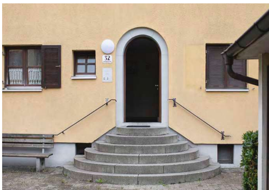
Eine kegelförmige Außentreppe führt zum Objekt Langegasse 32 (Abb. 105).
