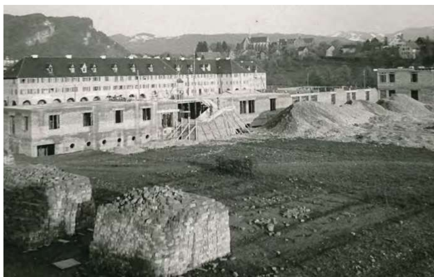
Foto der Baustelle für die Volks- und Hauptschule Rieden-Vorkloster mit der Siedlung Schendlungen im Hintergrund, 1950er Jahre (Abb. 41).
