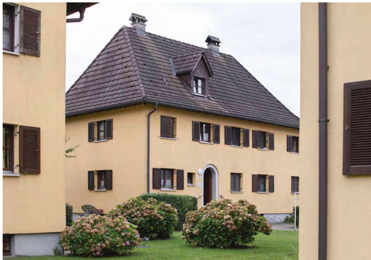
Das Objekt Lanegasse 32 ist das einzige Gebäude mit Walmdach (Abb. 110).
