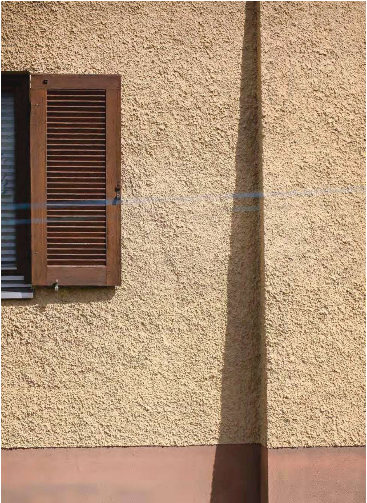
Wand- bzw. Fassadendetail mit akzentuierter Gebäudeecke (Abb. 245).
