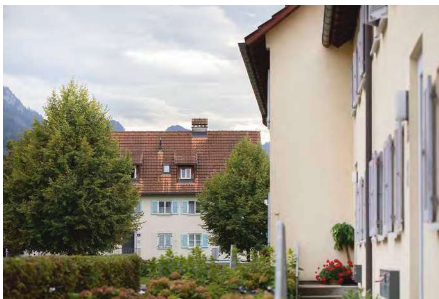
Blick Richtung Negrellistraße 12 (Abb. 143).
