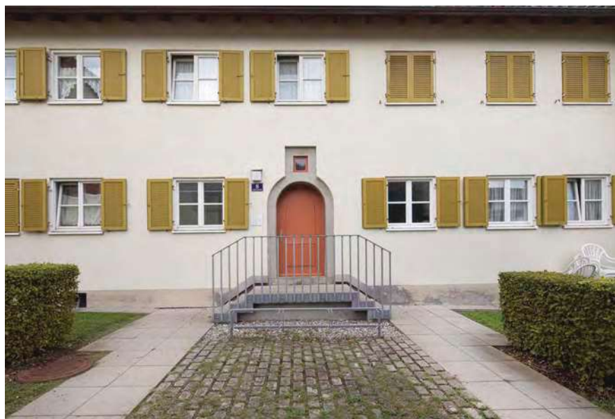
Eingangssituation beim Haus Laurinweg 8 (Abb. 20).
