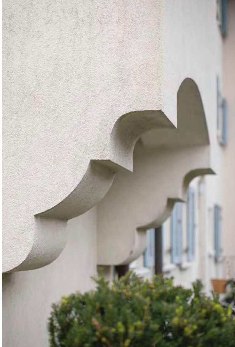
Detail der Erkerkonsole des Objekts Eisplatzgasse 38 (Abb. 123).
