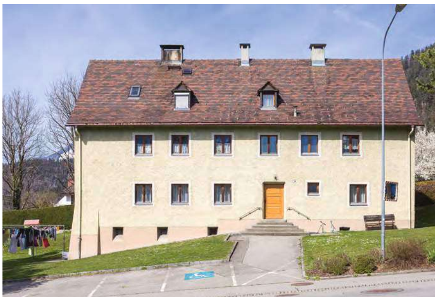
Das Objekt Sankt-Antoniusstraße 19 vor der Sanierung (Abb. 250).
