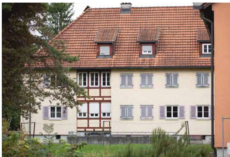
Loggia mit Sichtfachwerk (Abb. 139).
