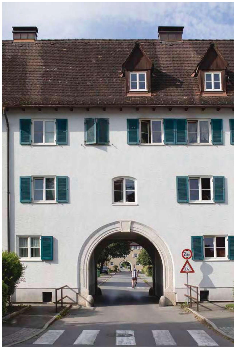
Blick durch die Durchfahrt am Südtirolerplatz in Richtung Achgasse (Abb. 31).
