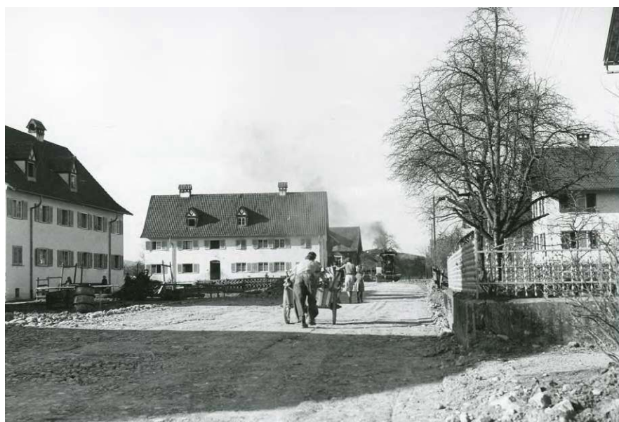
Ausbau Montfortstraße auf Höhe der Südtiroler Siedlung, 1955 (Abb. 195).
