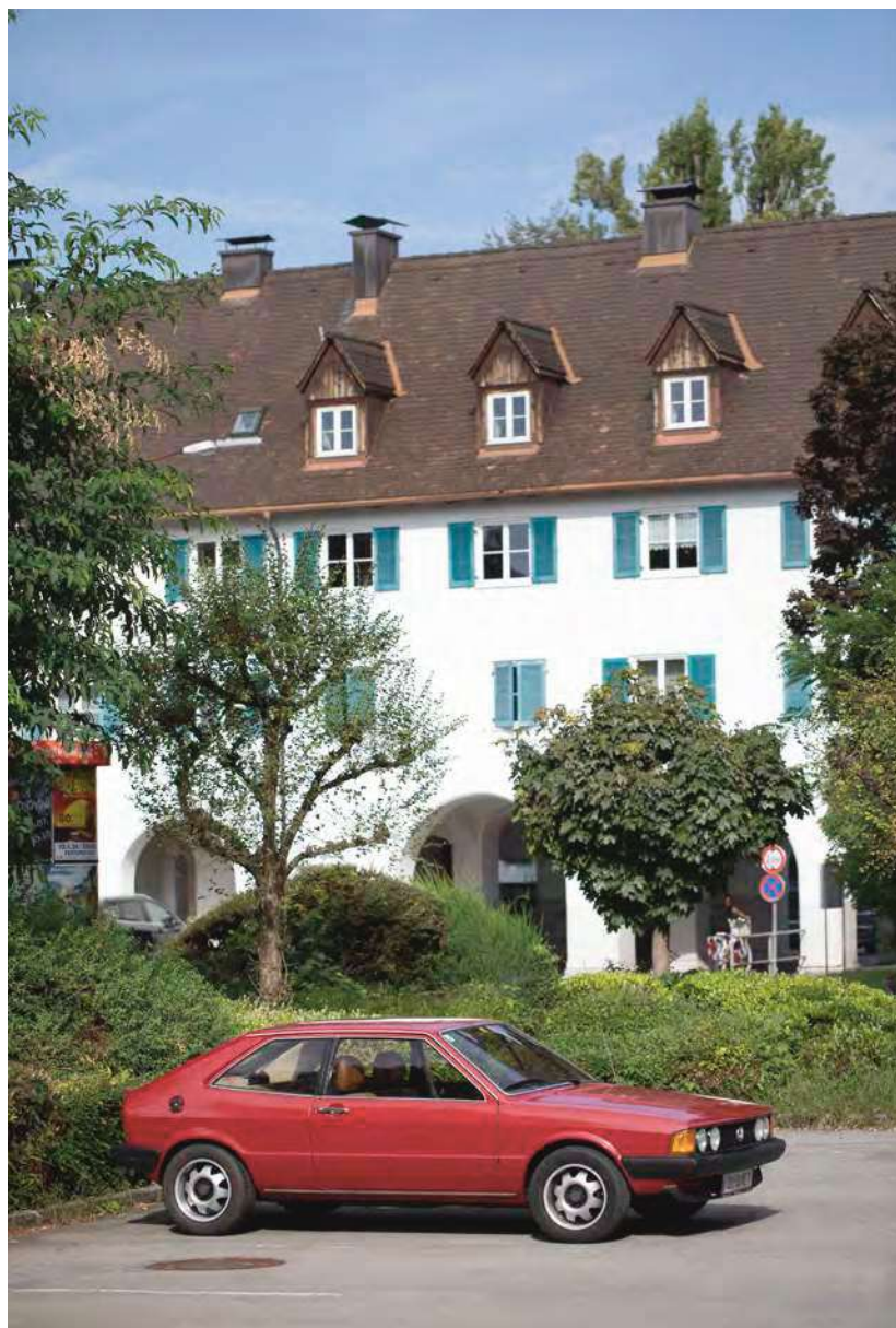
Blick vom Objekt Südtirolerplatz 1 (Abb. 32).
