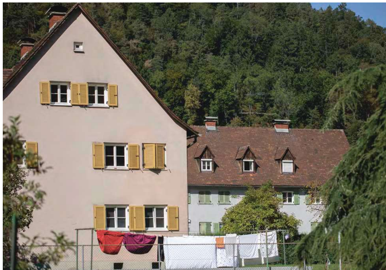
Giebelseite des Objekts Waltergasse 4 mit Blick auf die Zeile Waltergasse 3, 5 und 7 (Abb. 216).
