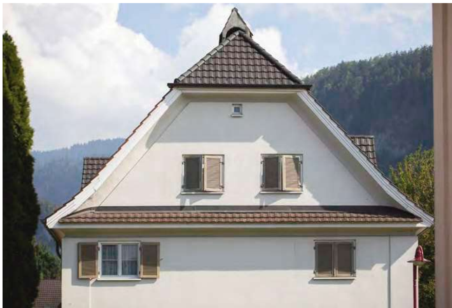
Giebel- und Giebelfußgesims beim Objekt Neue Siedlung 10 (Abb. 186).
