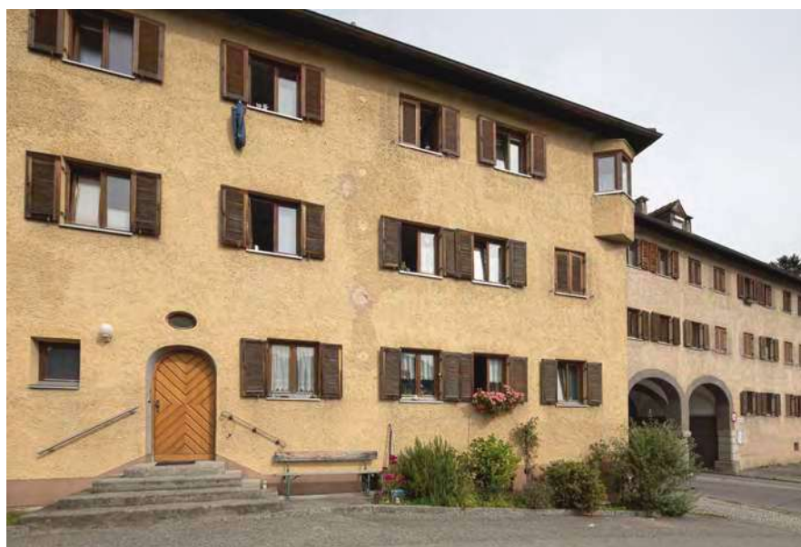
Eingangssituation des Objekts Boznerstraße 2 (Abb. 243).
