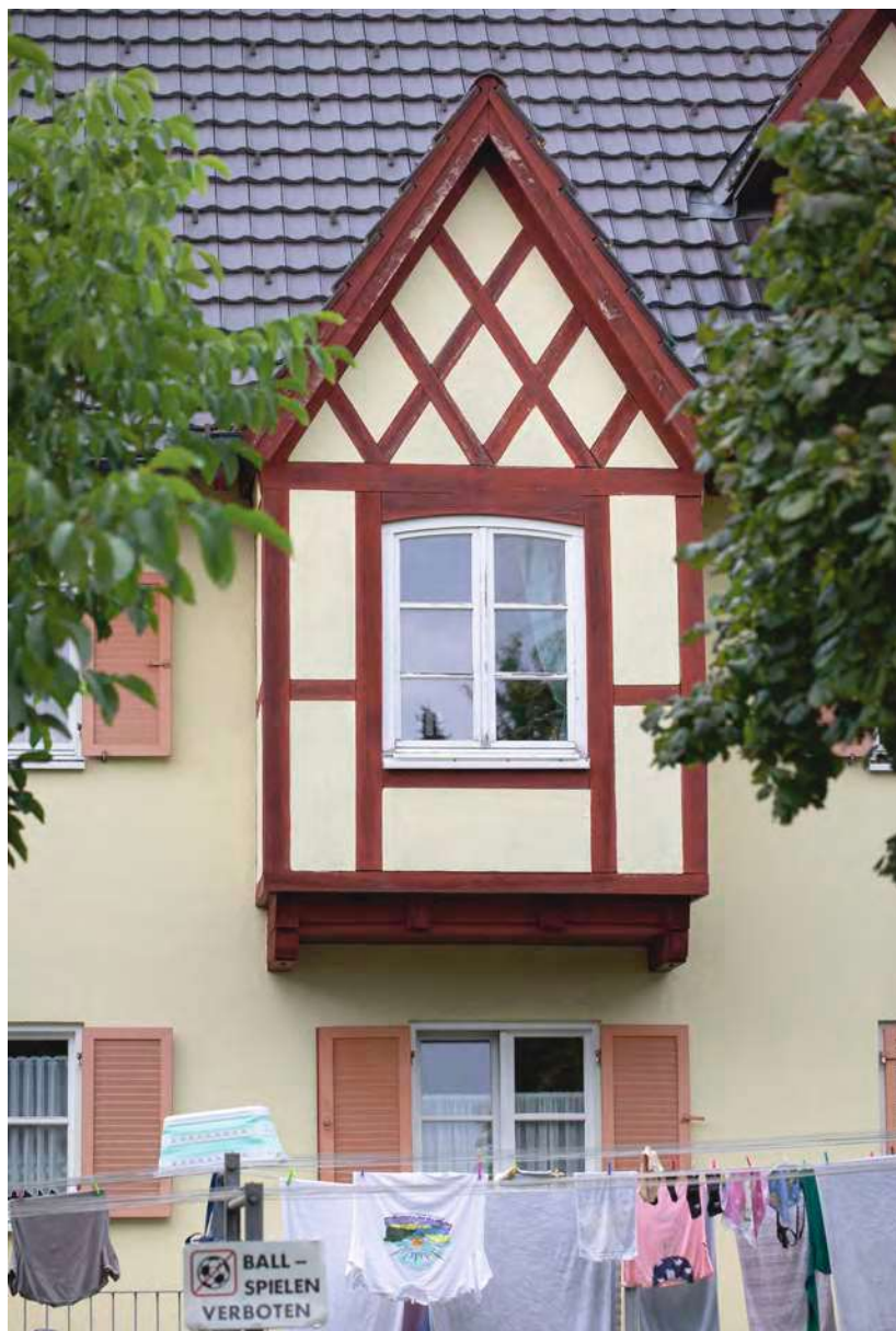
Zwercherker mit Sichtfachwerk beim Objekt Toni Russ Straße 1 (Abb. 18).
