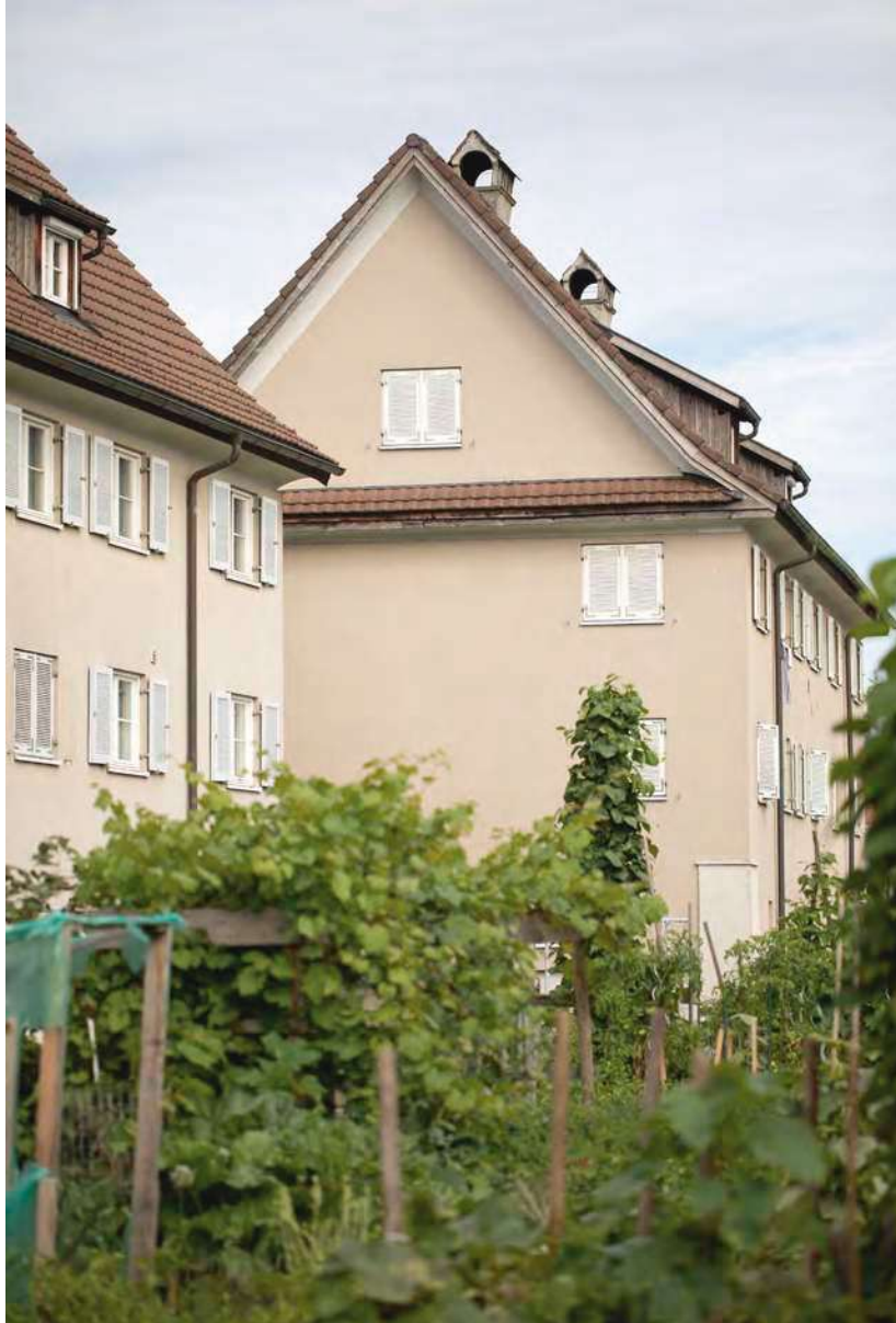
Besonders markant an den Traufseiten sind die Giebel- und Giebelfußgesimse (Abb. 71).
