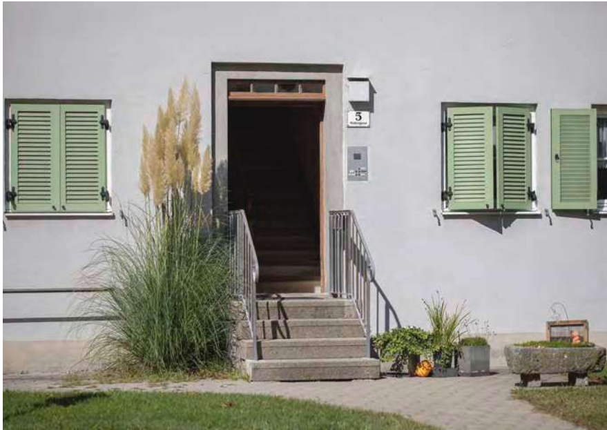
Eingangssituation beim Objekt Waltergasse 5 (Abb. 214).
