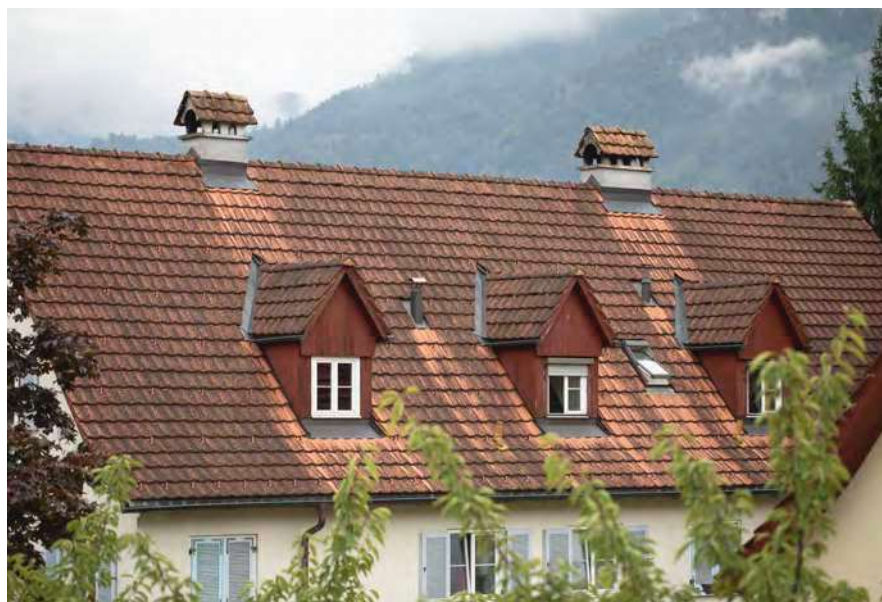
Die Holzschalung der Gauben wurde mit einem roten Anstrich akzentuiert (Abb. 138).
