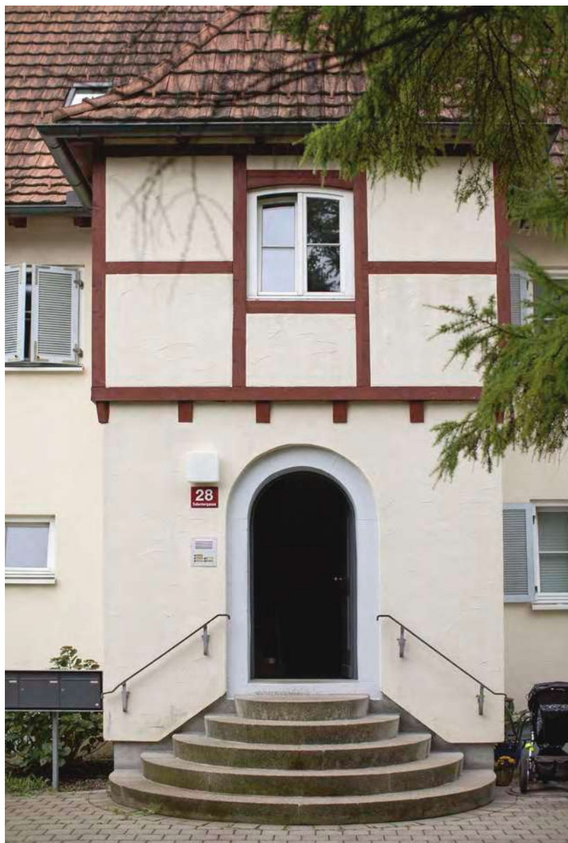
Risalit mit Sichtfachwerk, Walmdach, Kegeltreppe und Rundbogentür beim Objekt Salurnergasse 28 (Abb. 145).
