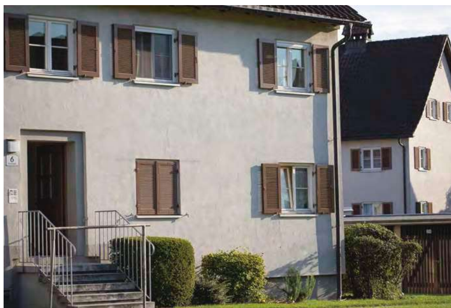
Einläufige Außentreppe zum Eingang des Objekts Im Dreieck 6 (Abb. 155).
