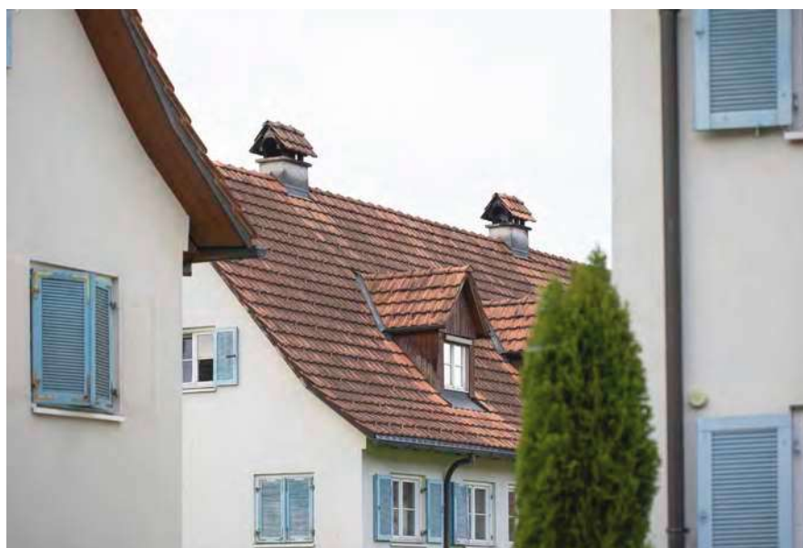
Die Zwerchhäuser wurden mit einer Holzschalung versehen (Abb. 120).
