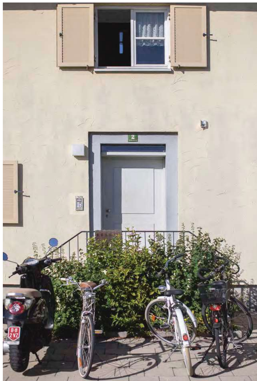
Eine doppelarmige Treppe führt zum Hauseingang (Abb. 79).
