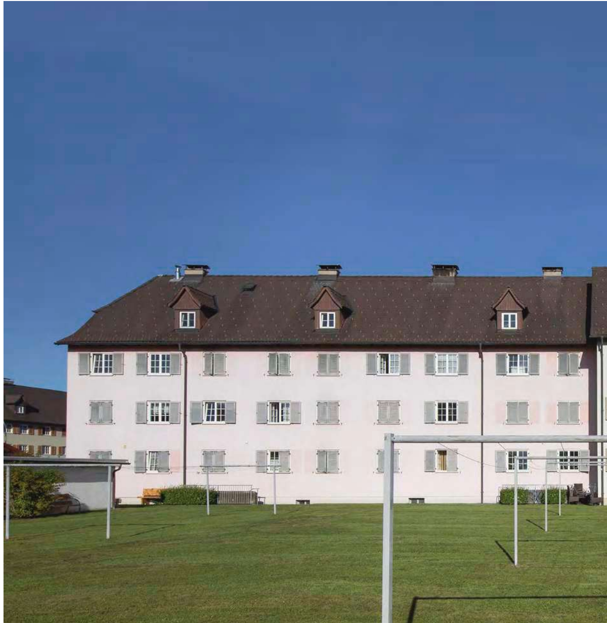
Die Rückseite der Objekte Michael-Gaismayr-Straße 20, 22 und 24 (Abb. 50).
