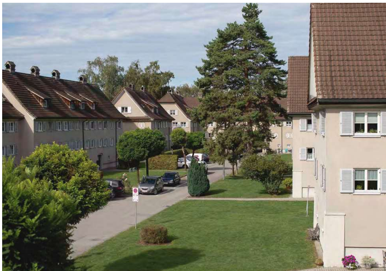
Blick durch die Anlage. Ein weiteres besonderes Gestaltungsmerkmal sind die Eckklisenen, welche im Bereich der Kellergeschosse noch gut ersichtlich sind. (Abb. 74).
