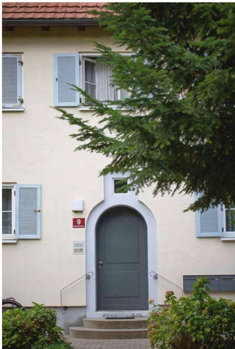
Eingangssituation beim Objekt Negrellistraße 9 (Abb. 140).
