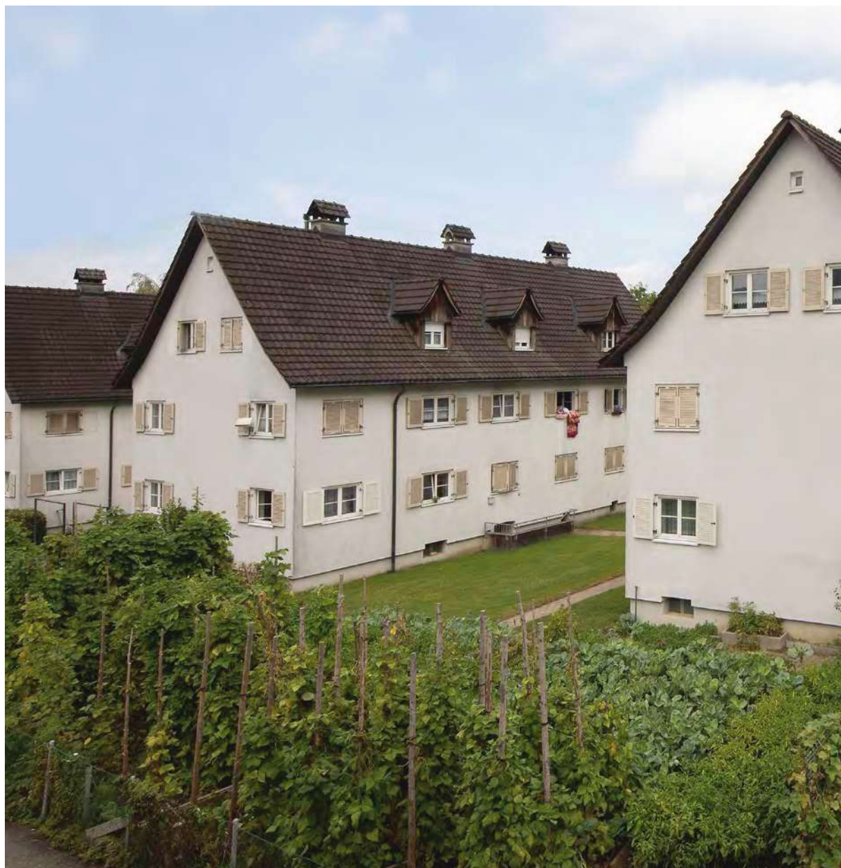
Die Siedlung zeigt sich insgesamt sehr einheitlich (Abb. 173).
