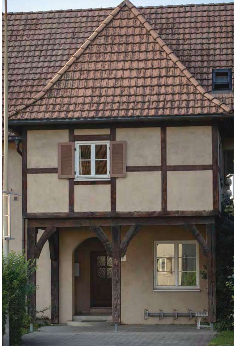
Der identitätsstiftende Vorbau des Objekts Brückengasse 12 (Abb. 158).
