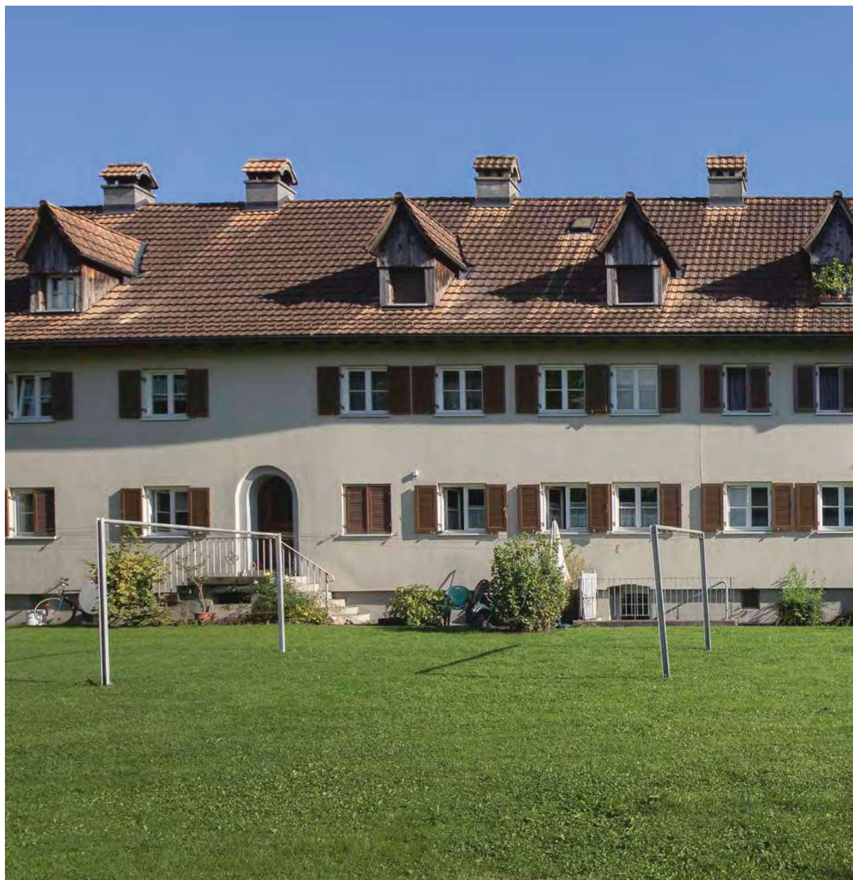
Die Rückseite der Gebäude der L-förmigen Zeile Schoren 5 und 9 (Abb. 159).
