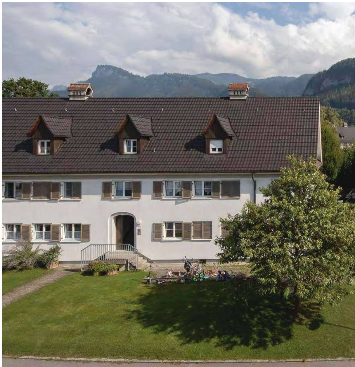
Blick auf die beiden Objekte Neue Siedlung 12 und 14 (Abb. 185).
