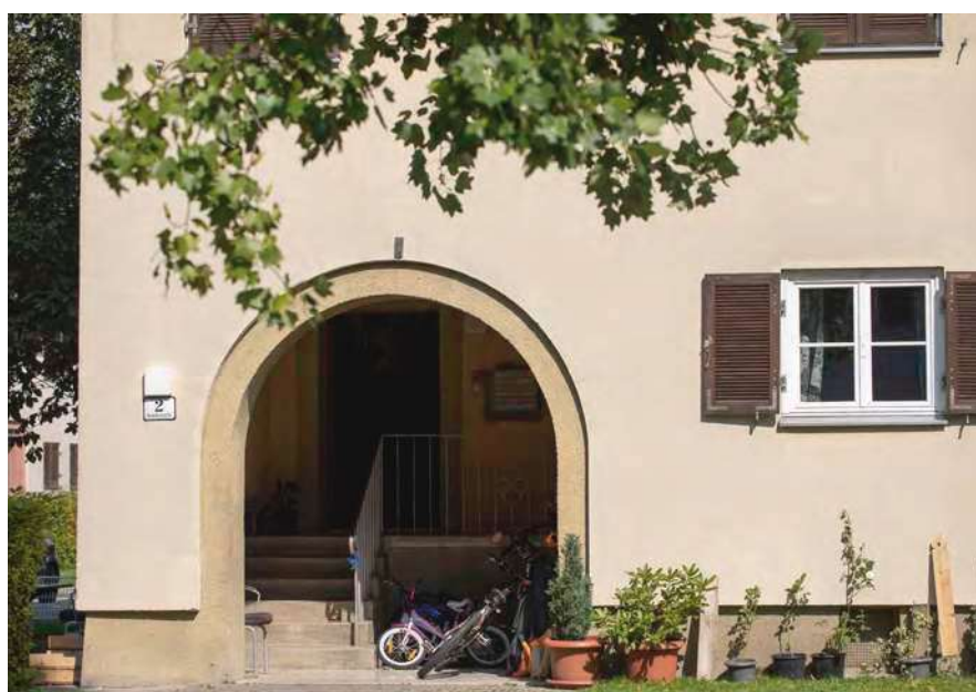
Besondere Zutrittssituation beim Objekt Heimkehrerstraße 2 (Abb. 94).
