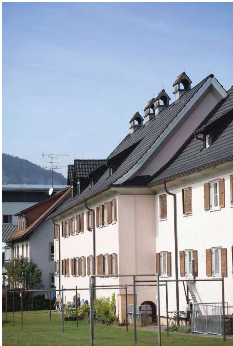
Blick auf die Gebäuderückseite der versetzt angeordneten Baukörper Neue Siedlung 7 und 9 (Abb. 184).
