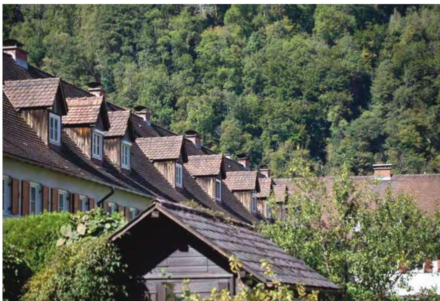
Die Dachlandschaft der Hofbebauung (Abb. 212).
