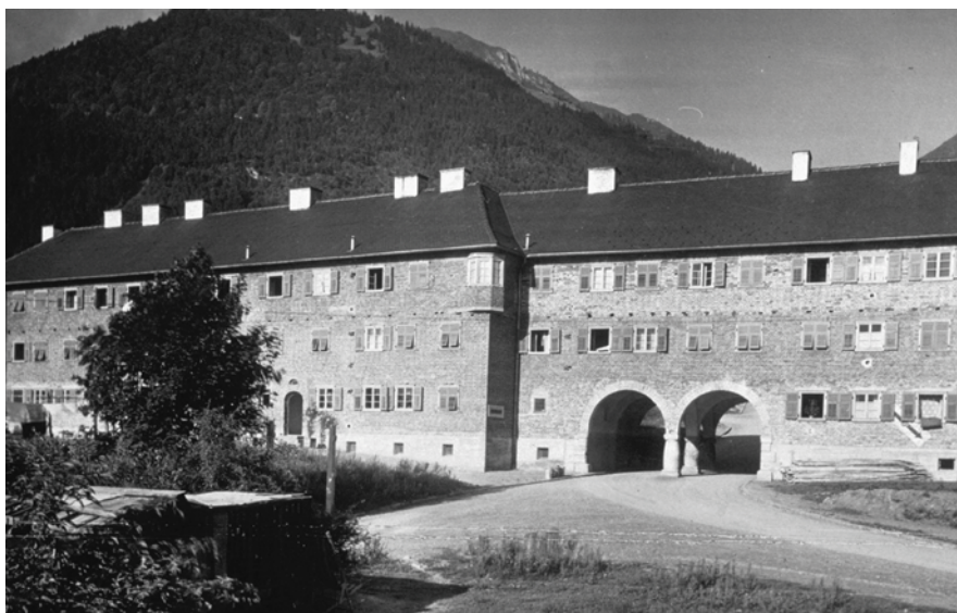
Aufnahme der unverputzten Zeile in der Sankt-Antonius-Straße 1 bzw. 2, undatiert (Abb. 236).
