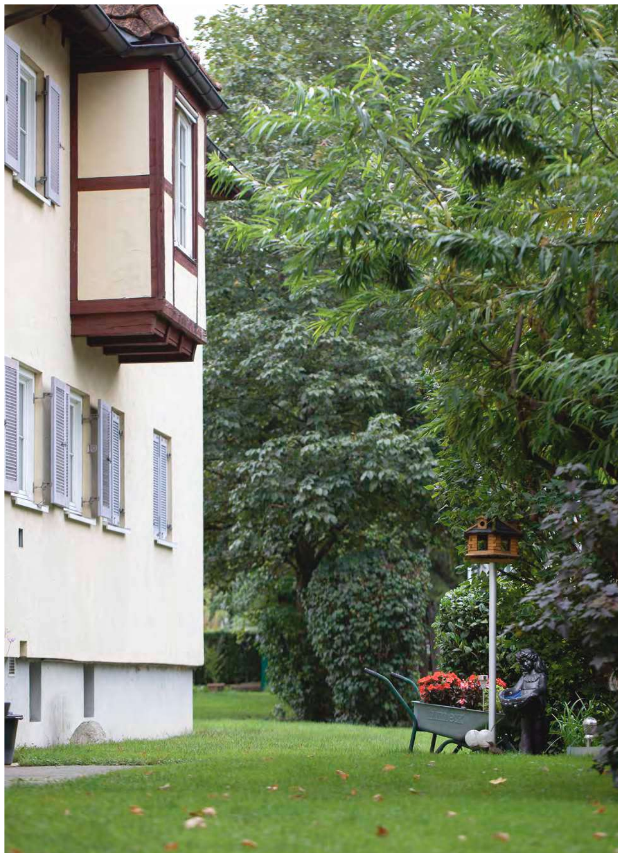
Zwercherker mit Sichtfachwerk und Walmdach (Abb. 144).
