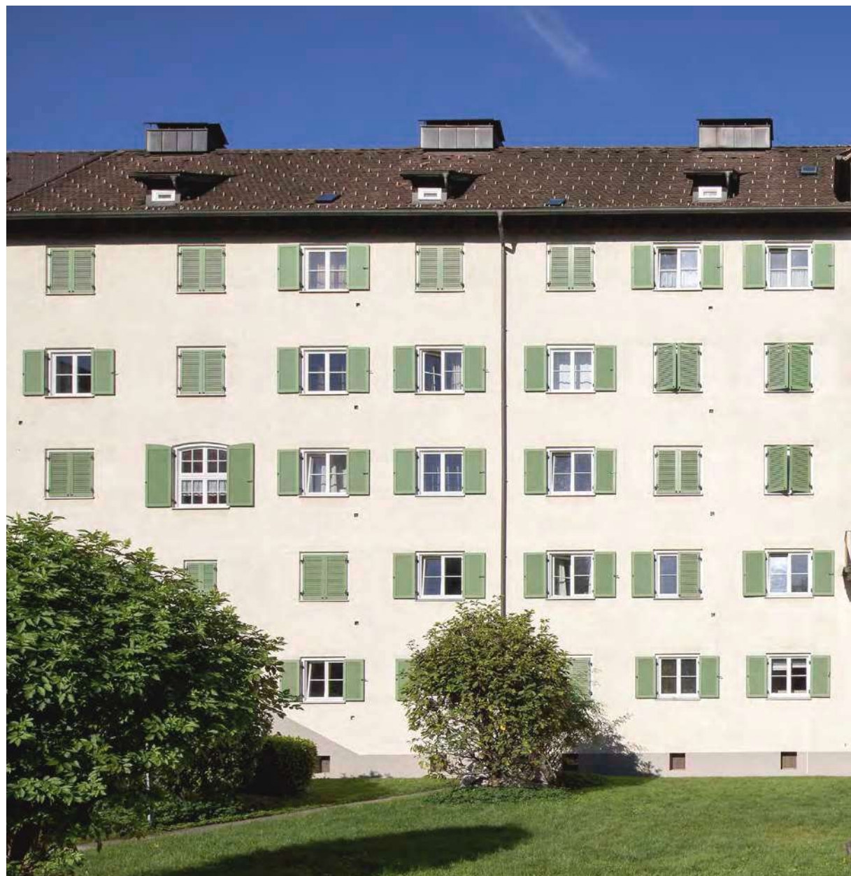
Ansicht vom Innenhof auf die Rückseite des Objekts Liechtensteiner Straße 15 (Abb. 223).
