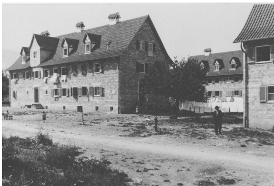
Die bereits bewohnte, noch unverputzte Siedlung Rüttensch Abb. 100).
