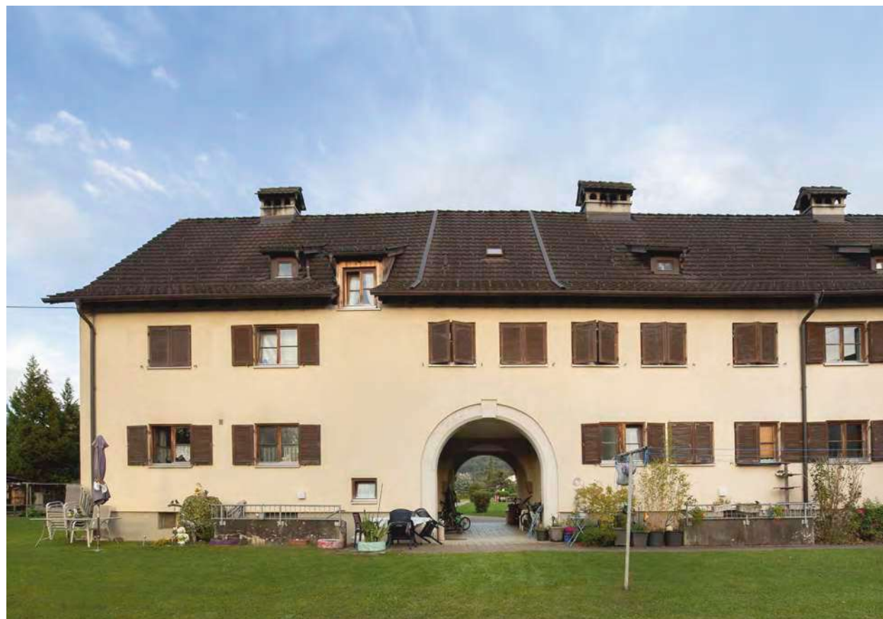
Blick von der Rückseite auf den Durchgang des Objekts Südtirolerstraße 10 (Abb. 202).
