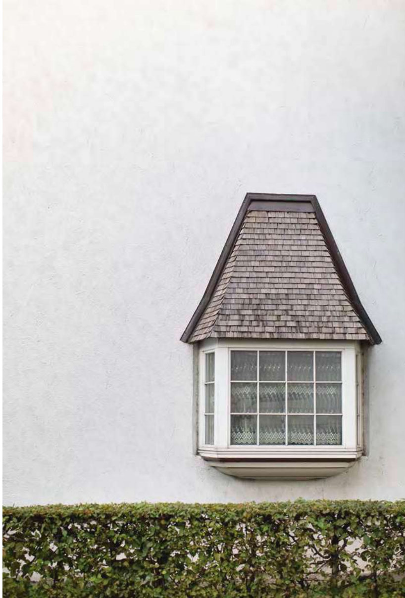
Der mit Holzschindeln gedeckte Fenstererker an der Giebelseite des Objekts Reutegasse 1 (Abb. 55).
