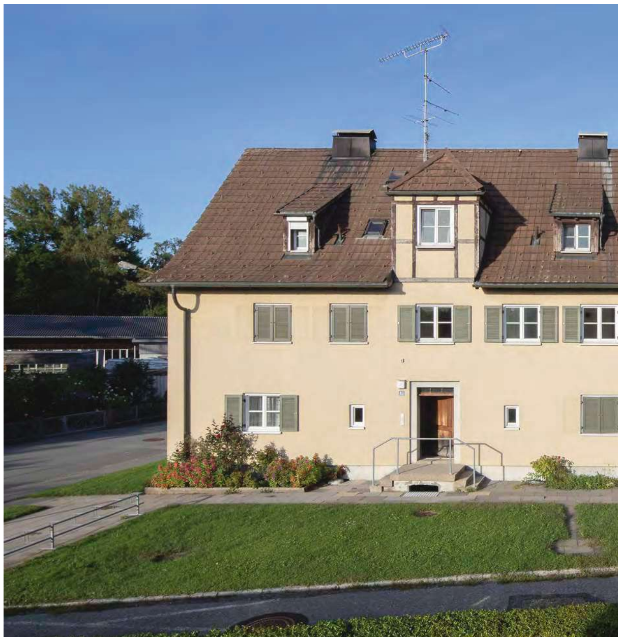
Das Objekt Achstraße 40 bzw. 42 (Abb. 62).
