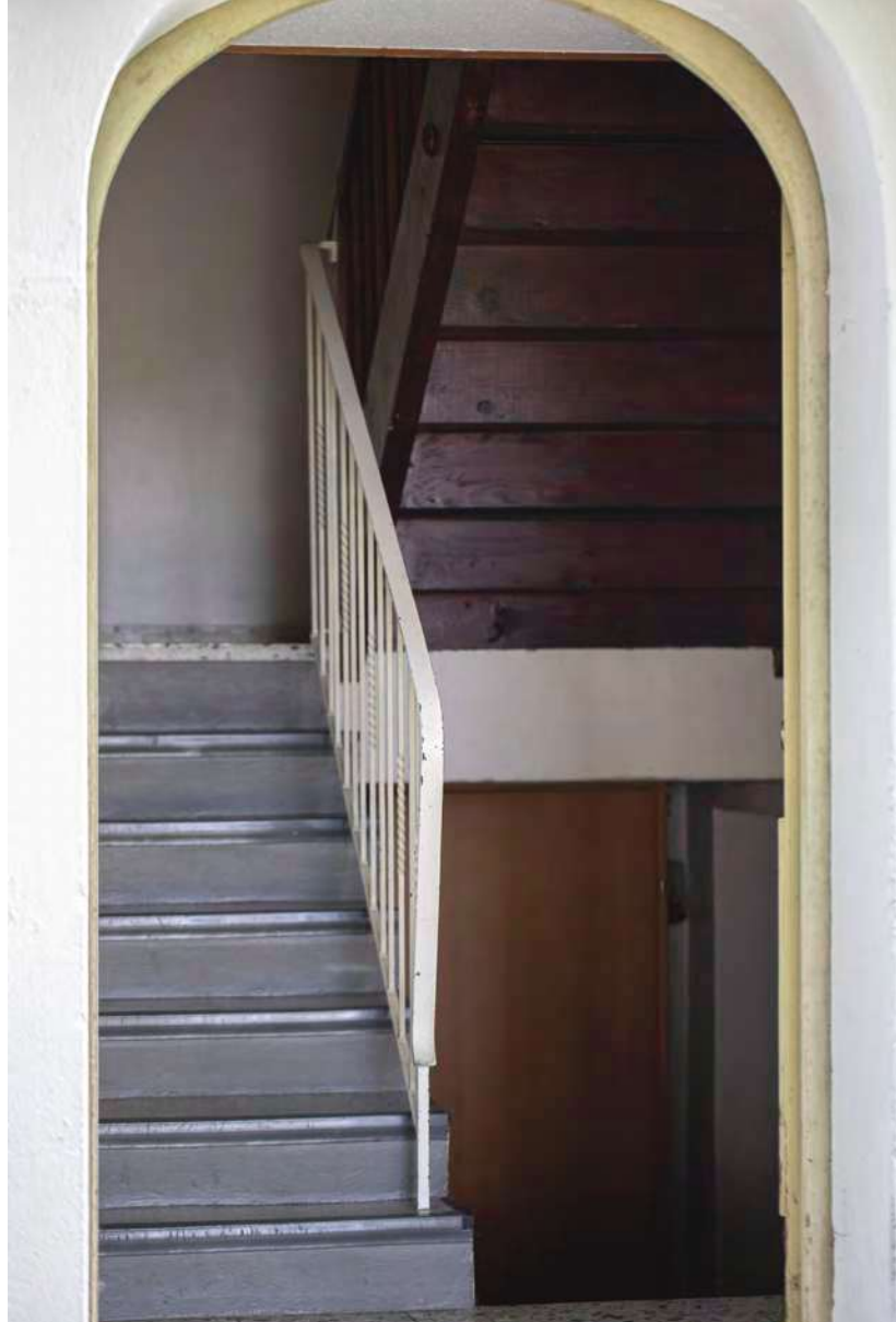
Blick in das Stiegenhaus des Gebäudes Walther-von-der-Vogelweidestraße 21(Abb. 172).
