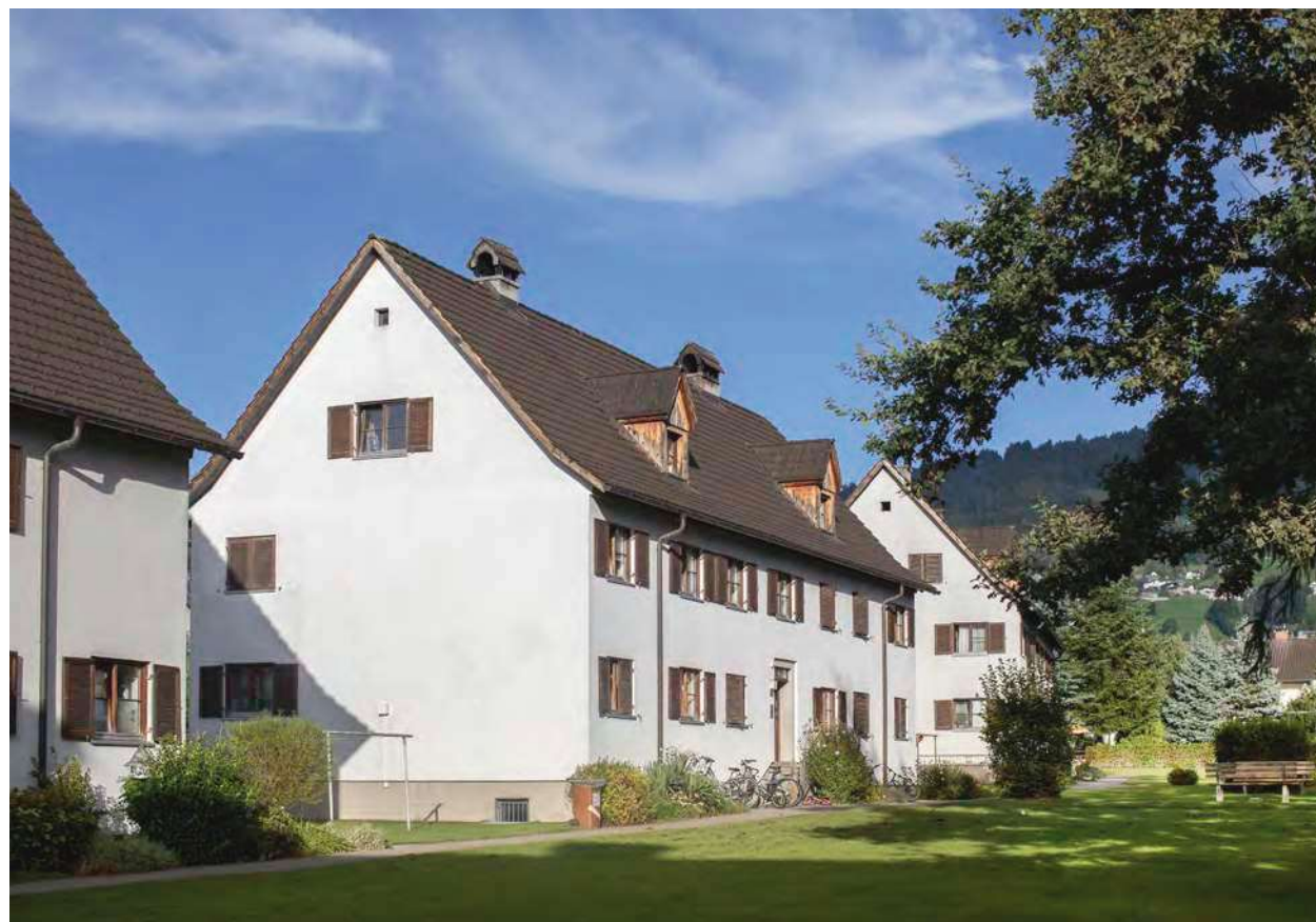
Blick in Richtung Montfortstraße (Abb. 205).
