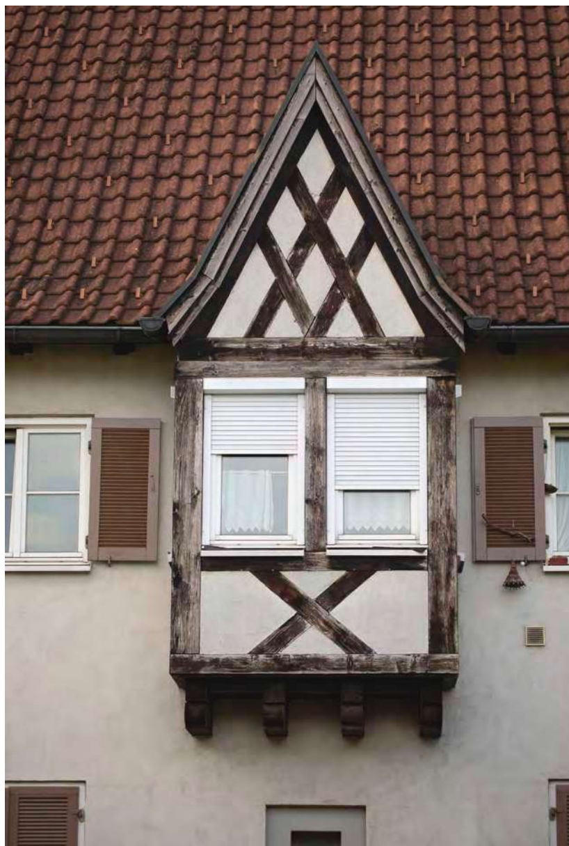
Zwercherker mit Giebeldach und Sichtfachwerk (Abb. 157).
