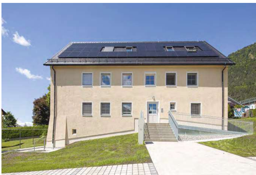
Das Objekt Sankt-Antoniusstraße 19 nach der Sanierung (Abb. 251).
