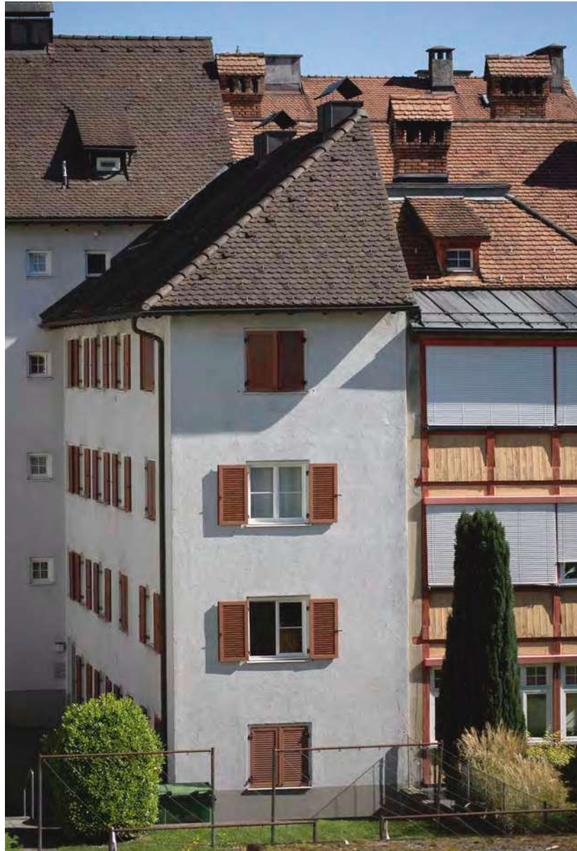
Objekt Gilmstraße 7 (Abb. 224).
