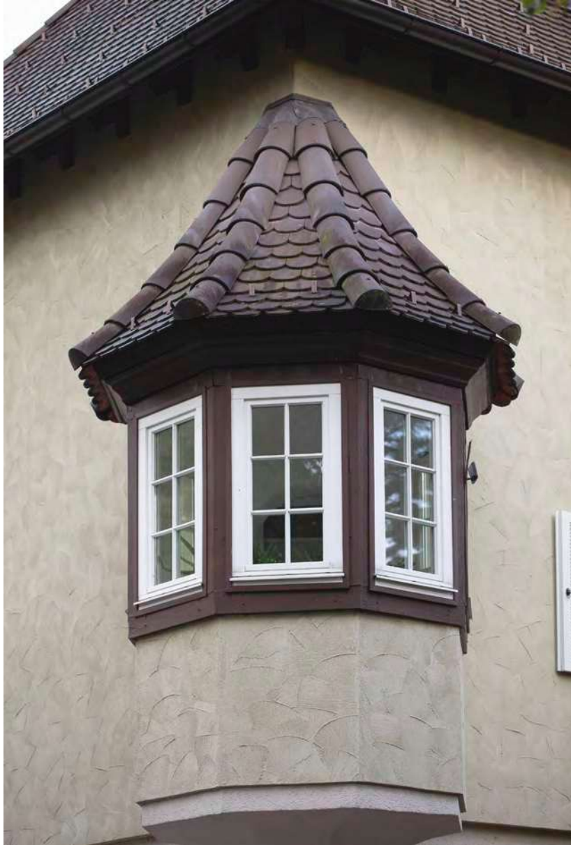
Eckerker mit polygonalem Grundriss und ziegelgedecktem Dach beim Objekt Michael-Gaismayr-Straße 5 (Abb. 52).
