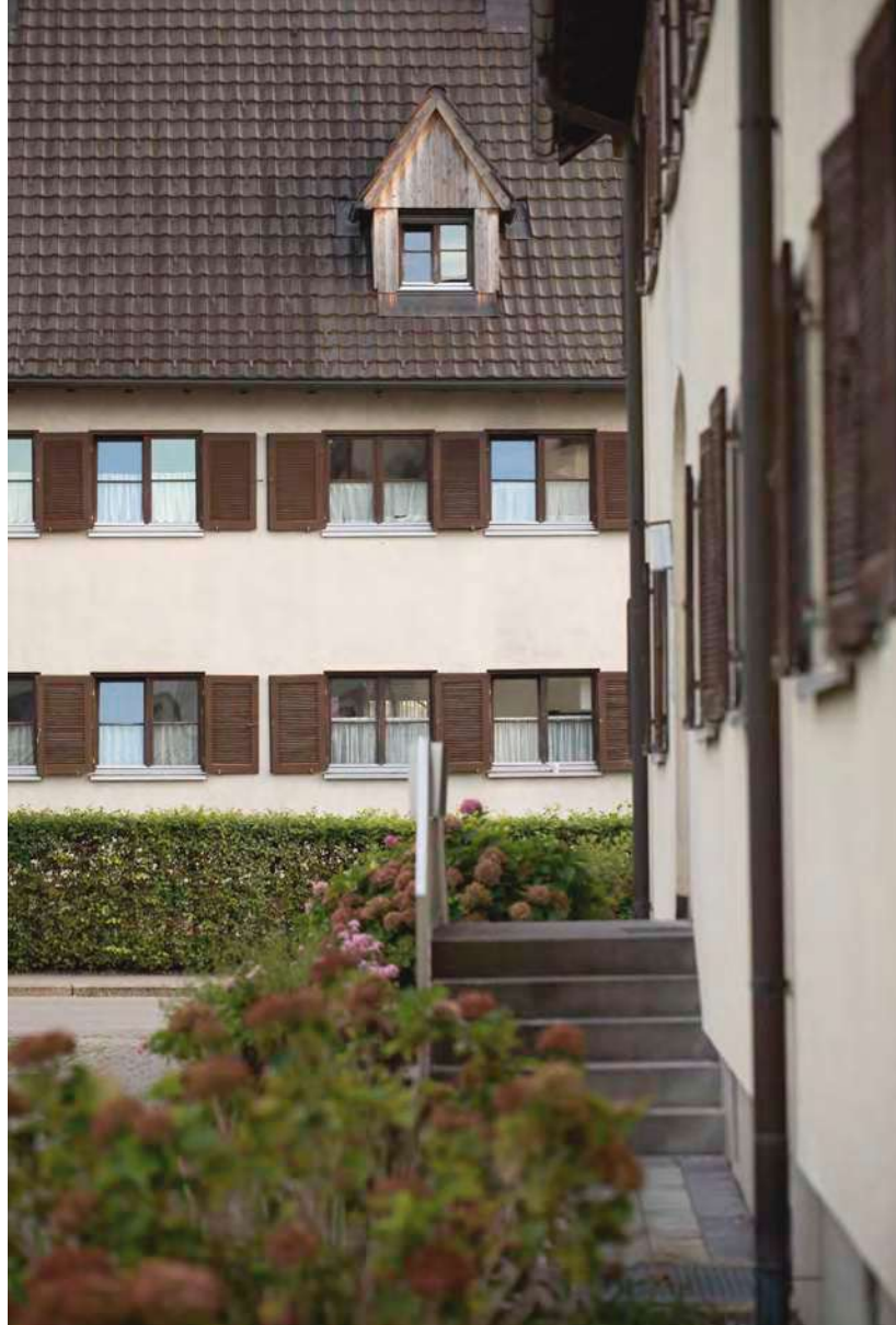
Eingangssituation beim Objekt Südtirolerstraße 10 mit Blick auf das Objekt Südtirolerstraße 6 bzw. 7 (Abb. 199).
