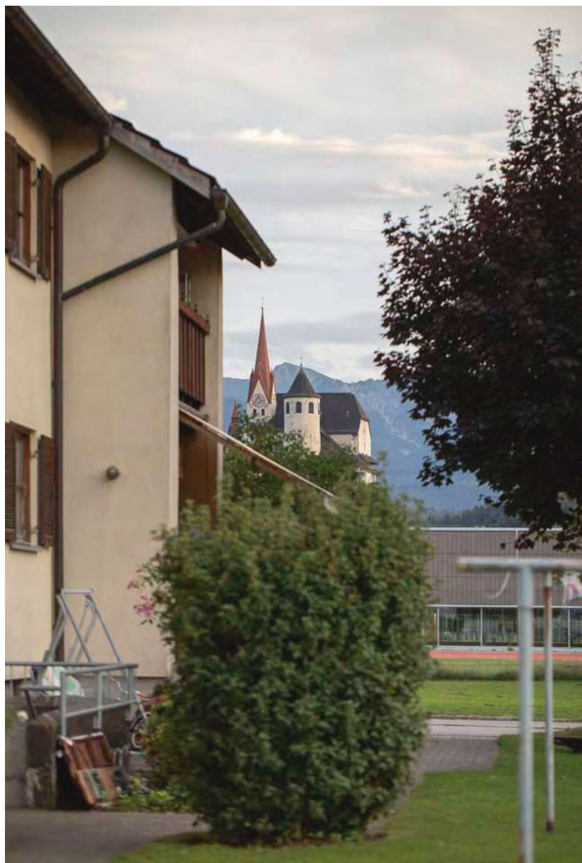
Loggia und Terrasse auf der Rückseite des Gebäudes Südtirolerstraße 10 (Abb. 200).
