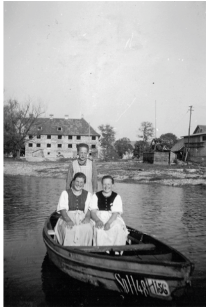
Blick vom See auf das damalige Haus 1 und 2, ca. 1944/45 (Abb. 67).
