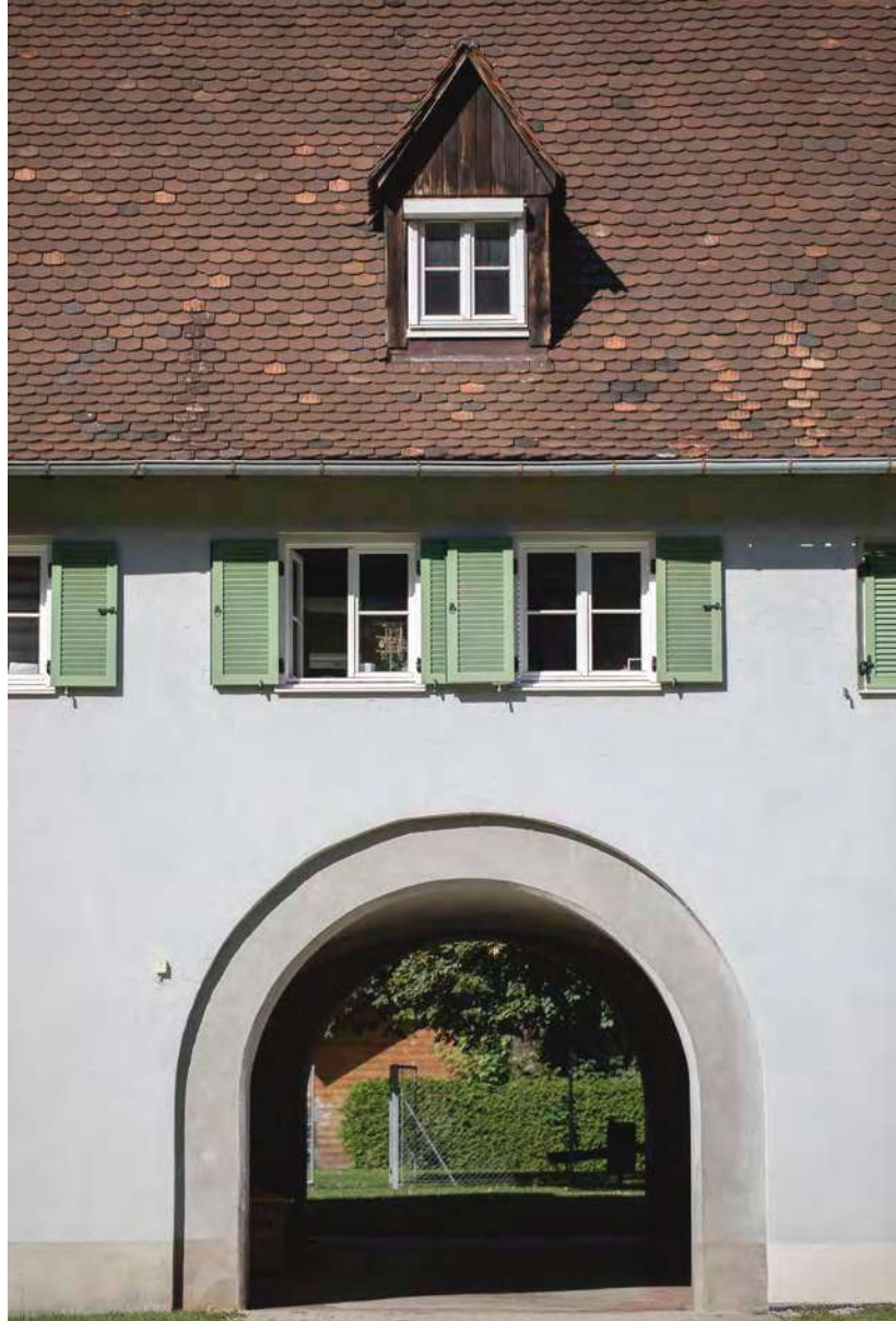
Bogendurchgang bei den Objekten Vogelweiderplatz 4 bzw. 5 mit Blick in den Innenhof (Abb. 215).
