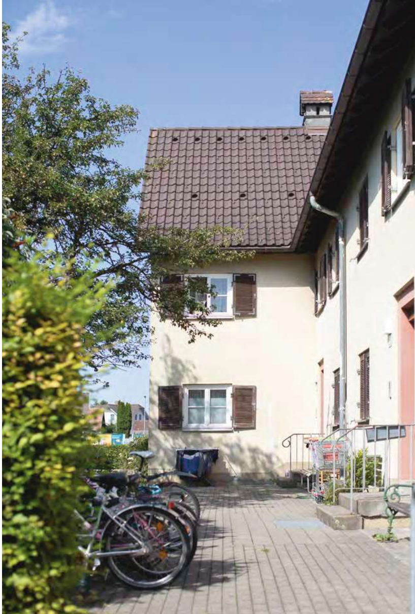
Eingangssituation beim Objekt Bahnhofstraße 16 bzw. 16 a (Abb. 91).
