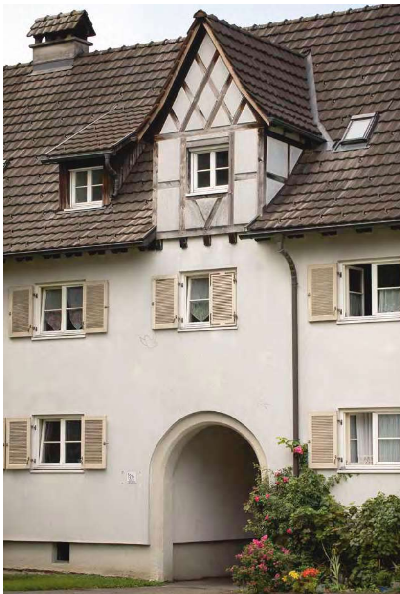
Bogendurchgang mit Zwischhaus beim Objekt Walter-von-der-Vogelweidestraße 24 und 26 (Abb. 169).
