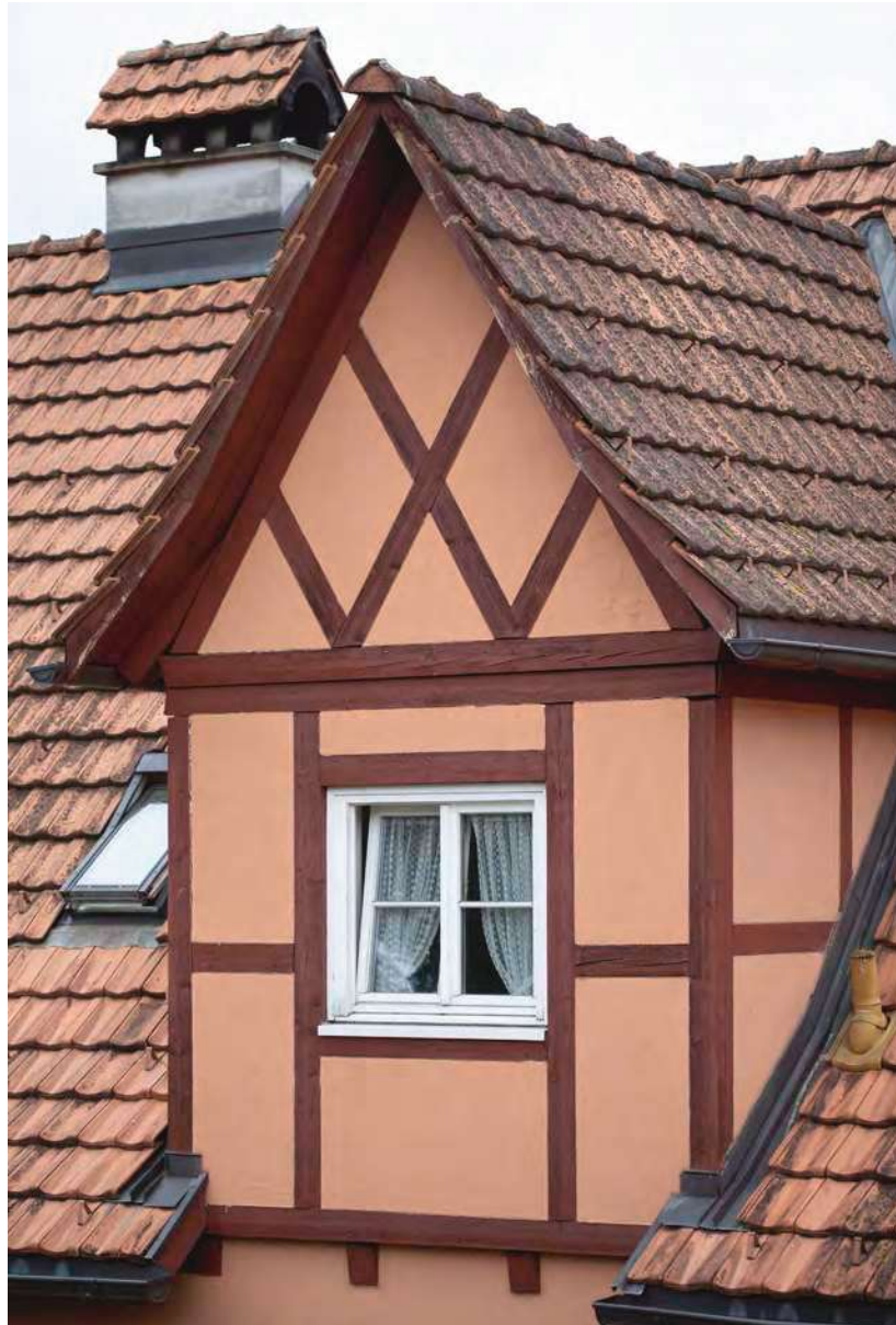
Zwerchhaus mit Sichtfachwerk (Abb. 137).
