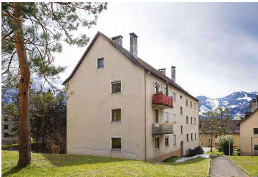
Das Objekt Sankt-Antoniussstraße 12a vor der Sanierung (Abb. 248).
