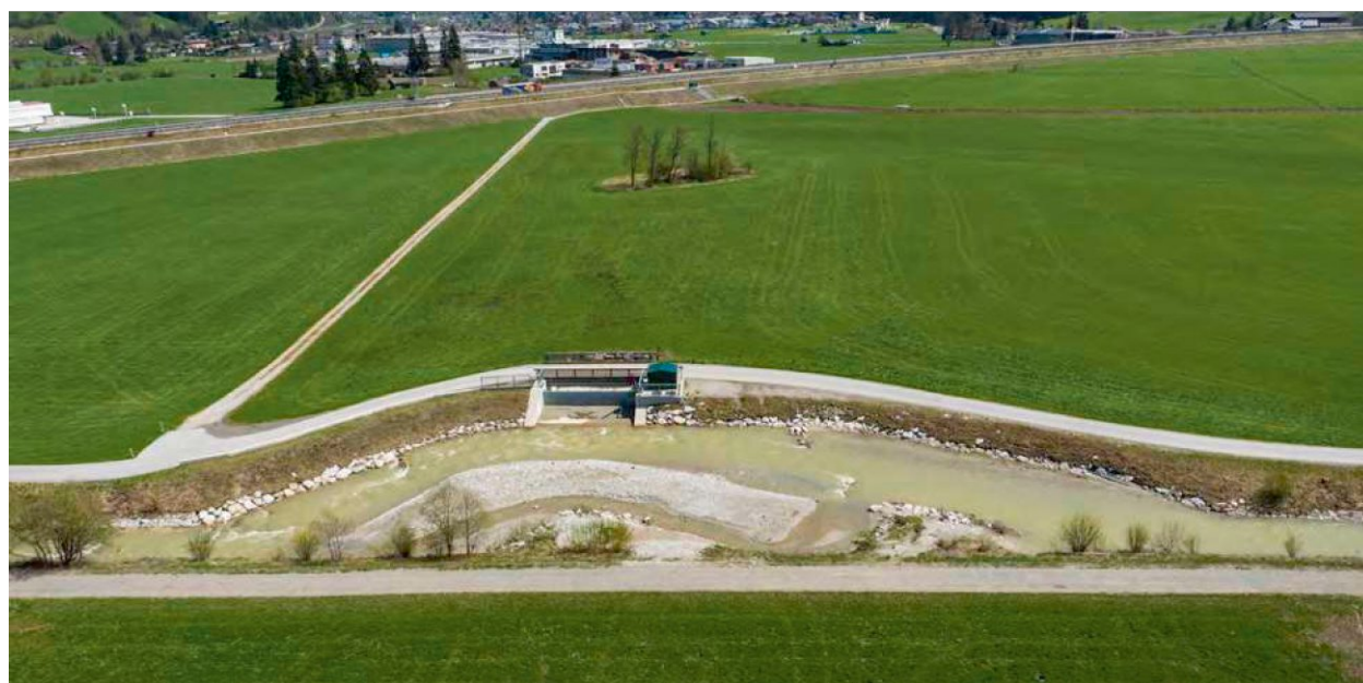
Abb.65 Blick auf das Einlaufbauwerk und das Rückhaltebecken Altenmarkt. Quelle: Land Salzburg 2016.
