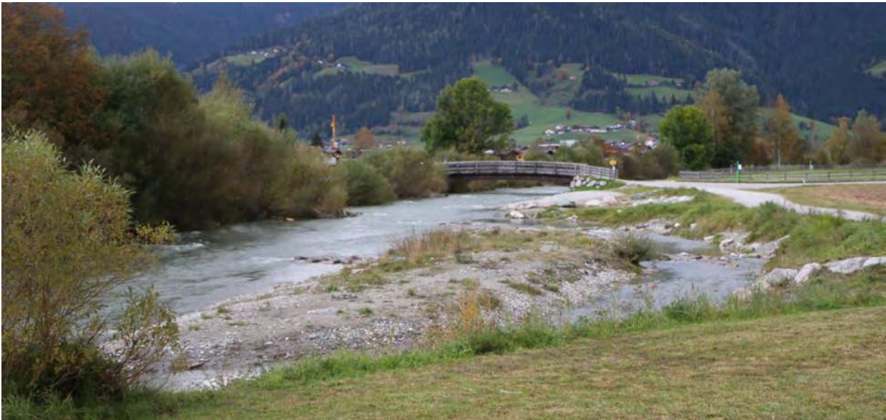
Abb.69 Uferaufweitung der Enns Altenmarkt, eigene Aufnahme 2024.
