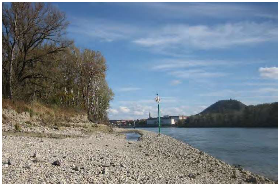
Abb.19 Uferrückbau Thurnhaufen nachher. Quelle: viadonau 2016.
