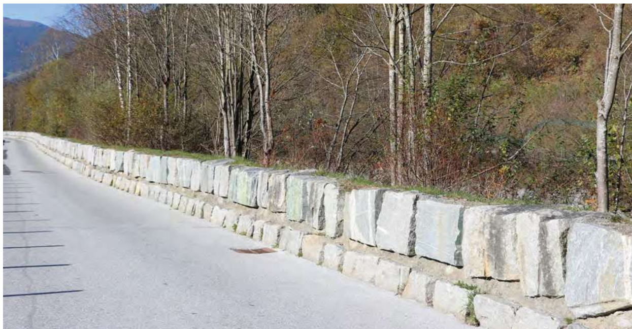
Abb.39 Hochwasserschutzmauer im Siedlungsgebiet Tauernradweg, eigene Aufnahme 2024.
