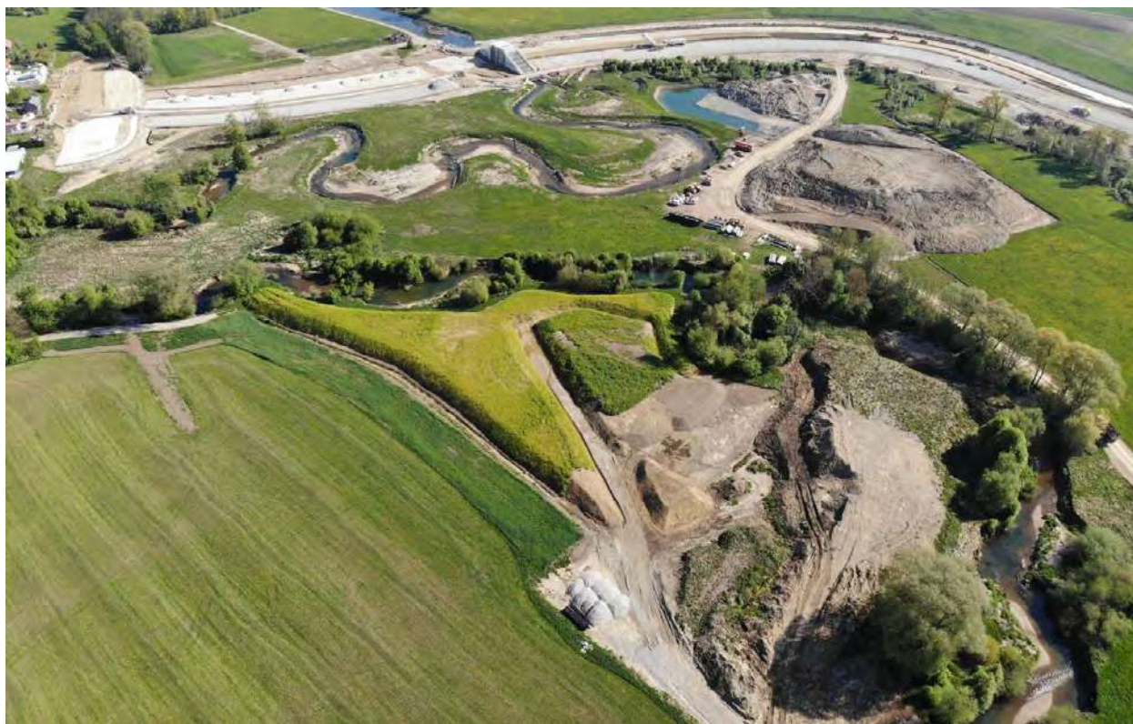
Abb.27 Hochwasserrückhaltebecken Krems-Au. Quelle: ibh Wasser-Umwelt-Infrastruktur GmbH 2022.
