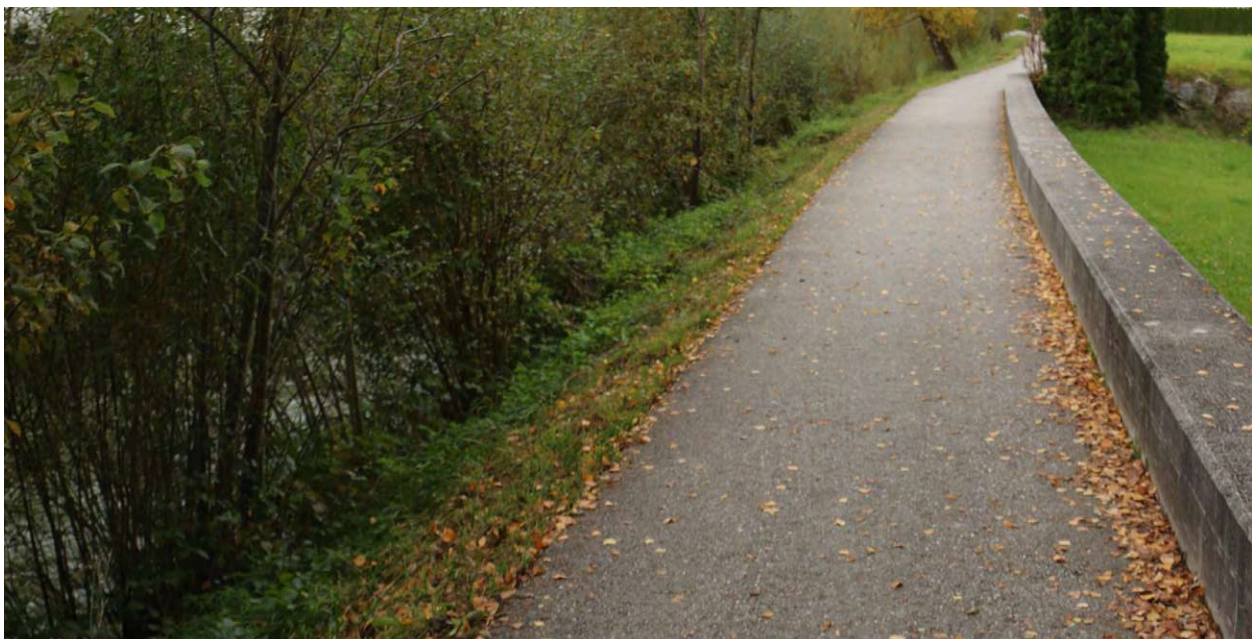
Abb.67 Schutzmauer entlang der Enns, eigene Aufnahme 2024.
