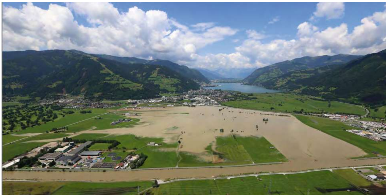
Abb.49 Blick auf den Retentionsraum Zeller Becken, Hochwasser 2021. Quelle: Land Salzburg 2021.
