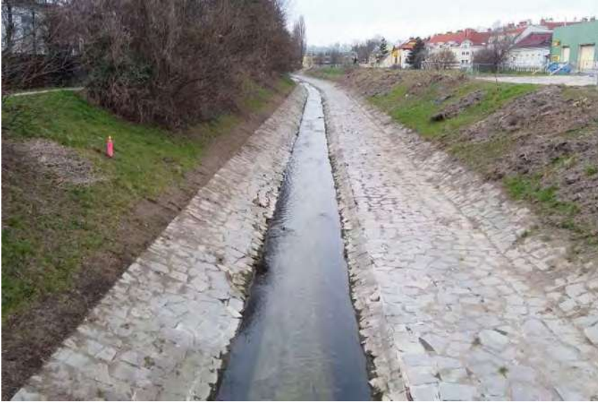
Abb.20 Regulierung Liesing mit verbauter Gewässersohle. Quelle: Wien.orf.at, 2024.
