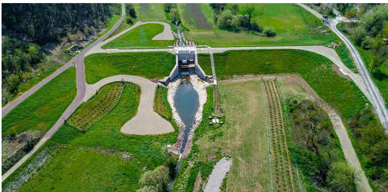
Abb.4 Hochwasserrückhaltebecken Querfurt. Quelle: Talsperrenbetrieb Sachsen-Anhalt, 2024.
