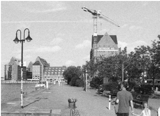
Abb.32 - Umbaumaßnahmen an Silo 1 (2024)
