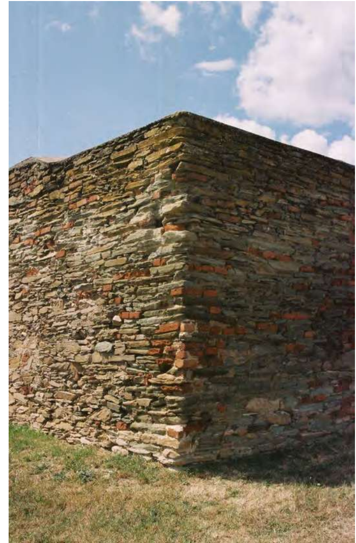
Mauerwerk des Kreuzstadl August 2024, Nikon F65
