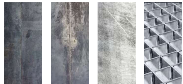
Reflektierendes, unterschiedlich stark gebürstetes Aluminium verkleidet die schweren Türen und Oberlichter. Die Brücke ist aus filigranem Stahl und Stahlgitter
