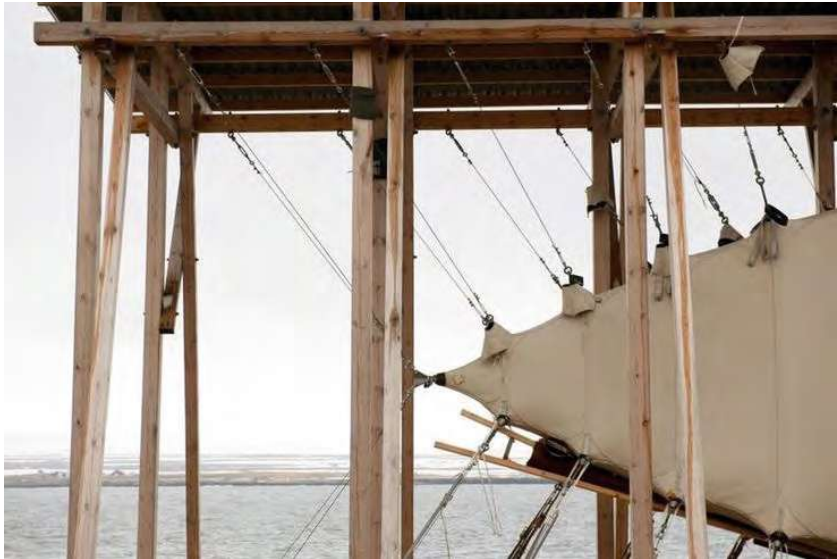
Abb. 3: Detail des Holzgerüsts und eingehängtem Textil
