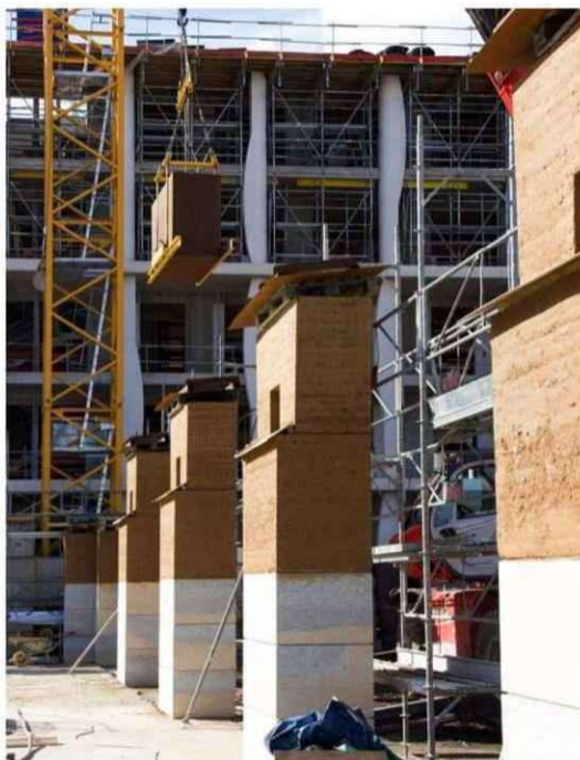
Abb. 10: Montage der Lehmteile
