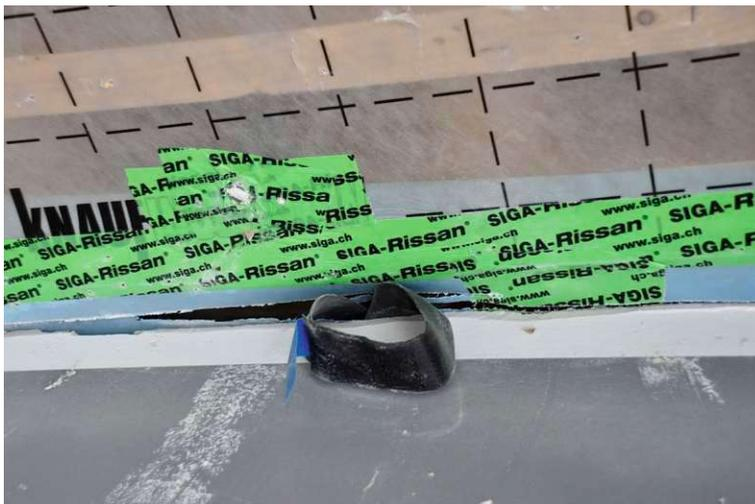
Abbildung 23 Aufgeschnittene Dampfbremse und Hebelasche (eigene Abbildung)
