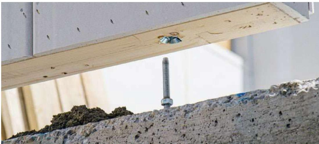
Abbildung 5 Bauteilverbinding mittels HCW Anker von Hilti (Hilti, 2024)
