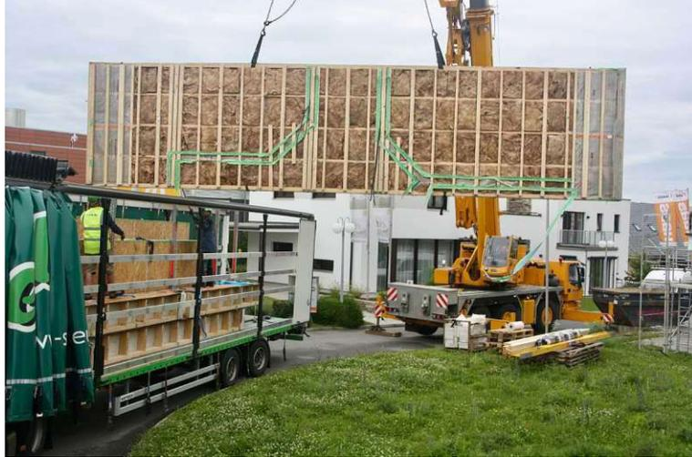
Abbildung 32 Ein Deckenelement wird auf den Sattelzug verladen (eigene Abbildung)
