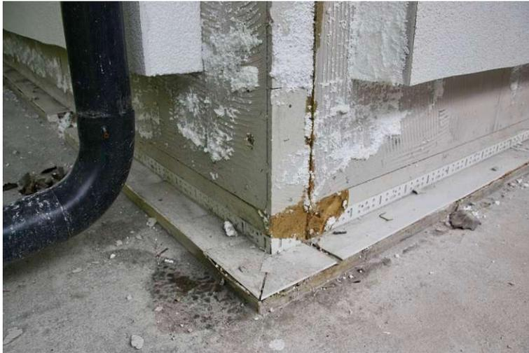
Abbildung 26 Sockelanschluss - freigelegte Ecke (eigene Abbildung)
