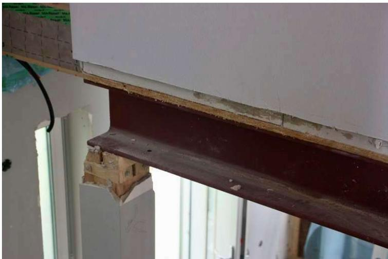
Abbildung 27 Freigelegter Unterzug (eigene Abbildung)
