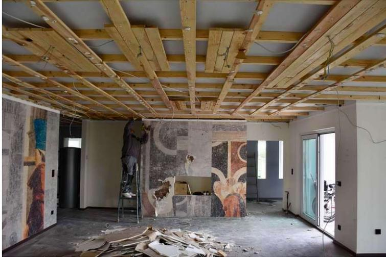
Abbildung 22 Entfernen der Deckenbeplankung (eigene Abbildung)
