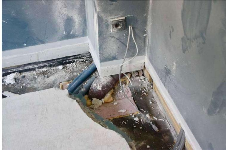
Abbildung 24 Freigelegter Bauteilanschluss unter dem Estrich (eigene Abbildung)
