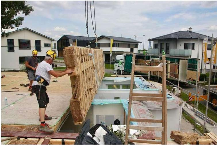
Abbildung 34 Die Decken des EG werden verhooben (eigene Abbildung)
