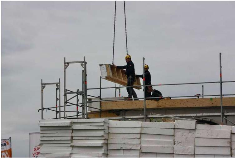
Abbildung 30 Attika-Element wird vom Dach gehoben (eigene Abbildung)
