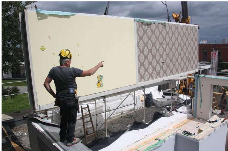
Abbildung 33 Ein gelöstes Wandelement wird angehoben (eigene Abbildung)
