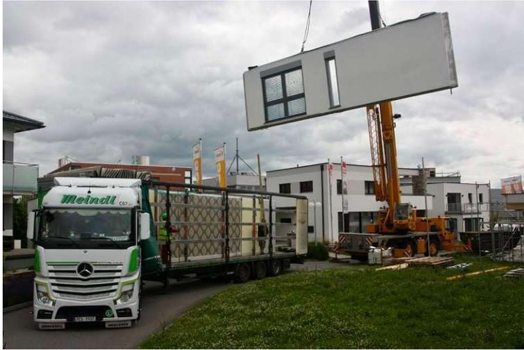
Abbildung 10 Wandelement wird auf den Sattelzug verladen (eigene Abbildung)
