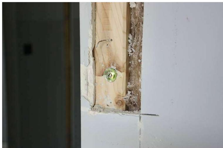
Abbildung 29 Freigelegte Schraubverbindung einer Innenwand (eigene Abbildung)
