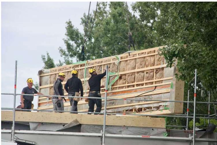
Abbildung 31 Erstes Deckenelement wird angehoben (eigene Abbildung)
