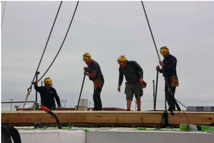
Abbildung 9 Zimmerer beim Rückbau von Deckenelementen (eigene Abbildung)
