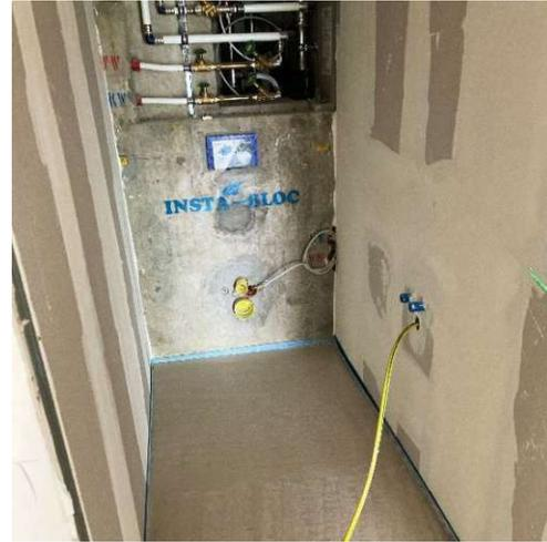
**Abbildung 3.3:** Instabloc Technischacht Nassraum
