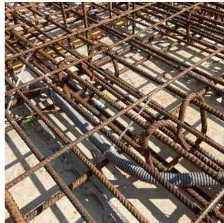
**Abbildung 5.7:** Darstellung der zusätzlichen Schubbügel in der Decke über 2. Obergeschoß (04.10.2023)
