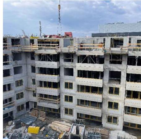
**Abbildung 4.8:** Darstellung der mehrgeschoßigen Unterstellung (13.03.2024)
