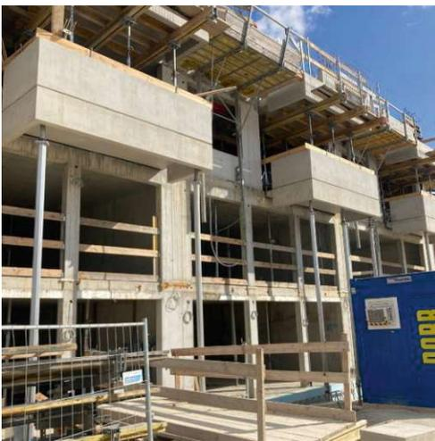
**Abbildung 3.4:** Darstellung der Balkonfertigteile
