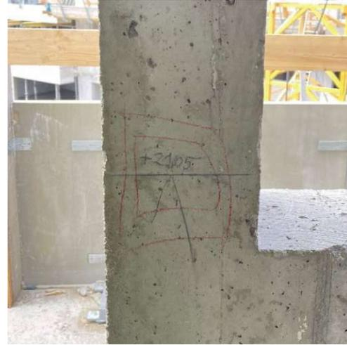
**Abbildung 4.6:** Waagriss im 7. Obergeschoß
