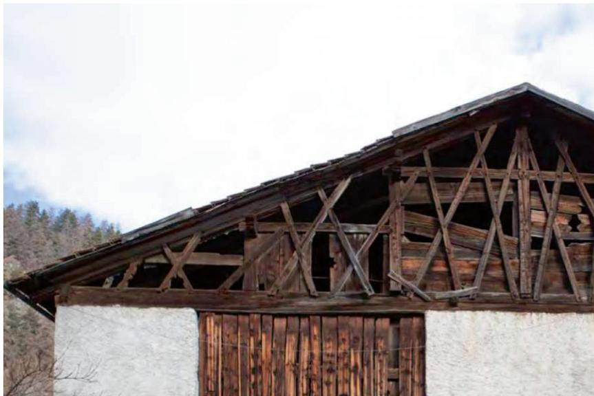
Abb. 159: Geschlossener Bundwerkgiebel an der Südfassade des Stadels, senkrechte und waagrechte Hinterschalung, 2023
