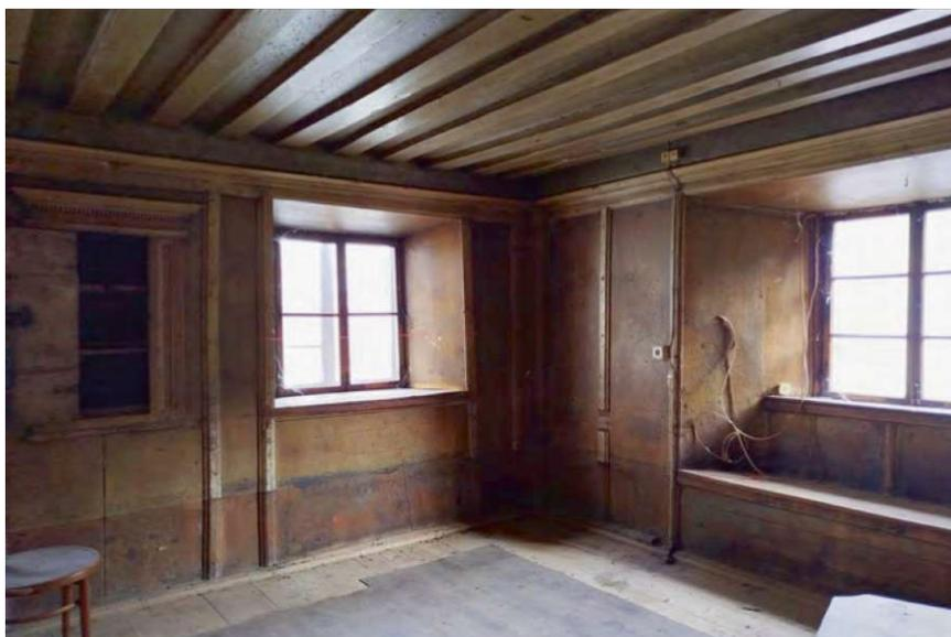
Abb. 156: Stube im Erdgeschoss mit spätgotischer Balkendecke. Raumhohe Wandvertäfelung mit Abschluss zu Decke mit umlaufendem Sims und florealen Ornament sowie dunkelfarbigem Sockelbereich. Rechts im Bild: Sitzfenster mit konischer Laibung. 2023
