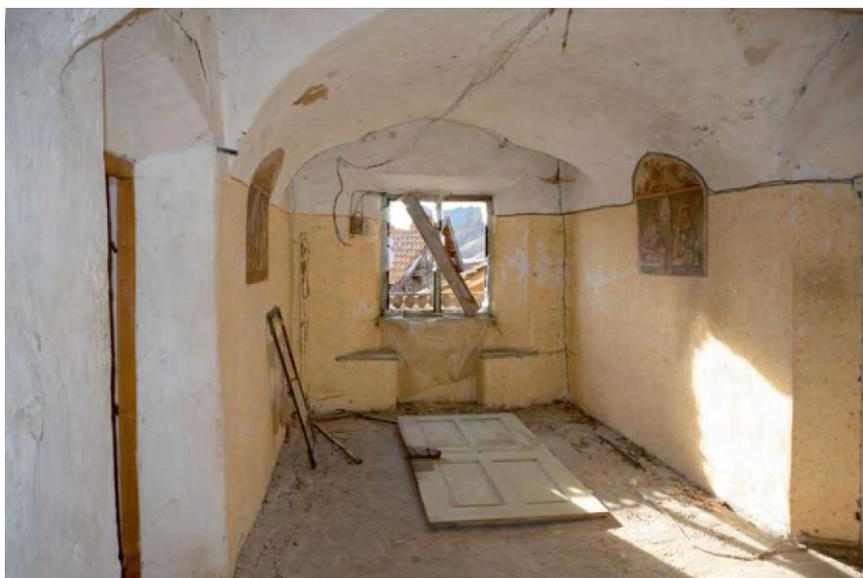
Abb. 153: Tonnengewölbter Flur mit Stichkappen und Seitensitzfenster im Obergeschoss, 2023
