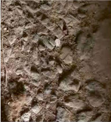
Abb. 73: Kugelsteinpflaster
