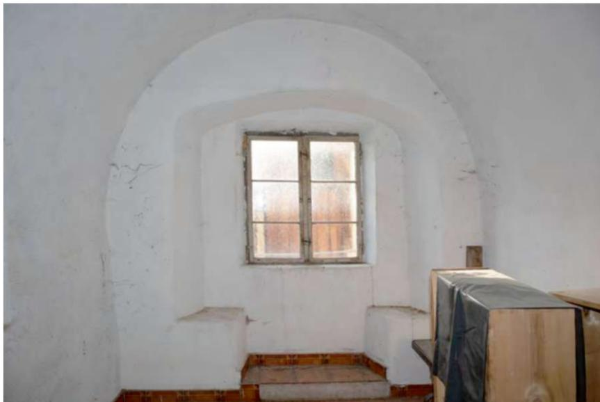
Abb. 150: Seitensitzfenster im Mittelflur des Erdgeschosses zur Ausübung von Handarbeiten bei Tageslicht, herrschaftliches Element, 2023
