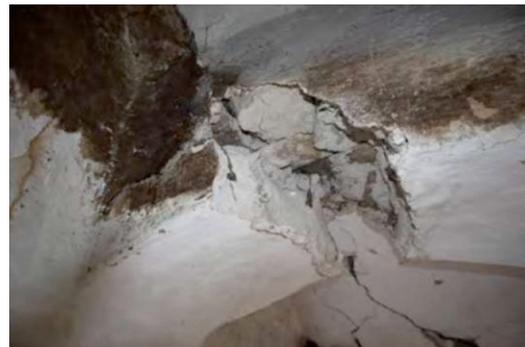
Abb. 130: beschädigtes Tonnengewölbe
