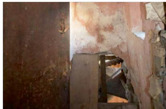
Abb. 139: teils eingestürztes Natursteinmauerwerk
