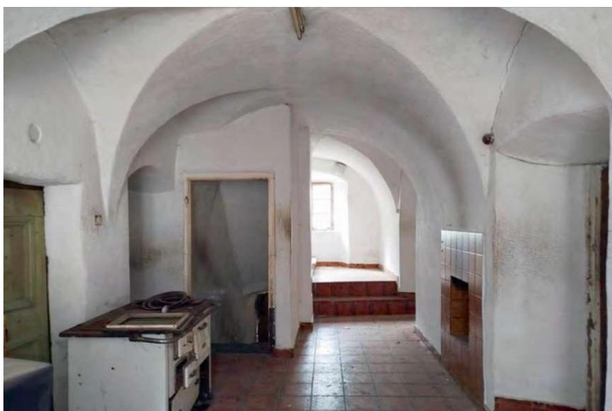
Abb. 151: Tonnengewölbter Flur mit Stichkappen im Erdgeschoss, 2023
