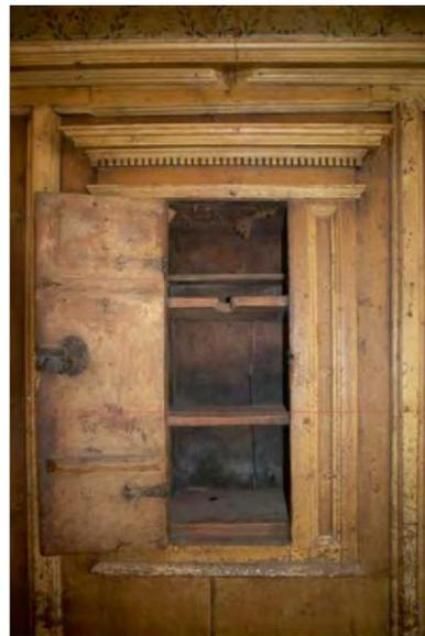
Abb. 155: Wandkästchen mit Zierleiste mit Zahnschnittmotiv, darüber profilierte Deckenleiste, 2023
