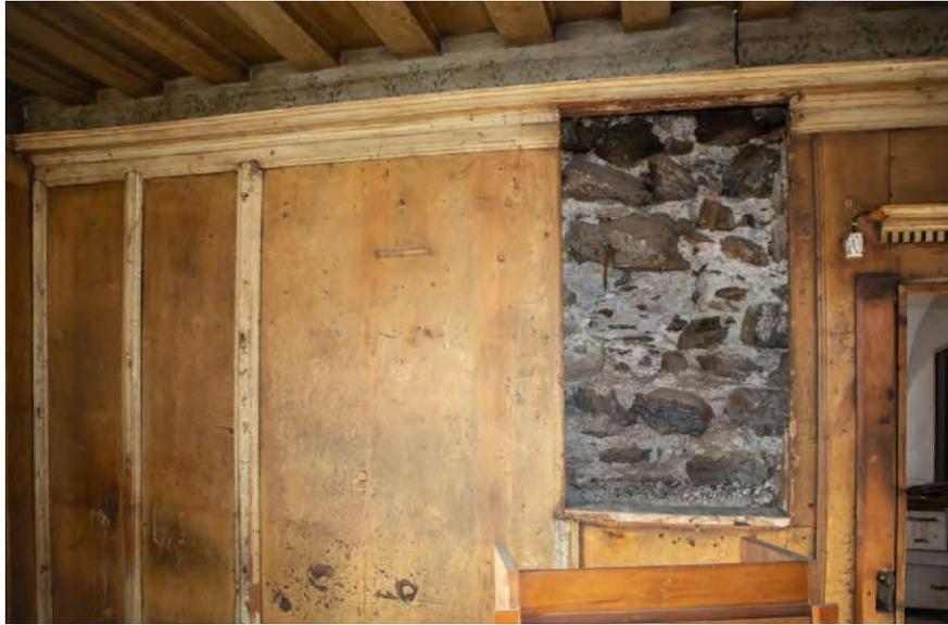
Abb. 58: Freigelegtes Natursteinmauerwerk in Stube I, 2023
