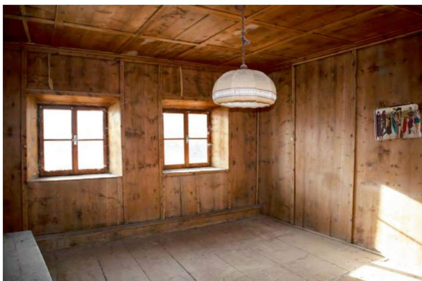
Abb. 158: Stube mit Felderdecke im Obergeschoss, rundum vertikale Vertäfelung mit einfachen Deckenleisten. Einziger Raum mit zwei Fenstern in Richtung Süden. 2023
