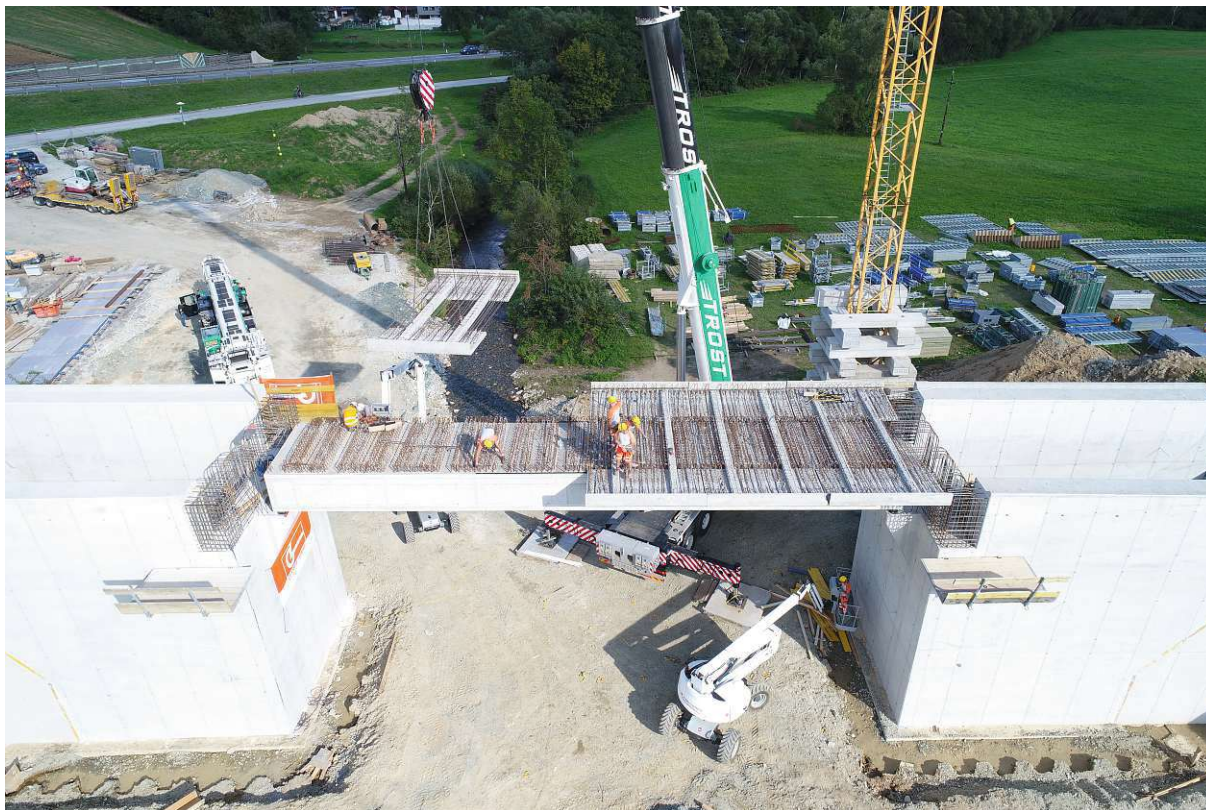
Abb. 2.6: Erstanwendung des LT-Brückenbauverfahrens am Beispiel der Pinkabachbrücke: Einheben eines Fahrbahnplattenelements auf dem bereits positionierten hohlkastenförmigen Längsträger ©Johann Kollegger
