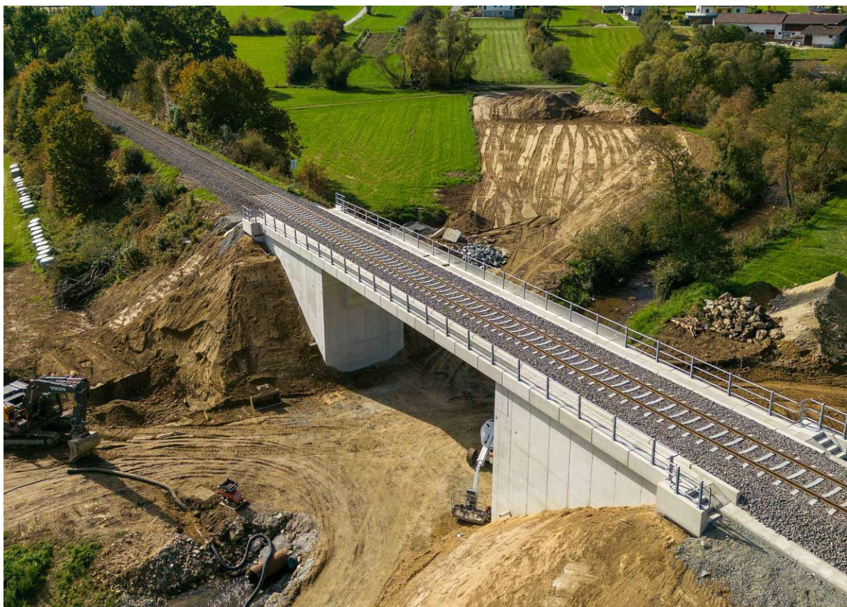
Abb. 1.1: Pilotprojekt gebaut mit dem LT-Verfahren: Pinkabachbrücke [11] ©TU Wien
