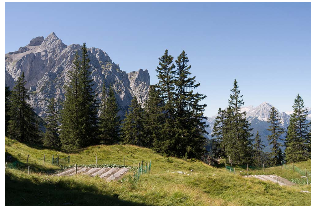
Abb. 198 Mechanisch-biologische Kläranlage der Hochlandhütte (Deutschland) im Jahr 2012 Foto: Uwe Einig/fotocommunity.de URL: https://www.fotocommunity.de/photo/mechanisch-biologische-kläranlage-hochla-uwe-einig/29070275
