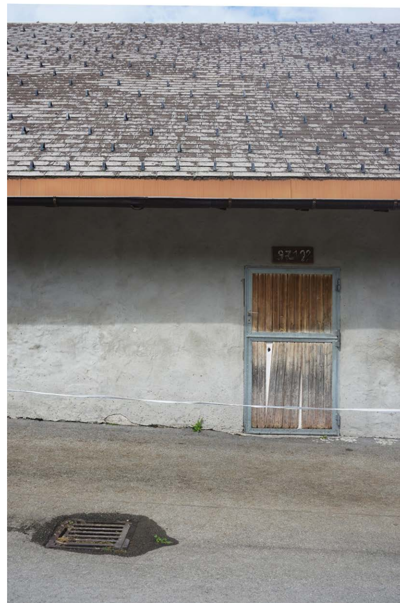
Abb. 178 Seitenansicht der Fassade des Stallungsgebäudes Foto: Eigene Aufnahme
