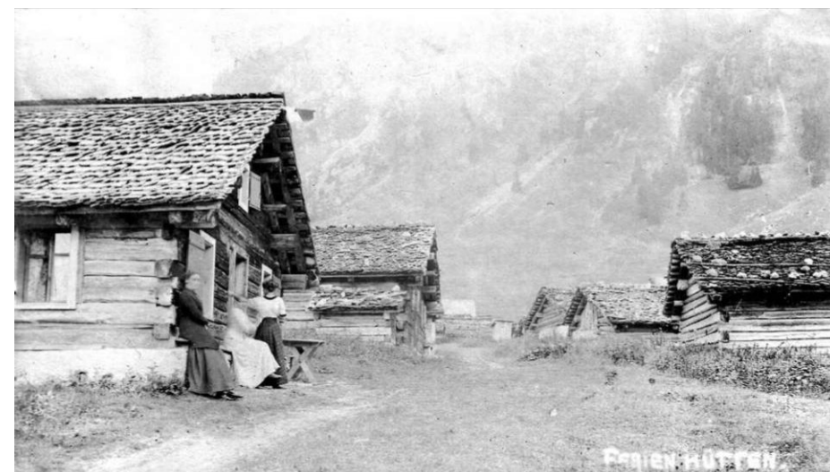
Abb. 162 Eine umgebaute Brochathütte im Fasel Fotos: Elmar Beer/Archiv Nenzing Abb. 163 Umgebaute Brochathütten im Fasel Fotos: Elmar Beer/Archiv Nenzing
