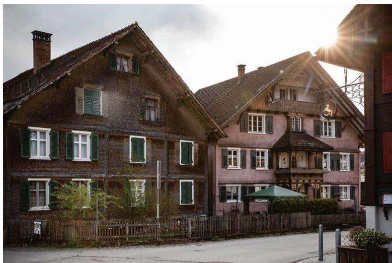
Abb. 33 Schindelfassaden im alten Ortskern Nenzings Foto: lippzahnschirm+raneburger
