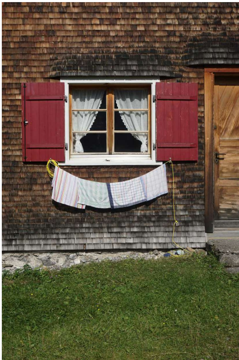
Abb. 159 Wäscheleine als Ausdruck der Wohnnutzung im Fasel Foto: Eigene Aufnahme
