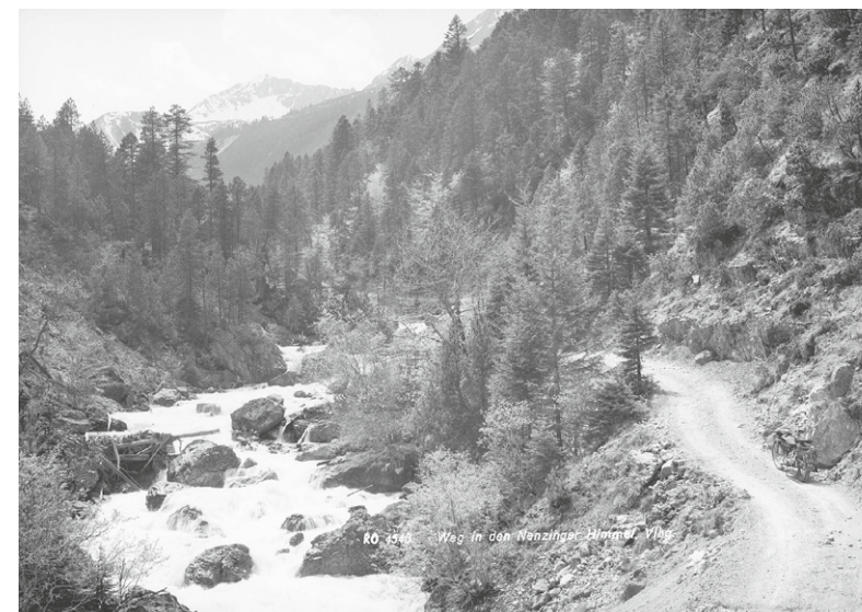
Abb. 114 Bau des Gamperdonaweges, 1953 Quelle: Archiv Nenzing
