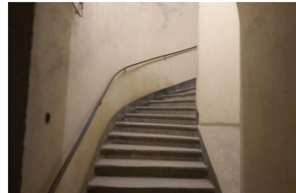
Abb 93: U-Form Wendeltreppe. Die Wand ist beige gestrichen, aber sehr schmutzig. Aufgrund von Feuchtigkeit haben sich Schäden an der Wand gebildet. (Siehe Grundriss; Bereich 7) / Foto: eigene Aufnahme, 13.02.2024
