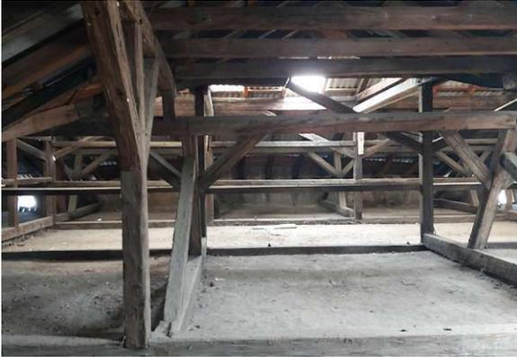
Abb 118: Dachgeschoss. Auf diesem Bild ist die Holzkonstruktion zu sehen, die das Blechdach trägt. (Siehe Grundriss; Bereich 1) / Foto: eigene Aufnahme, 13.02.2024
