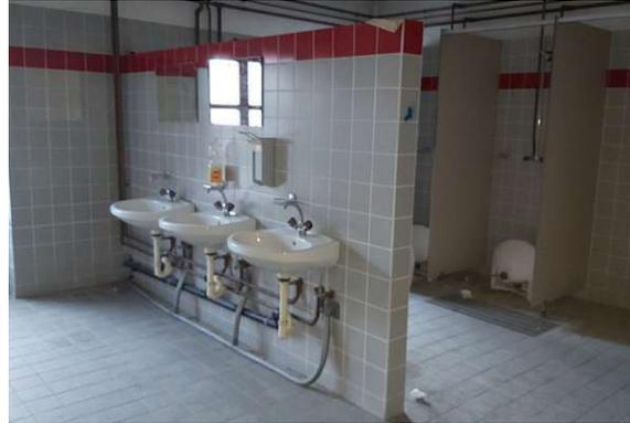
Abb 96: WCs. Die Toiletten weisen graue Fliesen an Boden und Wänden auf. Die Metallwasserrohre sind sichtbar. Die meisten Toiletten sind kaputt und unbenutzbar. (Siehe Grundriss; Bereich 2) / Foto: eigene Aufnahme, 13.02.2024
