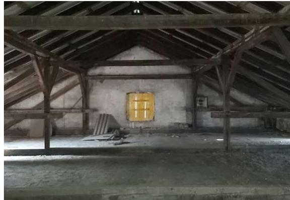
Abb 122: Im Dachgeschoss wurde das Fenster an der Giebelwand im Westen mit Holzstücken verschlossen. (Siehe Grundriss; Bereich 5) / Foto: eigene Aufnahme, 13.02.2024
