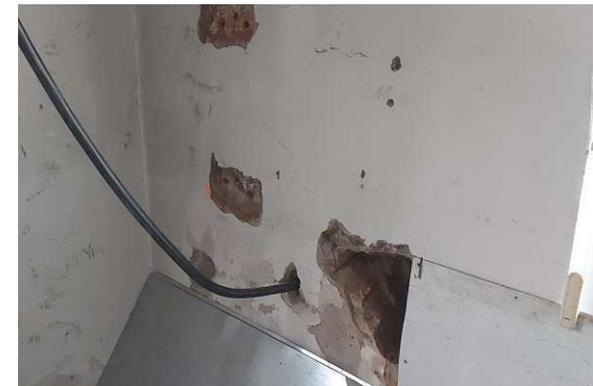
Abb 102: Aufenthaltsraum. Die Wand weist Kabeldurchführungen, Schäden und Verschmutzungen auf. (Siehe Grundriss; Bereich 1) / Foto: eigene Aufnahme, 13.02.2024
