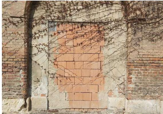
Abb 71: Eine verschlossene Tür. An der Südfassade wurden drei alte Türen entfernt und mit Ziegelsteinen verschlossen. / Foto: eigene Aufnahme, 13.02.2024
