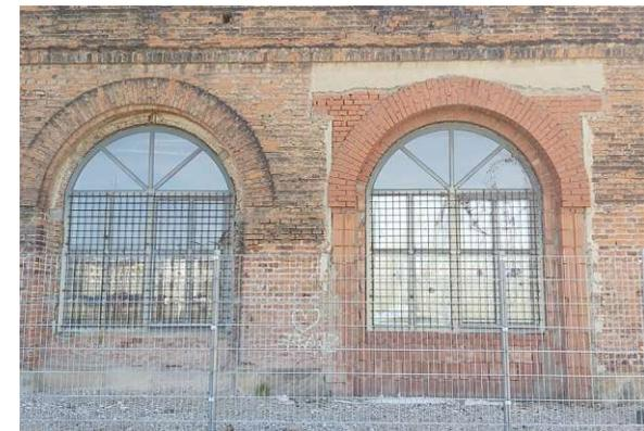
Abb 78: Nordfassade. Die beschädigten Ziegelsteine am Rand des Fensters wurden erneut vermauert. Der Farbunterschied ist deutlich erkennbar. / Foto: eigene Aufnahme, 13.02.2024
