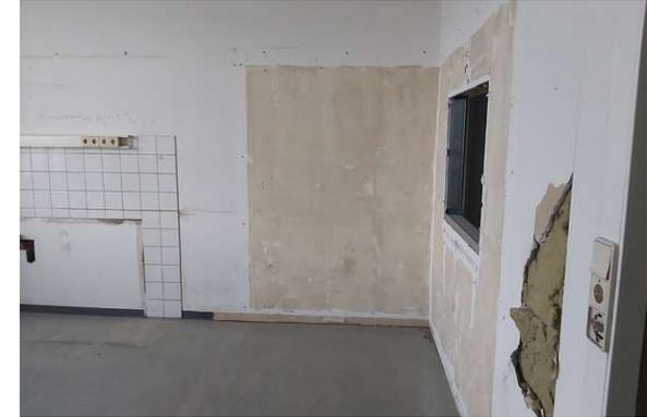
Abb 114: Küche. Auf diesem Bild sieht man, dass links die Küche entfernt wurde. Die Küchenfliesen sind noch da. Die Metallständerwand ist gebrochen, und die Dämmung darin ist sichtbar. (Siehe Grundriss; Bereich 5) / Foto: eigene Aufnahme, 13.02.2024
