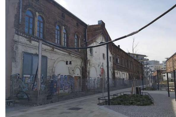
Abb 75: Nordfassade. Beim Betrachten der weißen Verputzflächen an der Fassade ist die Position des abgerissenen Historischen Verbindungstrakts erkennbar. / Foto: eigene Aufnahme, 13.02.2024
