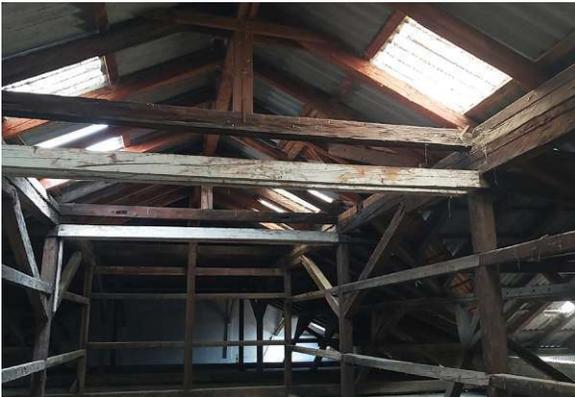
Abb 121: Es gibt kein Fenster auf dem Dach. Nur an einigen Stellen ist das Blechdach transparent und erhält von dort natürliches Licht. (Siehe Grundriss; Bereich 4) / Foto: eigene Aufnahme, 13.02.2024
