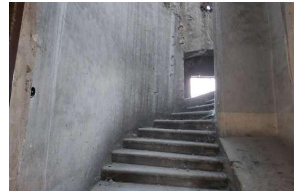
Abb 100: Treppe. Die Treppe, die zum Dachgeschoss führen, bestehen aus Beton. An den Wänden fehlen Putz und Farbe. (Siehe Grundriss; Bereich 7) / Foto: eigene Aufnahme, 13.02.2024
