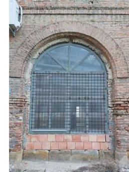
Abb 127-128: Einige Fenster an der Fassade. Diese wurden in Übereinstimmung mit dem Rest der Fassade repariert. / Foto: eigene Aufnahme, 13.02.2024
