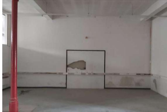
Abb 113: Aufenthaltsraum / Gang. Auf diesem Bild ist zu erkennen, dass die Tür entfernt wurde. Doch die neu errichtete Wand wurde beschädigt. (Siehe Grundriss; Bereich 4) / Foto: eigene Aufnahme, 13.02.2024
