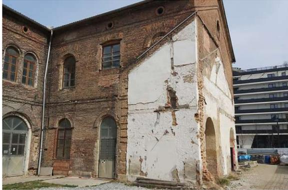
Abb 125: Süd-West Fassade der Inventarhalle. Die Spuren der abgerissenen Gebäude müssen repariert werden. / Foto: eigene Aufnahme, 13.02.2024
