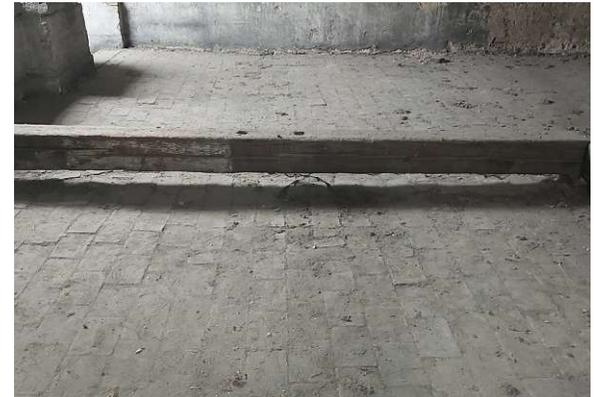
Abb 123: Der Boden ist aus Stein. Durch die Holzstruktur entsteht eine Schwelle entlang des gesamten Bodens. / Foto: eigene Aufnahme, 13.02.2024
