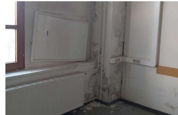
Abb 117: Aufenthaltsraum. Schäden durch Feuchtigkeit sind auf dem Bild zu erkennen. (Siehe Grundriss; Bereich 8) / Foto: eigene Aufnahme, 13.02.2024
