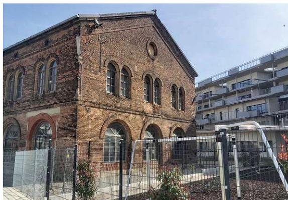
Abb 85: Die Westfassade der Inventarhalle. Im Erdgeschoss befinden sich drei große Fenster, im ersten Obergeschoss sechs kleine Fenster, und in der Giebelfassade gibt es runde Fenster. Das runde Fenster wurde mit Brettern vernagelt. / Foto: eigene Aufnahme, 13.02.2024
