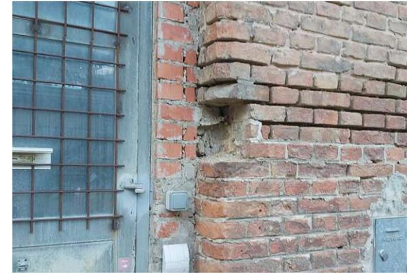
Abb 69: An vielen Stellen der Fassade fallen beschädigte und ausgetauschte Ziegel ins Auge. / Foto: eigene Aufnahme, 13.02.2024
