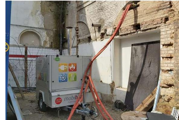
Abb 72: Südfassade: Spuren des abgerissenen Nebengebäudes, beschädigte Wände und ein für die Baustelle verwendeter Generator./ Foto: eigene Aufnahme, 13.02.2024
