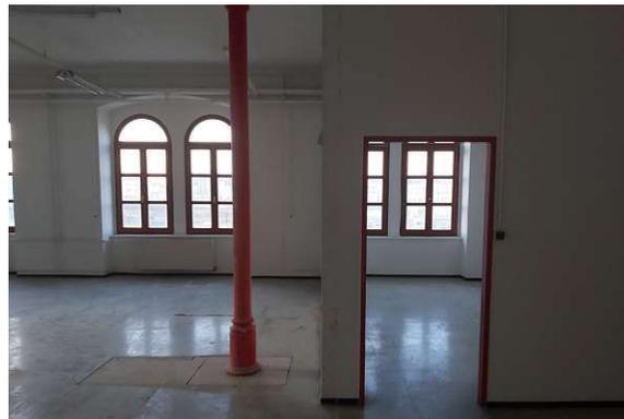
Abb 131: Aufenthaltsraum im 1. OG: Alle Metallständerwände werden abgebrochen. / Foto: eigene Aufnahme, 13.02.2024
