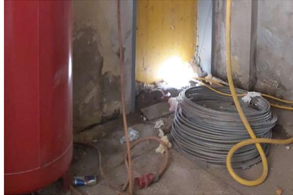
Abb 89: Vorraum. Auf diesem Bild sind durch Feuchtigkeit beschädigte Wände, Kabel von Baufirmen und eine Holztür zu sehen (Siehe Grundriss; Bereich 1) / Foto: eigene Aufnahme, 13.02.2024
