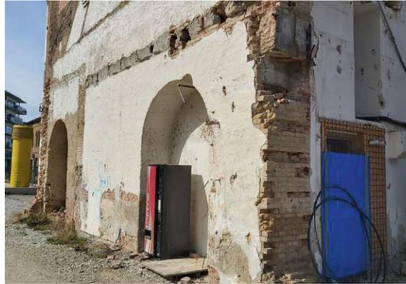
Abb 68: Durch den Abriss einiger zuvor an die Südfassade angrenzender Gebäude haben die Ziegelsteine hier erheblichen Schaden erlitten und wurden mit Putz bedeckt. / Foto: eigene Aufnahme, 13.02.2024
