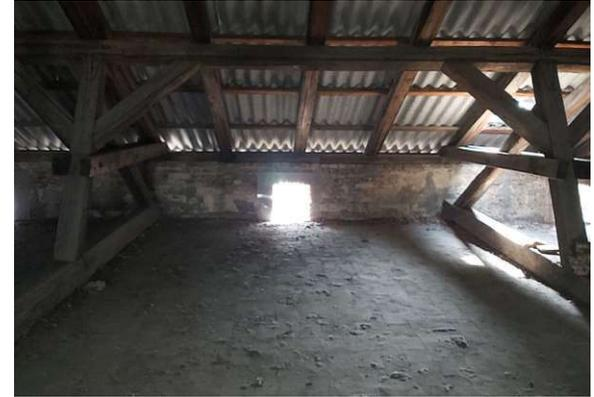
Abb 120: An den Wänden des Dachgeschosses befinden sich kleine Fenstern. (Sie sind von außen rund und von innen bogenförmig) (Siehe Grundriss; Bereich 3) / Foto: eigene Aufnahme, 13.02.2024
