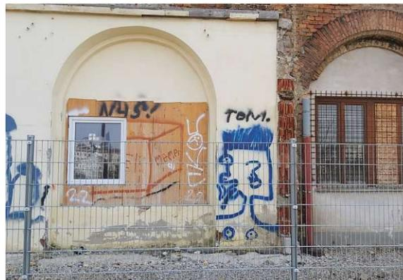
Abb 77: Nordfassade. Die Graffitis erstrecken sich bis zum mittleren Bereich der Fassade. Außerdem wurde das alte Fenster der Fassade mit Brettern verschlossen. An den mit weißem Putz versehenen Wänden haben sich aufgrund von Feuchtigkeit Abblätterungen gebildet. / Foto: eigene Aufnahme, 13.02.2024
