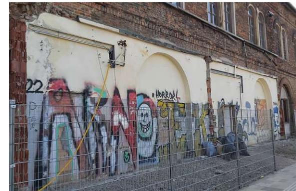
Abb 129: Nordfassade/Erdgeschoss. Früher befand sich hier der Erweiterungsbau der Inventarhalle, weshalb keine Fenster vorhanden waren. Es wurde jedoch als angemessen erachtet, in diese Bereiche neue Fenster hinzuzufügen. / Foto: eigene Aufnahme, 13.02.2024
