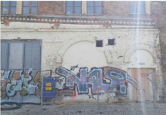
Abb 76: Nordfassade. Auf diesem Bild sind eine die Einheitlichkeit der Fassade störende Metalltür, fehlende Fenster an Stellen, wo normalerweise Fenster sein sollten, da sich hier früher ein Gebäude befand, sowie Graffiti zu sehen. / Foto: eigene Aufnahme, 13.02.2024
