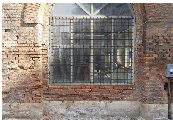
Abb 87: An den Ecken und neben den Fenstern sind einige Ziegel beschädigt. Auf der rechten Seite des Fensters sind Ziegel für einen Elektrokasten gebrochen. An den Fenstern im Erdgeschoss befinden sich Metallgitter. / Foto: eigene Aufnahme, 13.02.2024
