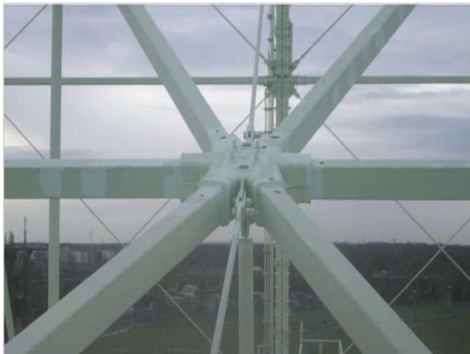
Bild 6: Typischer Knoten der Tragkonstruktion.
