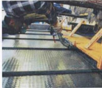
EMACO NanoCrete R4 Fluid eignet sich für großflächige Betoninstandsetzung in Verschleiß- und Gleitzone.
