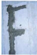
Um eine komplette Abdichtung der Bewehrung sicherzustellen, darf PCI Nanocrete AP auch auf feuchtem, abgeschliffenem Untergrund aufgetragen werden.
