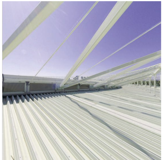
X_06_EHS_DACHAUF SICHT_22122023_06_EHS_DACHAUF- SICHT_125_1.jpeg
