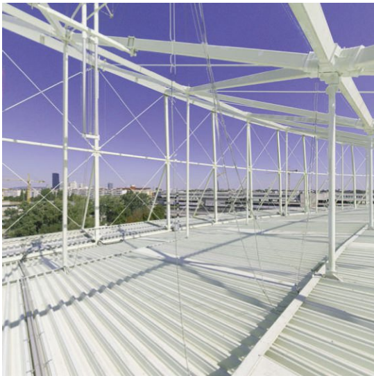
X_06_EHS_DACHAUF SICHT_22122023_06_EHS_DACHAUF- SICHT_125_0.jpeg
