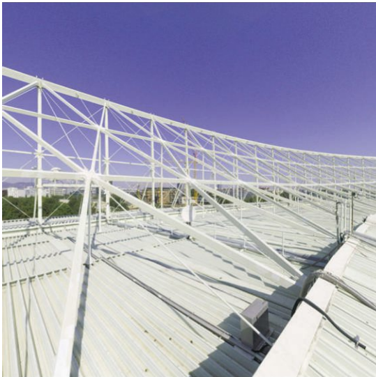
X_06_EHS_DACHAUF SICHT_22122023_06_EHS_DACHAUF- SICHT_185_2.jpeg
