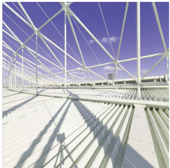
X_06_EHS_DACHAUF SICHT_22122023_06_EHS_DACHAUF- SICHT_108_3.jpeg
