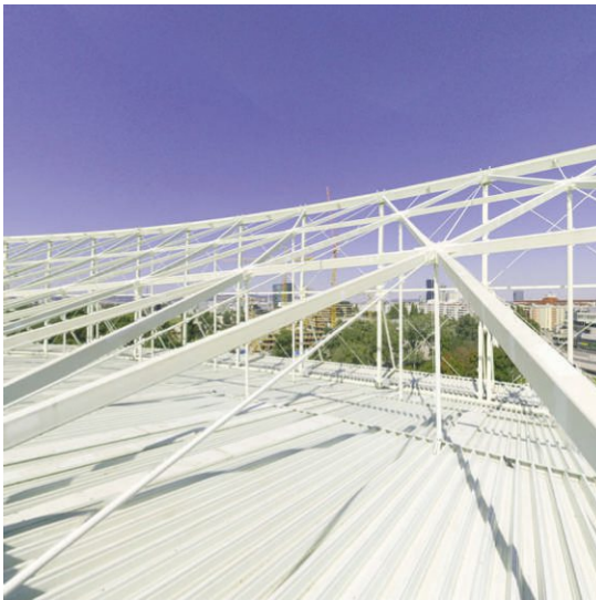
X_06_EHS_DACHAUF SICHT_22122023_06_EHS_DACHAUF- SICHT_130_0.jpeg
