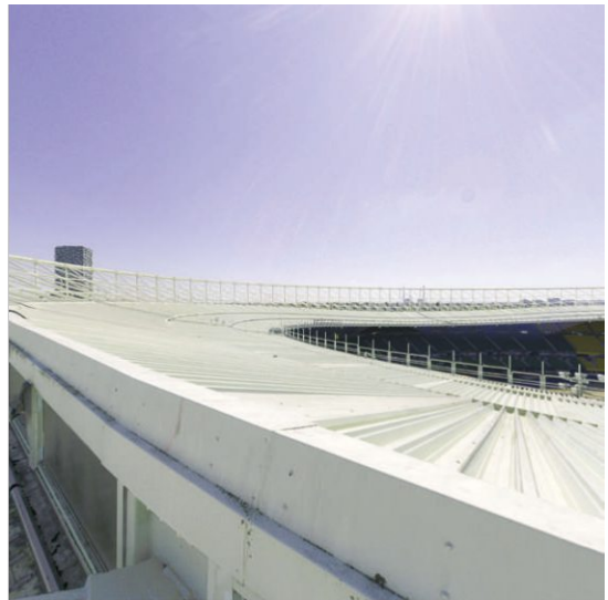
X_06_EHS_DACHAUF SICHT_22122023_06_EHS_DACHAUF- SICHT_130_1.jpeg
