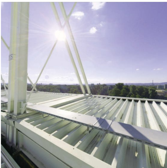
X_06_EHS_DACHAUF SICHT_22122023_06_EHS_DACHAUF- SICHT_108_2.jpeg
