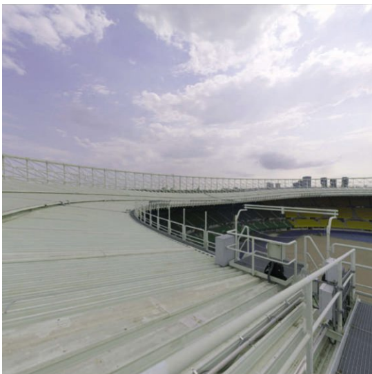
X_06_EHS_DACHAUF SICHT_22122023_06_EHS_DACHAUF- SICHT_241_2.jpeg
