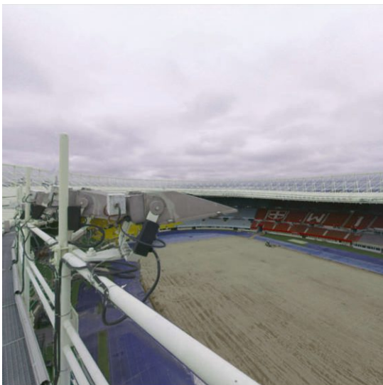
X_06_EHS_DACHAUF SICHT_22122023_06_EHS_DACHAUF- SICHT_269_2.jpeg
