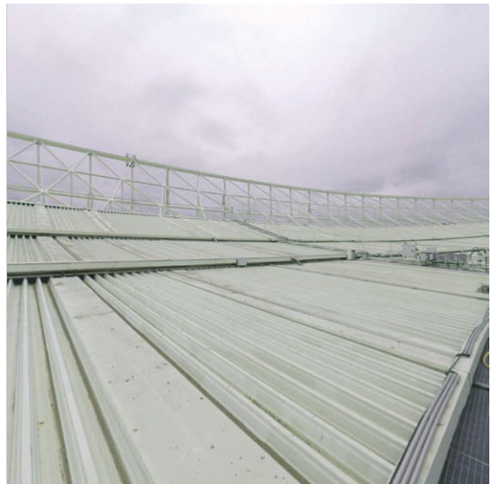
X_06_EHS_DACHAUF SICHT_22122023_06_EHS_DACHAUF- SICHT_273_1.jpeg
