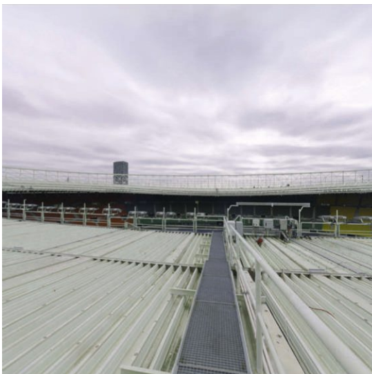
X_06_EHS_DACHAUF SICHT_22122023_06_EHS_DACHAUF- SICHT_218_2.jpeg
