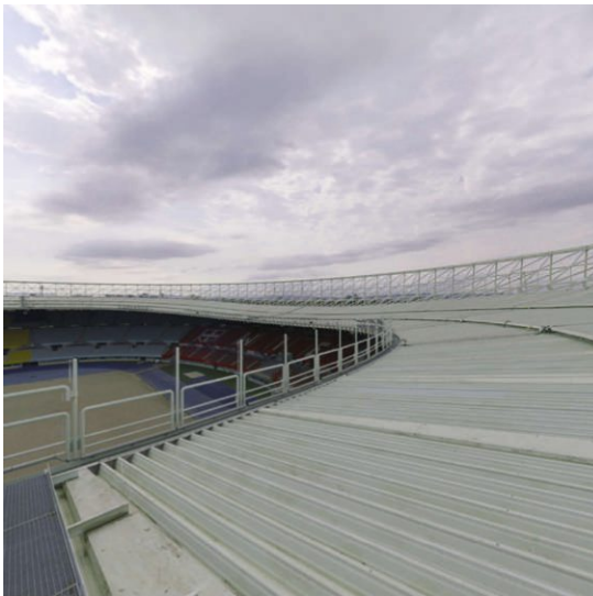
X_06_EHS_DACHAUF SICHT_22122023_06_EHS_DACHAUF- SICHT_241_0.jpeg
