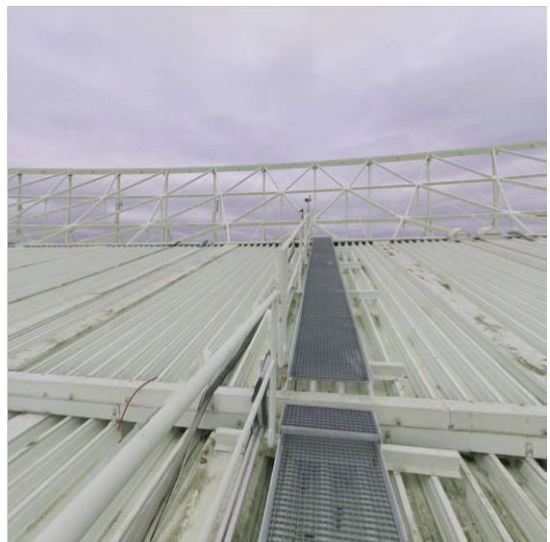
X_06_EHS_DACHAUF SICHT_22122023_06_EHS_DACHAUF- SICHT_218_3.jpeg
