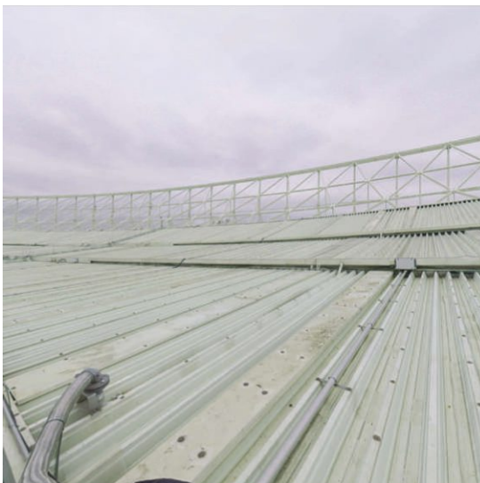
X_06_EHS_DACHAUF SICHT_22122023_06_EHS_DACHAUF- SICHT_225_2.jpeg
