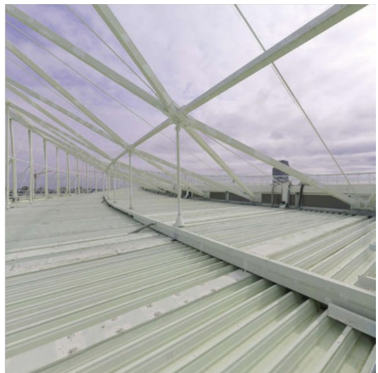
X_06_EHS_DACHAUF SICHT_22122023_06_EHS_DACHAUF- SICHT_213_3.jpeg
