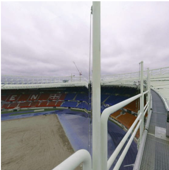
X_06_EHS_DACHAUF SICHT_22122023_06_EHS_DACHAUF- SICHT_269_0.jpeg
