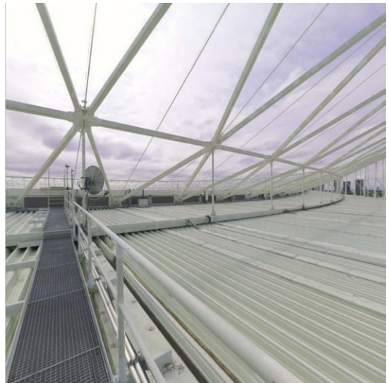
X_06_EHS_DACHAUF SICHT_22122023_06_EHS_DACHAUF- SICHT_212_1.jpeg
