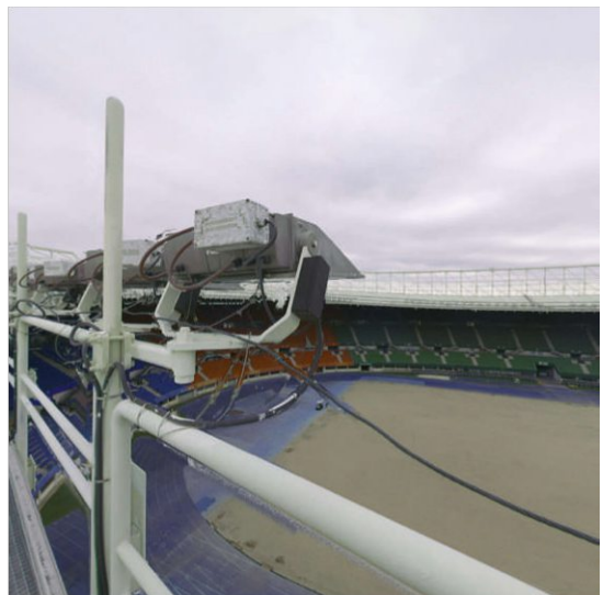
X_06_EHS_DACHAUF SICHT_22122023_06_EHS_DACHAUF- SICHT_225_3.jpeg
