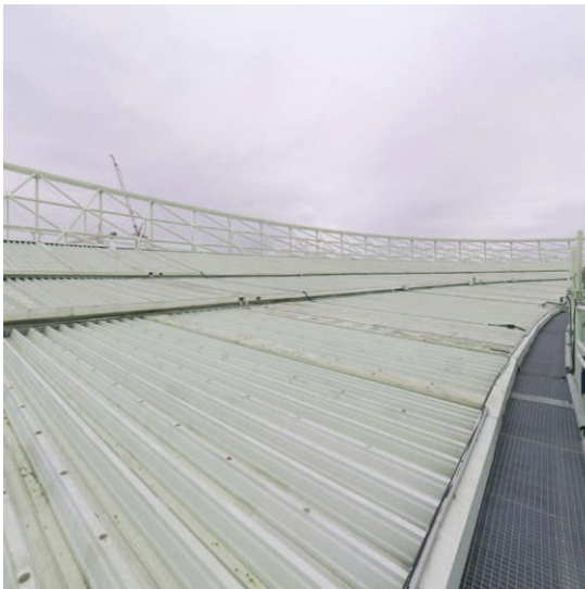
X_06_EHS_DACHAUF SICHT_22122023_06_EHS_DACHAUF- SICHT_225_0.jpeg
