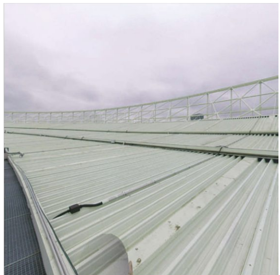
X_06_EHS_DACHAUF SICHT_22122023_06_EHS_DACHAUF- SICHT_273_3.jpeg
