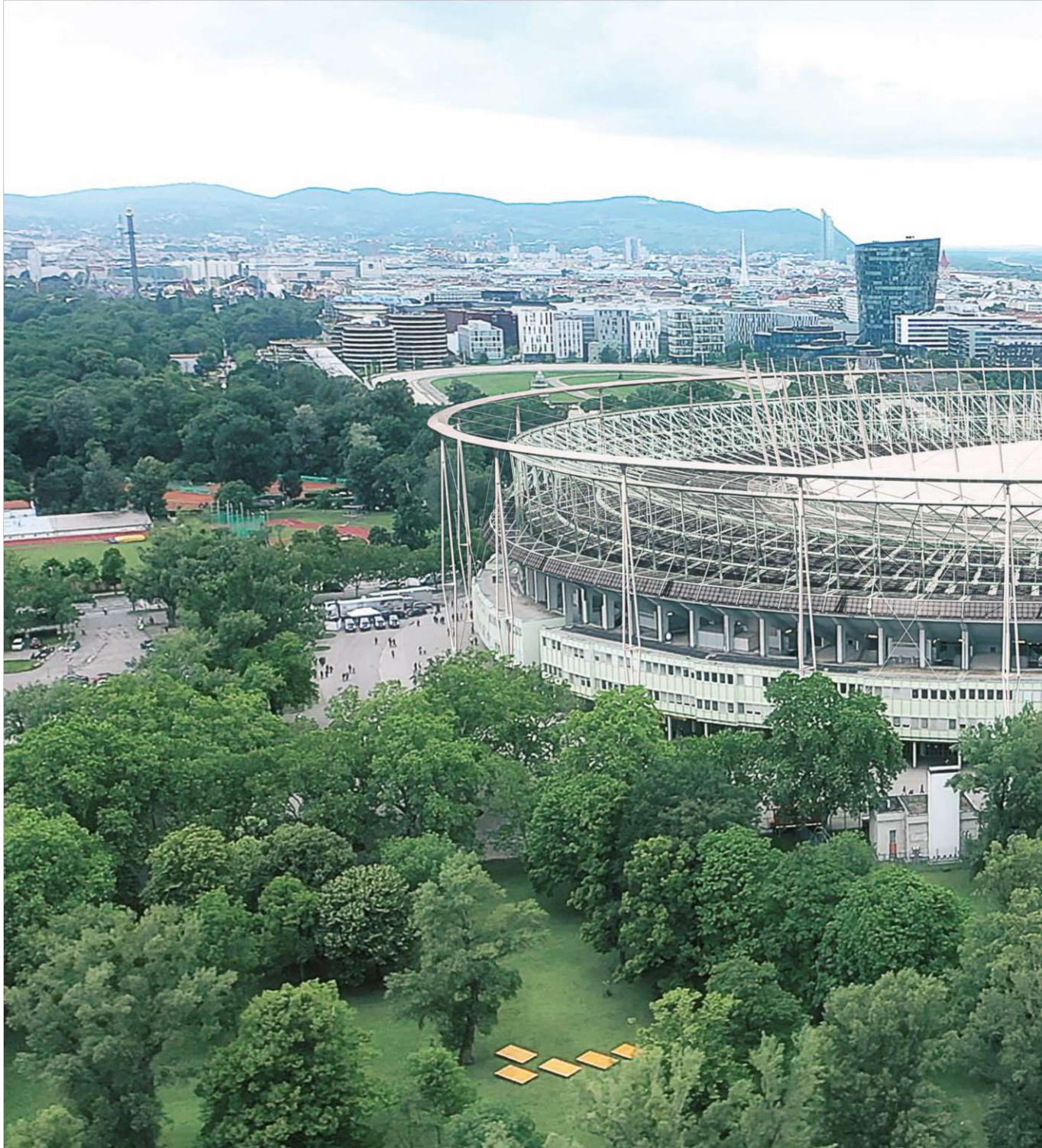
Foto, Drohnenflug- Vogelperspektive Visualisierung PV am Dach & wandelbares Dach Neu
