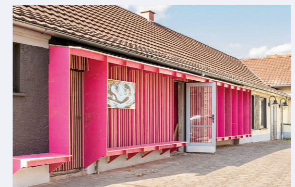
Abb. 3.6.C: Landzentrum Dorfregion Seltenrain – Kollektives Umbauen auf dem Land Quelle: https://iba-thueringen.de/projekte/region-seltenrain-landzentrum [letzter Aufruf: 21.11.2024]
