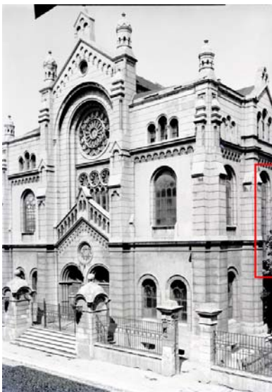
Abb.72: Markierung, Fenster Stiegenaufgang (zur Frauengalerie)
