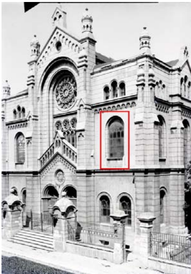
Abb.58: Markierung, Fenster 1.OG
