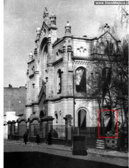
Abb.54: Foto der Synagoge, ca. 1939, Markierung der Tür (Stiegenaufgang zur Frauengalerie)
