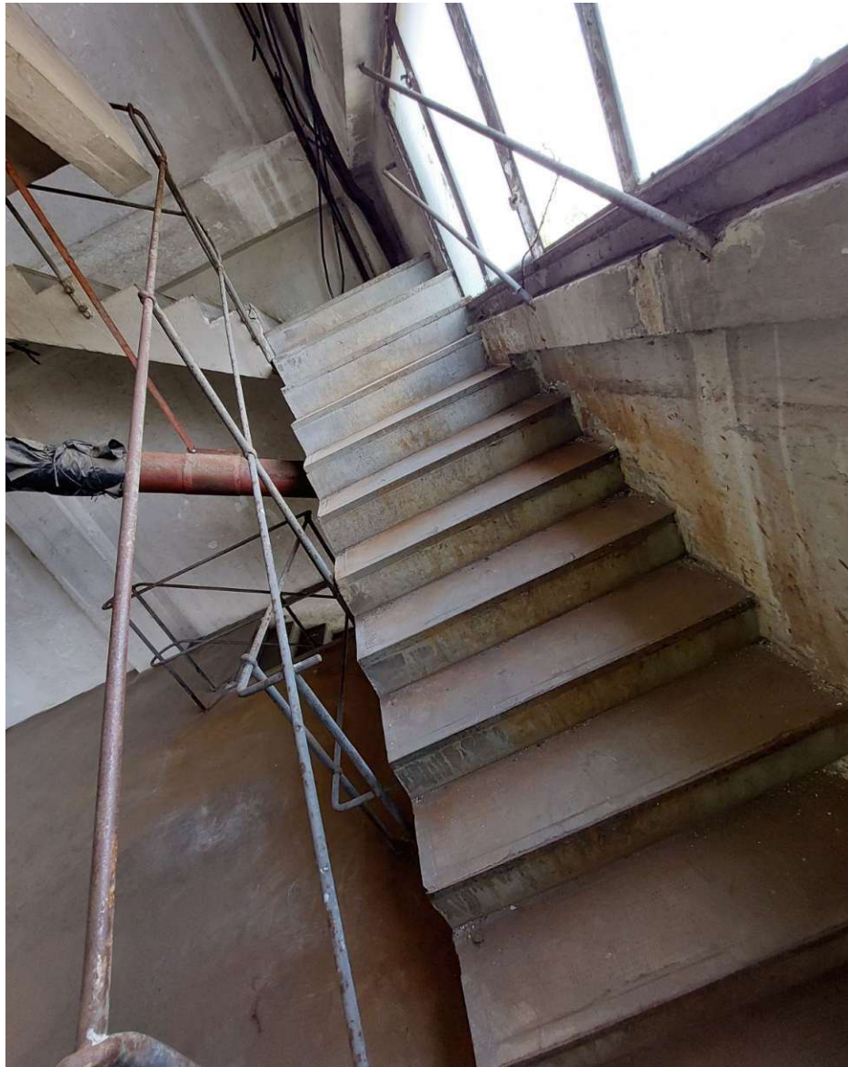
48. Abbildung: Betonstiege im sechsten Obergeschoss
