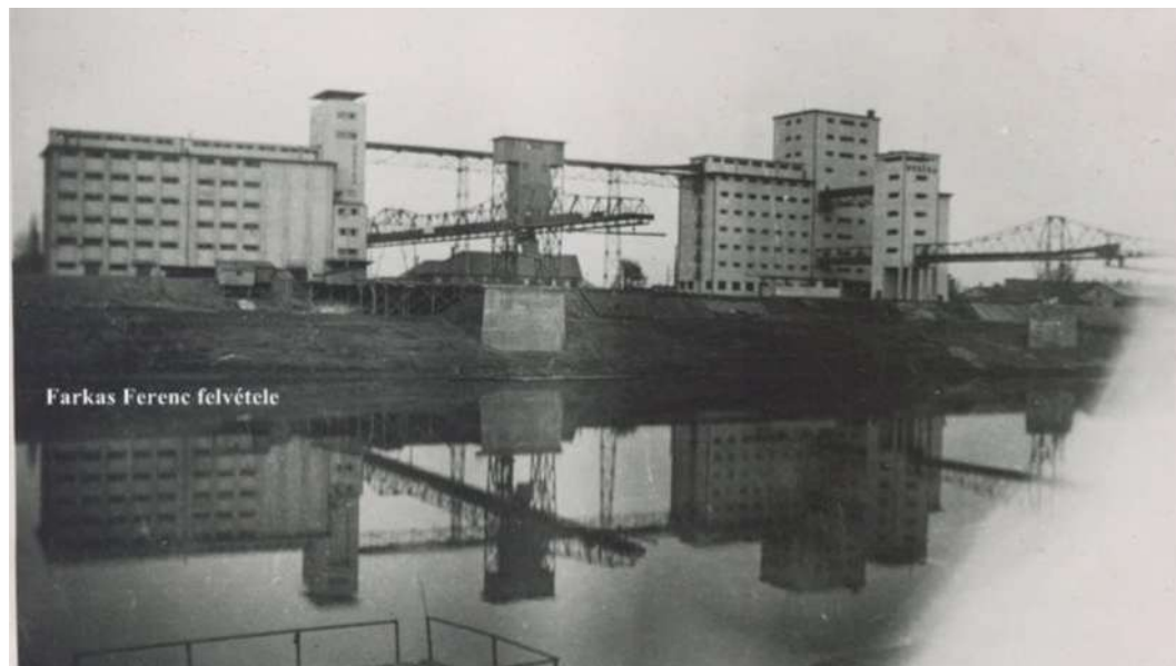
23. Abbildung: Der fertiggestellte Lagerhauskomplex mit den verbindenden Transportbrücken
