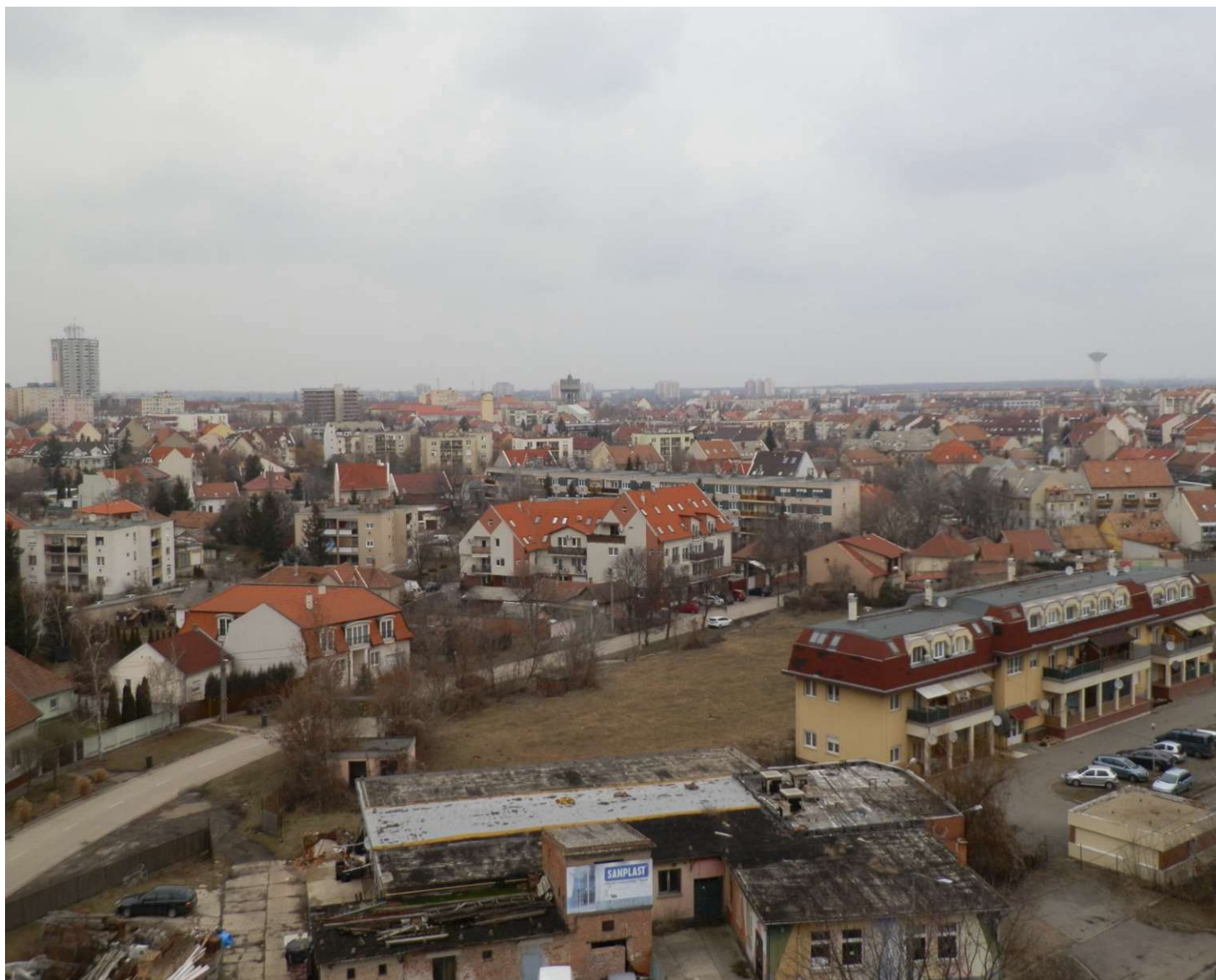
54. Abbildung: Blick auf die Straßenfront vom letzten Geschoss des Getreidespeichers
