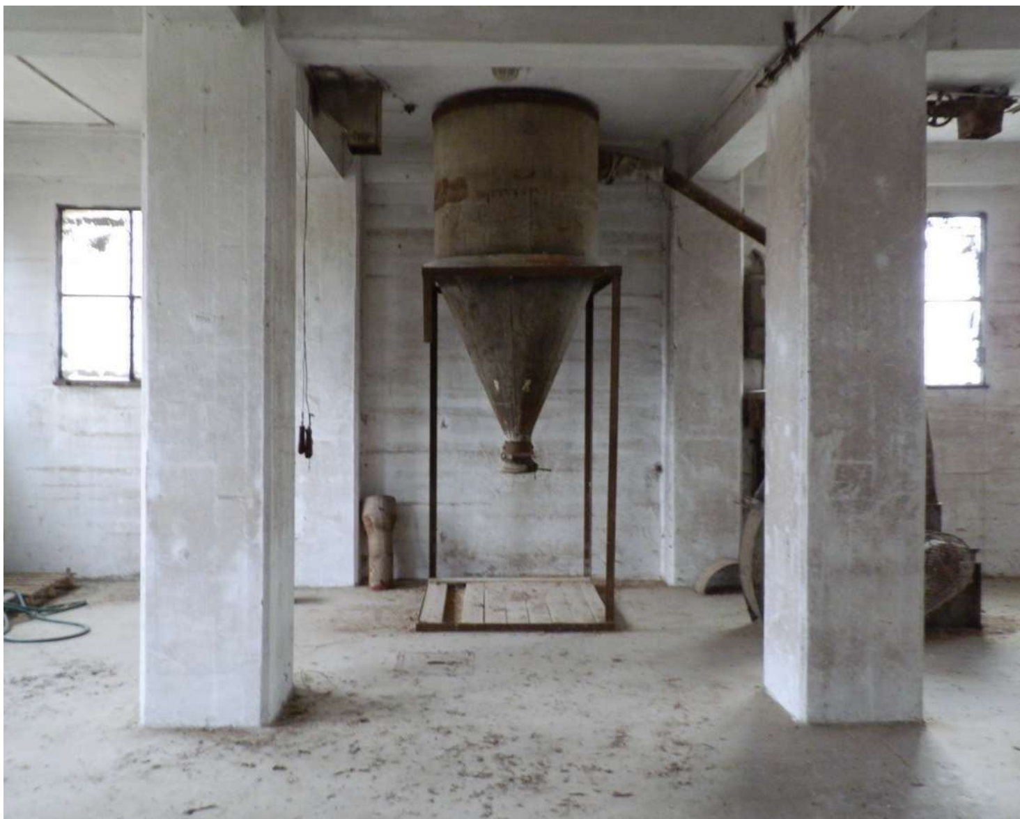
30. Abbildung: Der Auslass im westlichen Lagerhaus
