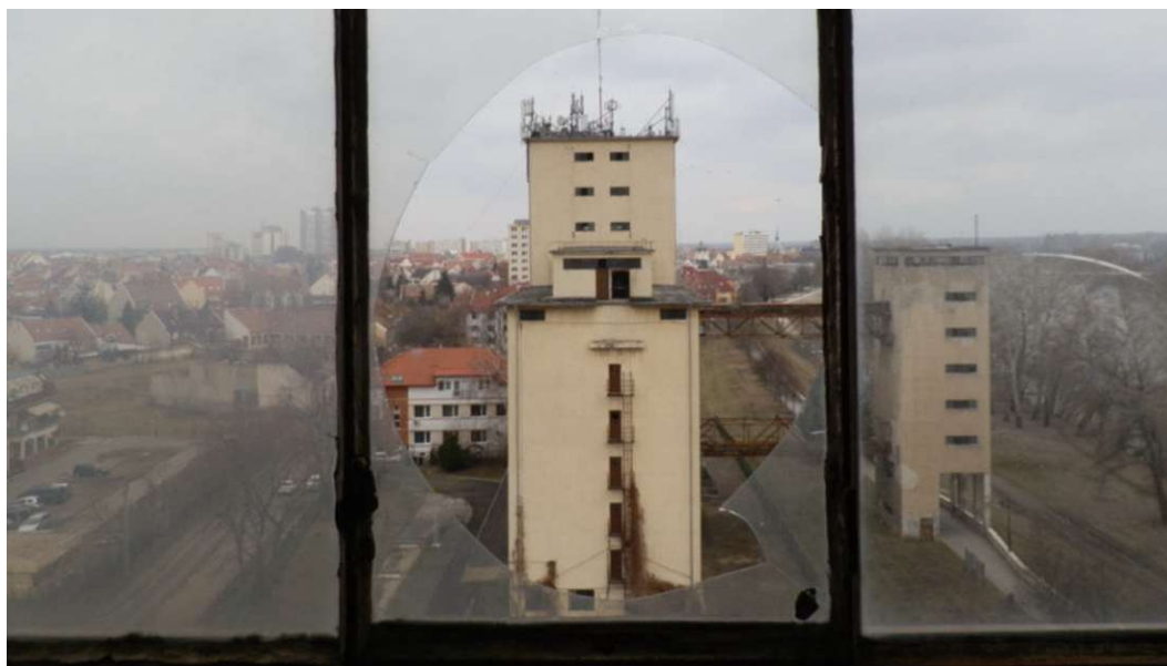
24. Abbildung: Blick vom westlichen zum östlichen Lagerhaus
