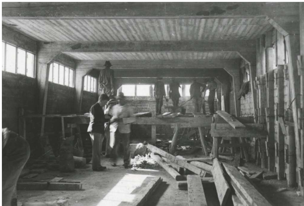
21. Abbildung: Der Standort des Förderbandes, das ausgeschalte Dachbodenniveau
