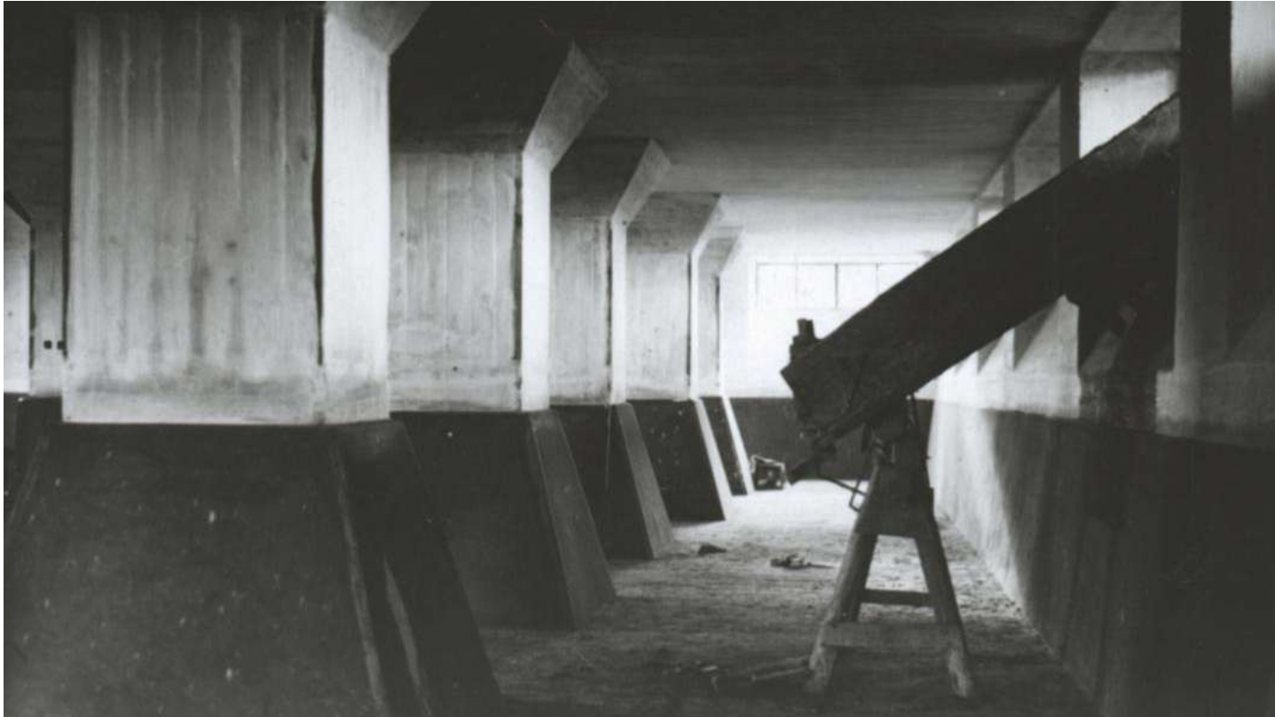
38. Abbildung: Der fertige Portland-Zementputz des Schutzbetons im Keller
