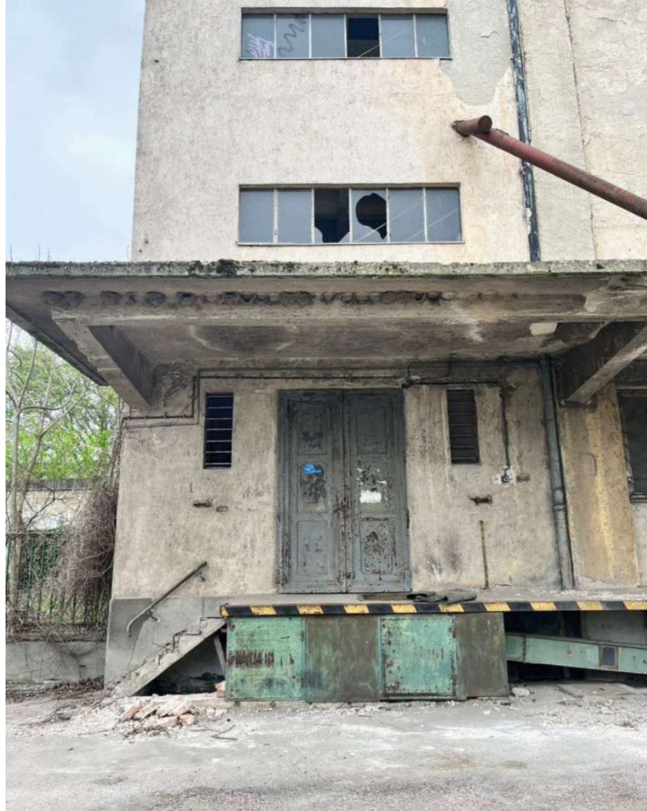
35. Abbildung: Eingang zum Westgebäude von der Straße aus
