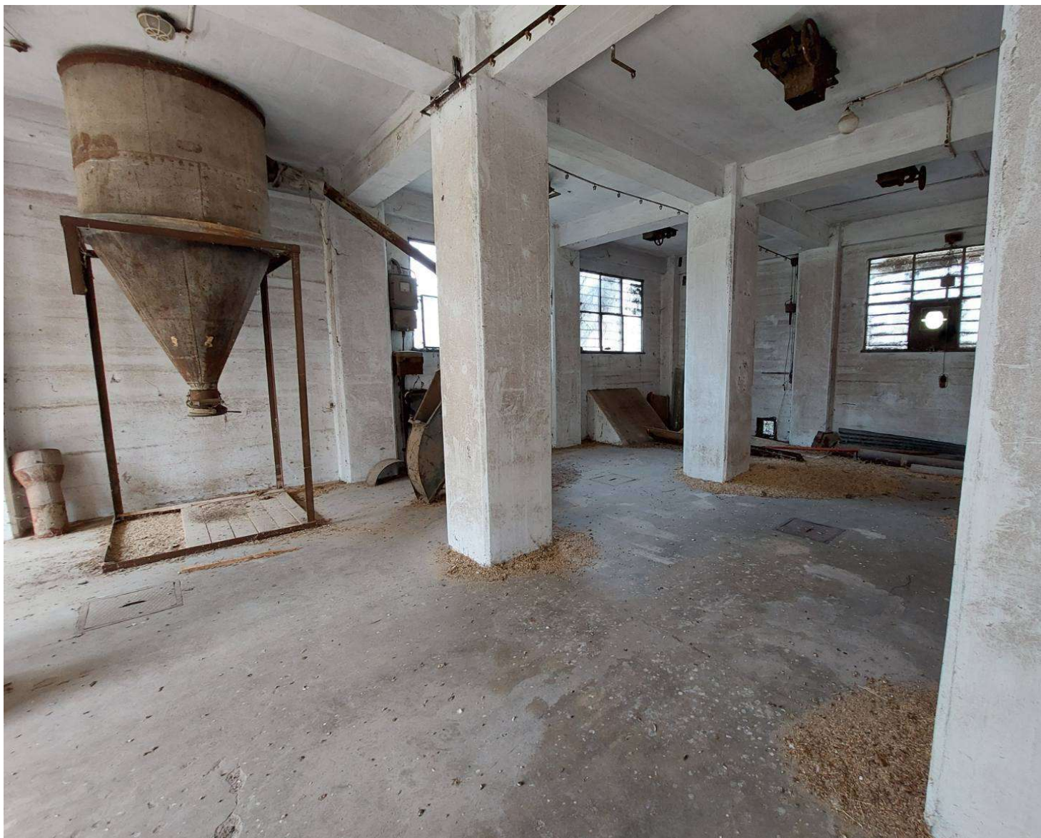
43. Abbildung: Erdgeschoss mit massiven rechteckigen Betonfeilern und einem trichterförmigen Metallbehälter
