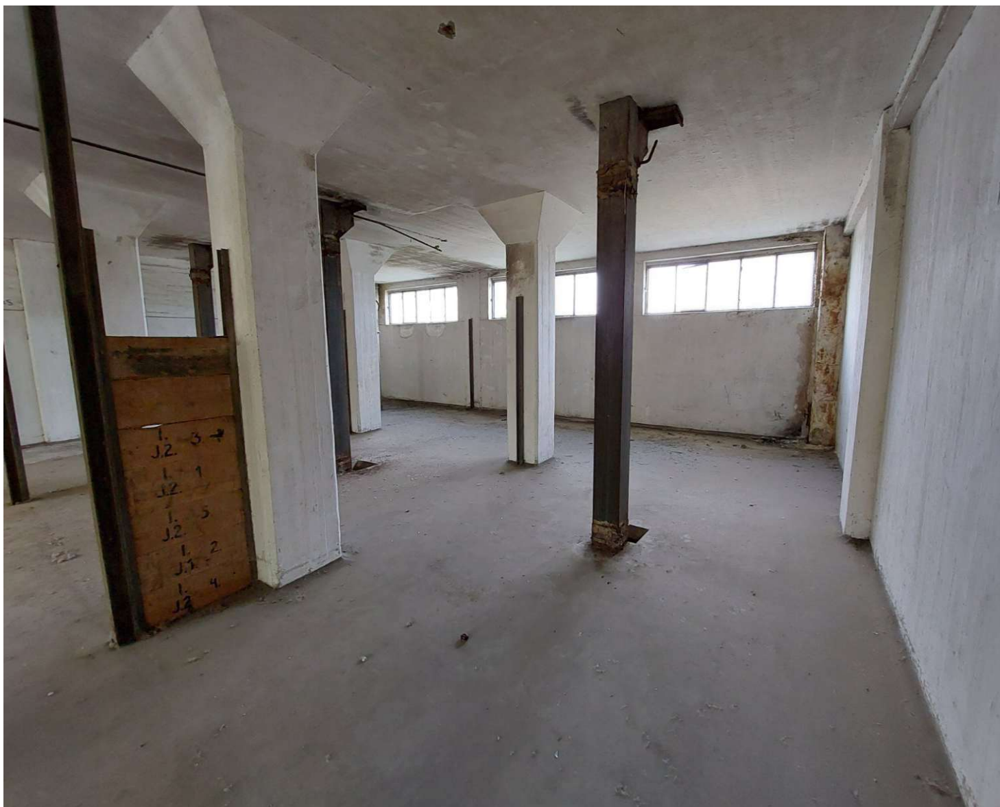
45. Abbildung: Die Pilzsäulen auf dem dritten Obergeschoss
