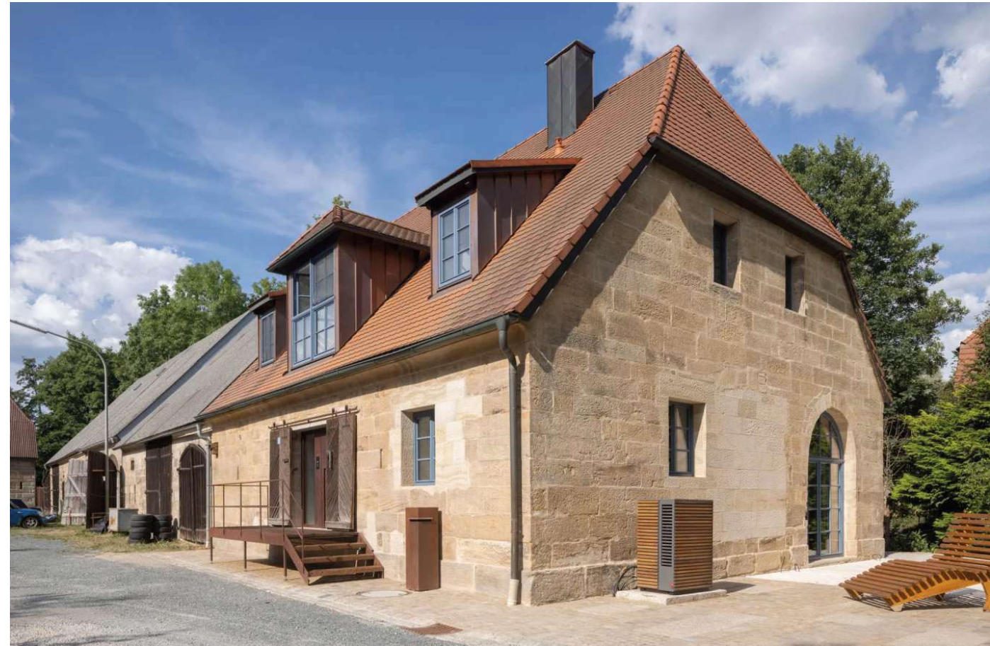
Abbildung 76 | Ehemaligen Scheune nach Umbau
