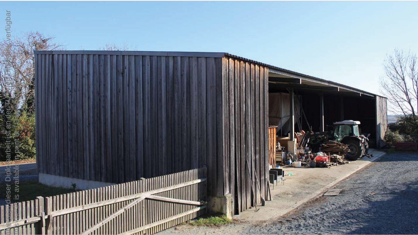
Abbildung 25 | Geräte- und Maschinenhalle
