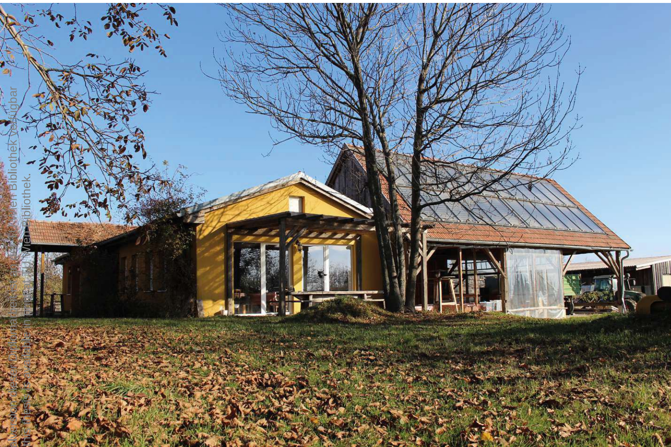
Abbildung 21 | Nebengebäude Halle und Scheune
