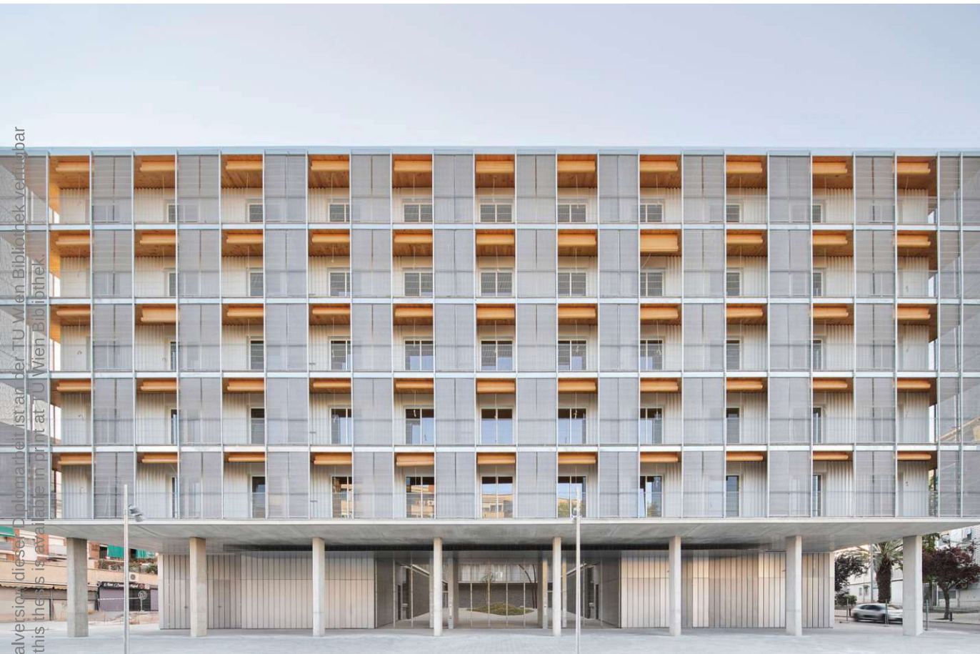
Abbildung 59 | Ansicht des Sozialen Wohnungsbaus in Cornellà de Llobregat
