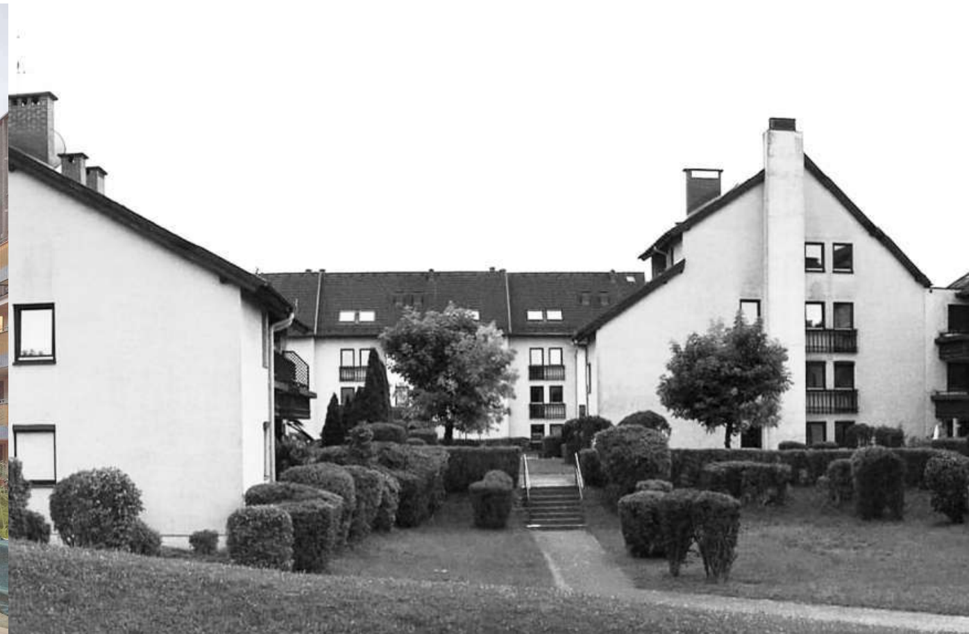
Abbildung 80 | Wohnanlage Friedrich- Inhauser- Straße vor Umbau
