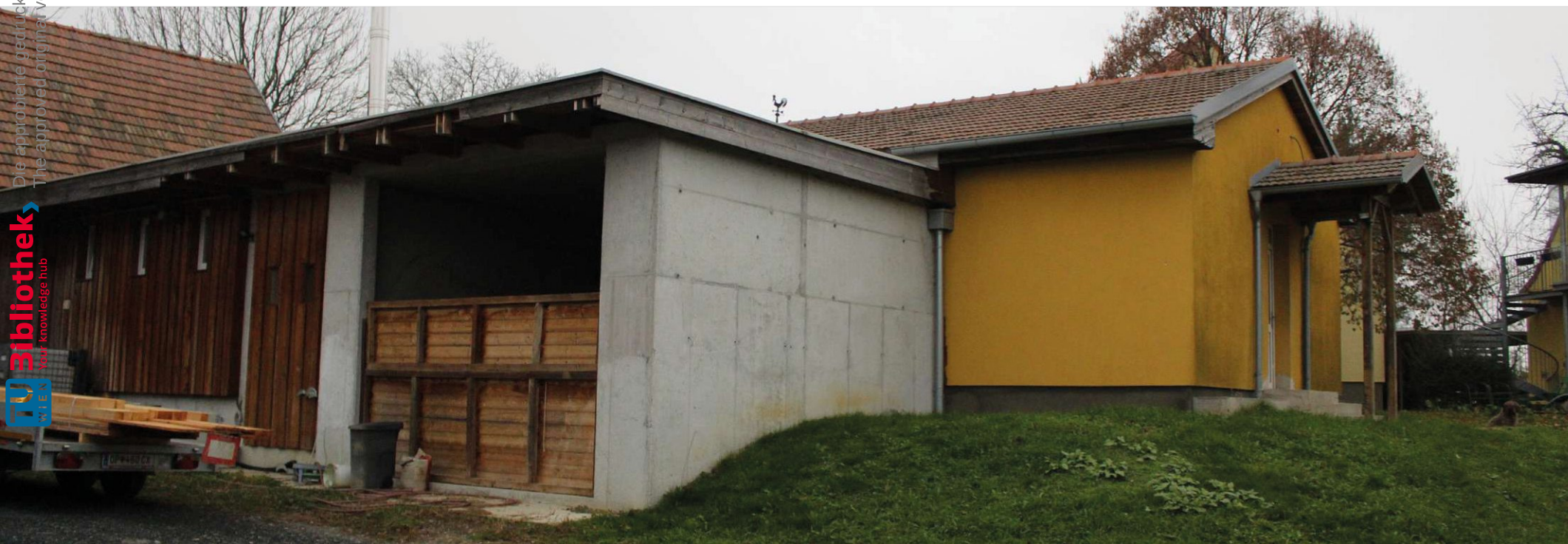
Abbildung 29 | Nebengebäude 03 und Heizwerk
