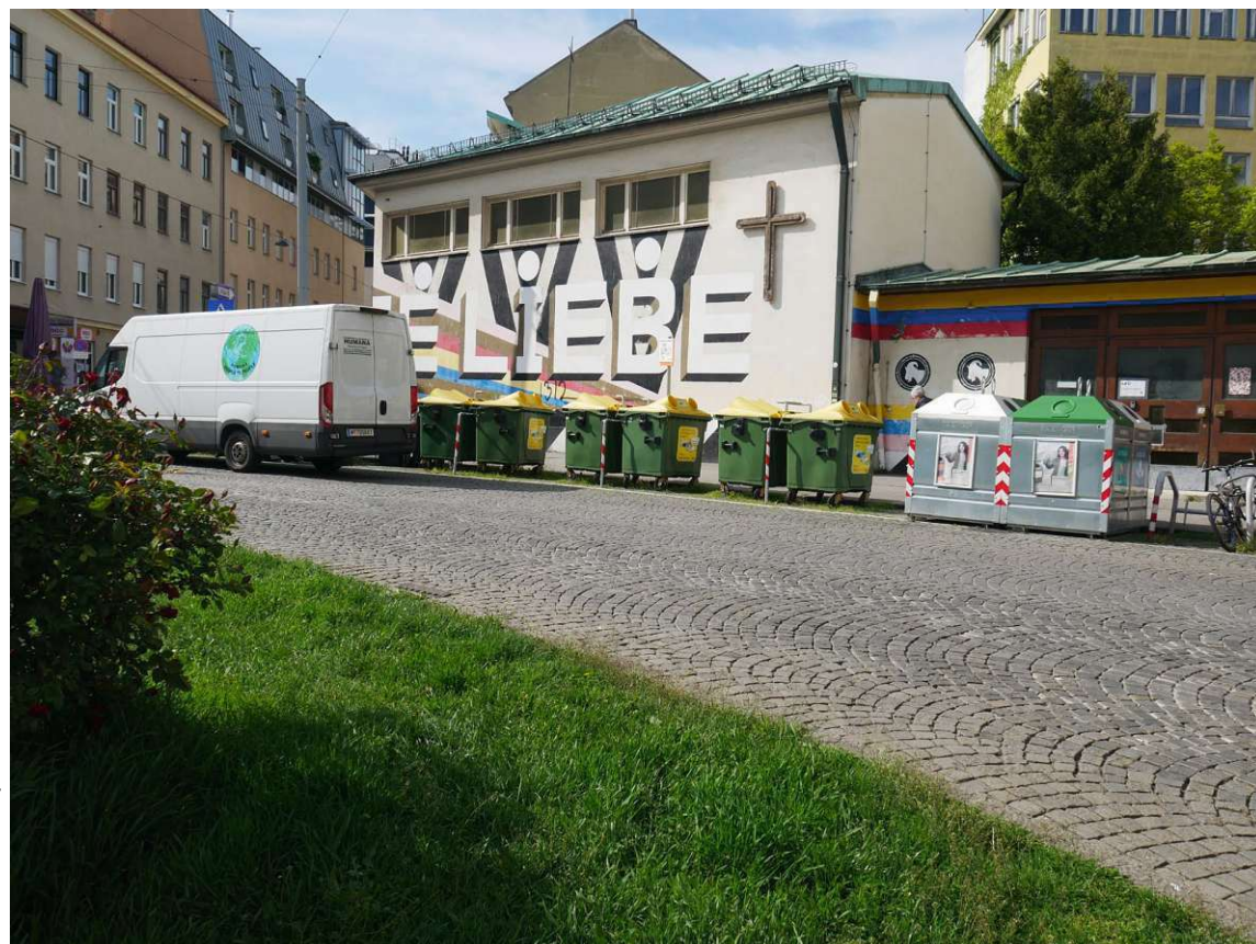
Ehemalige Klosterkirche, Gellertplatz 7, 2023
