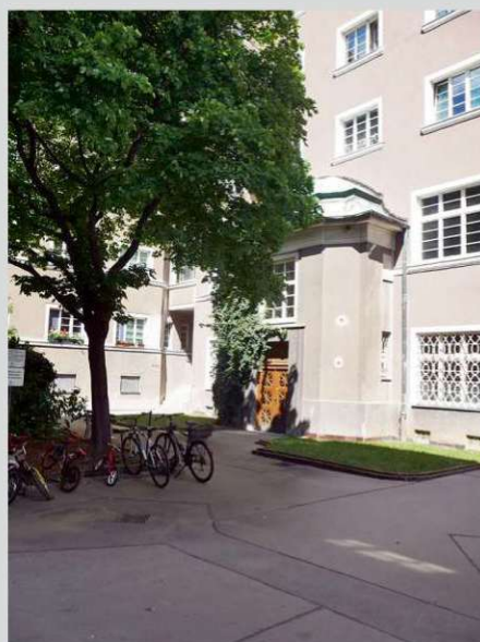
Eingang Gemeindebau Johann-Witzmann-Hof, Wien, 2020
