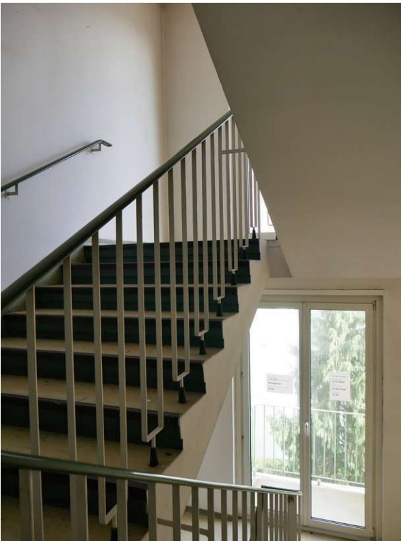
Stiegenhaus mit Balkon, 2023
