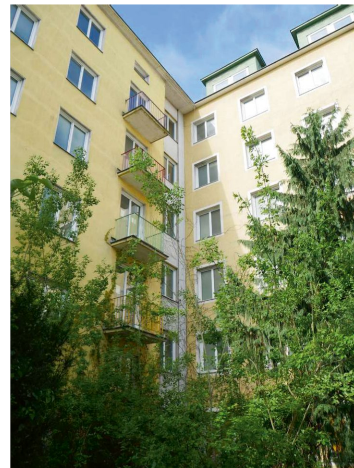
Straßen- und Verbindungsbau im Hof, 2023 Verbindungsbau, 2023
