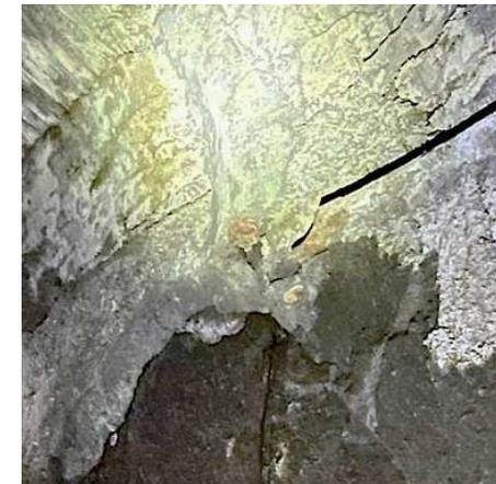
**Abb. 87:** Die abgebrochene Verbindung zwischen Ziegelrohr und oberer Rinne.
