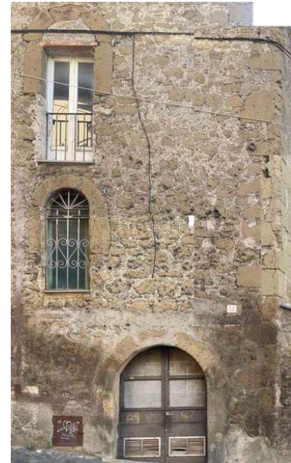
**Abb. 11:** Eine Hausfront aus Tuffmauerwerk.
