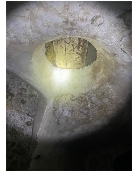
Abb. 45: Ein Deckendurchbruch im vorderen Bereich des Kellers.
