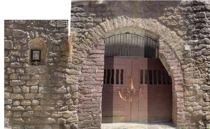
**Abb. 107:** Der Eingang einer Cantine mit offensichtlich jüngeren Umbauten.
