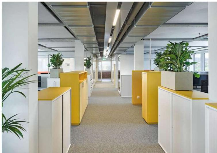
Abb. 31: Neu: Brandschutzverkleidungen, Zuluft und Akustikpaneele.
