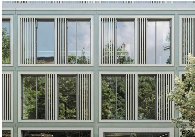
Abb. 36: Die neue Fassade enthält großzügige, bodentiefe Glaselemente. © Brigida Gonzalez
