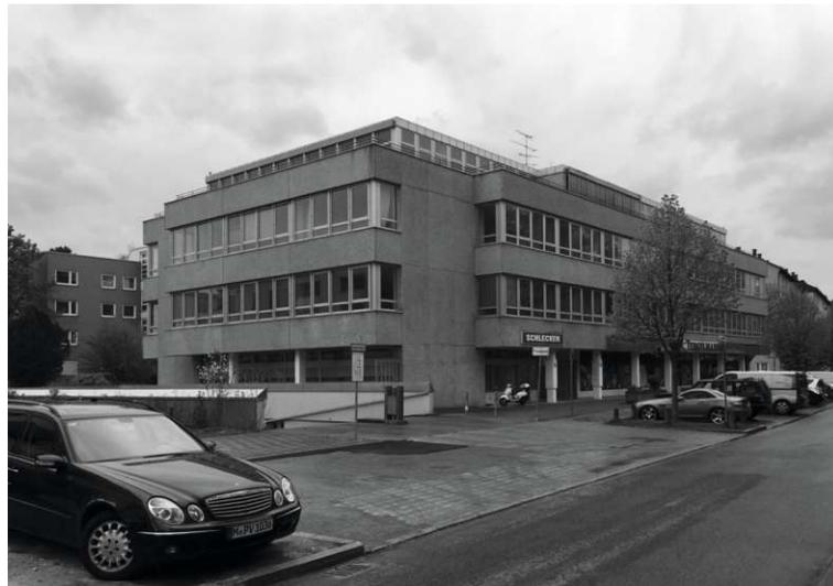
Abb. 34: Bestandsfoto des Bürogebäudes mit Waschbetonfassade.
