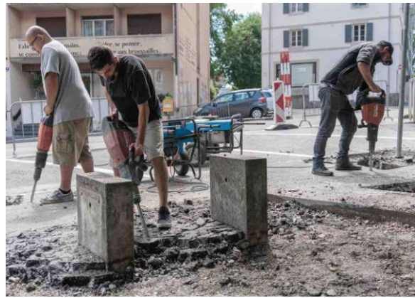
Abb. 9: Entsiegelungsarbeiten am „Place du Vallon“ © Atelier OLGa 2019
