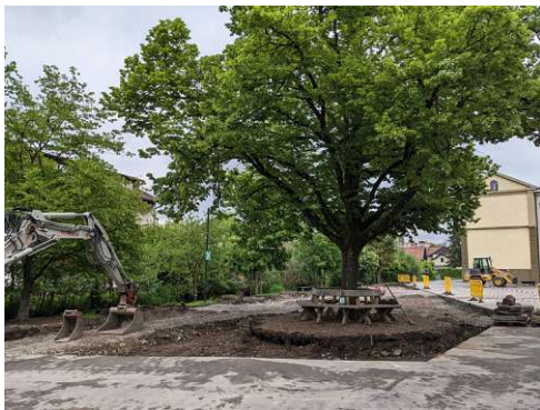
Abb. 12: Entsiegelungsarbeiten in Hard am Bodensee © Jasmin Zdovc
