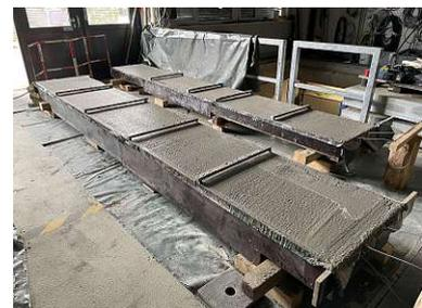
(i) Aufbetonschicht betoniert
