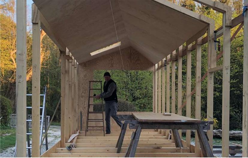
Montieren der Seekiefer zum Aussteifen der Tragkonstruktion
