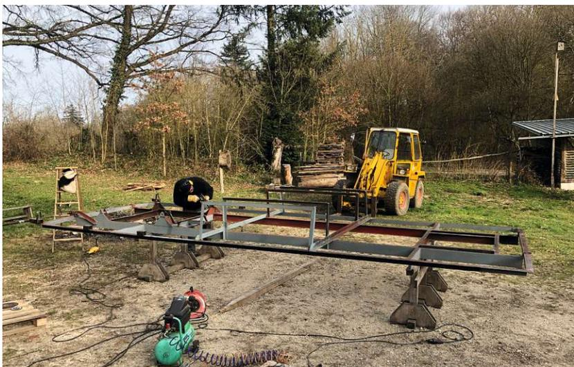
Entrosten und auftragen des neuen Korrosionsschutz
