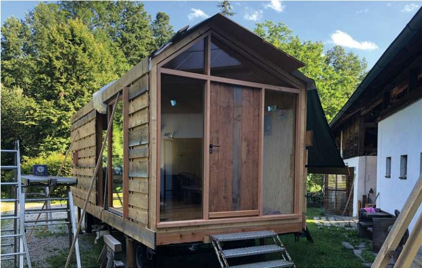
Montierte Lattung und Kotterlattung zur Hinterlüftung
