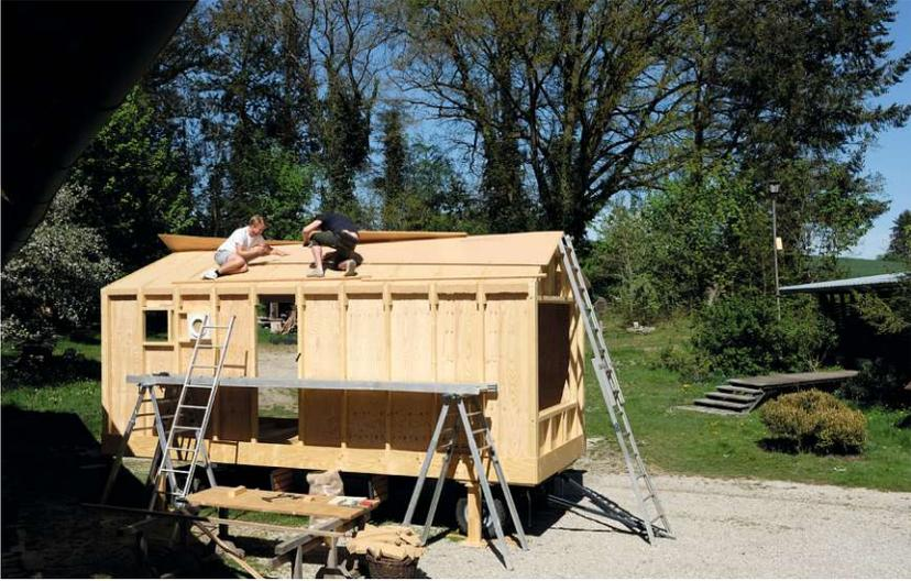
Dämmen des Daches mit Holzfaserdämmung
