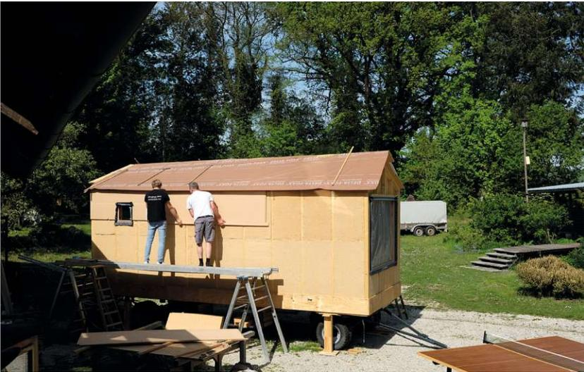
Montieren der Holzfaserdämmplatten
