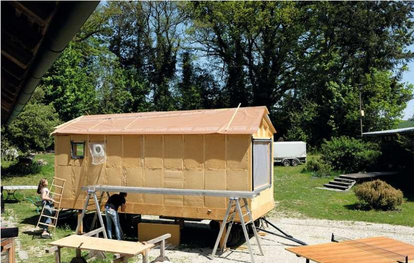
Ausfachen der Wände mit Holzfaserdämmung
