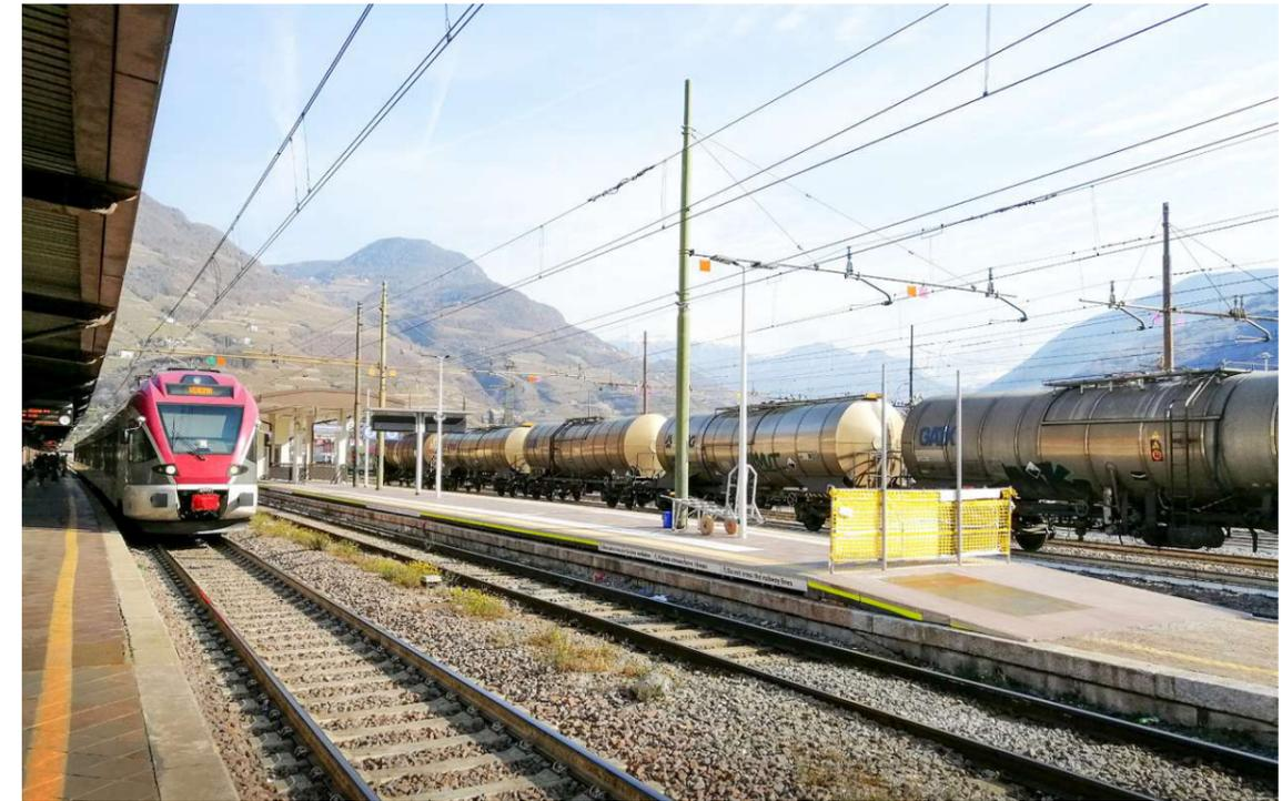
Abb. 19: Anhebung Bahnsteigniveau auf 55cm, Gleis 5 und 6
