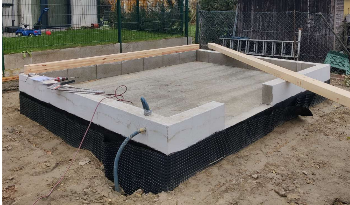
Anhang A.01 Bodenplatte mit Sockel
