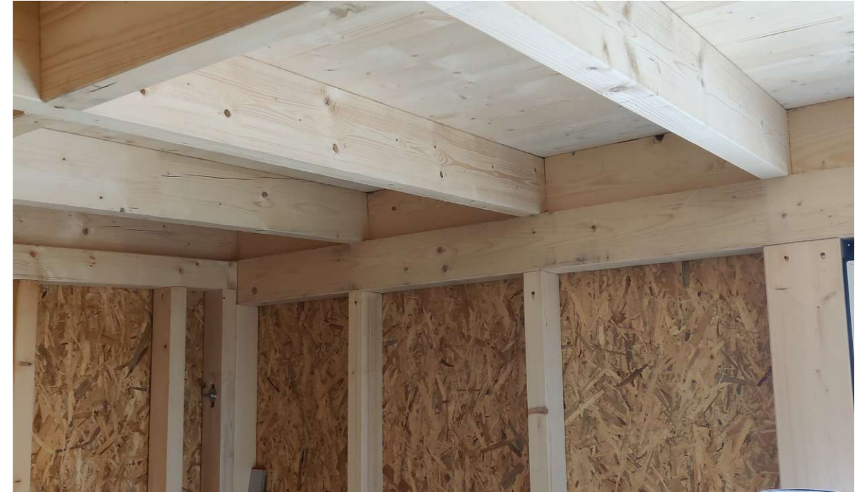
Anhang A.03 Ausrichtung Tramlage
