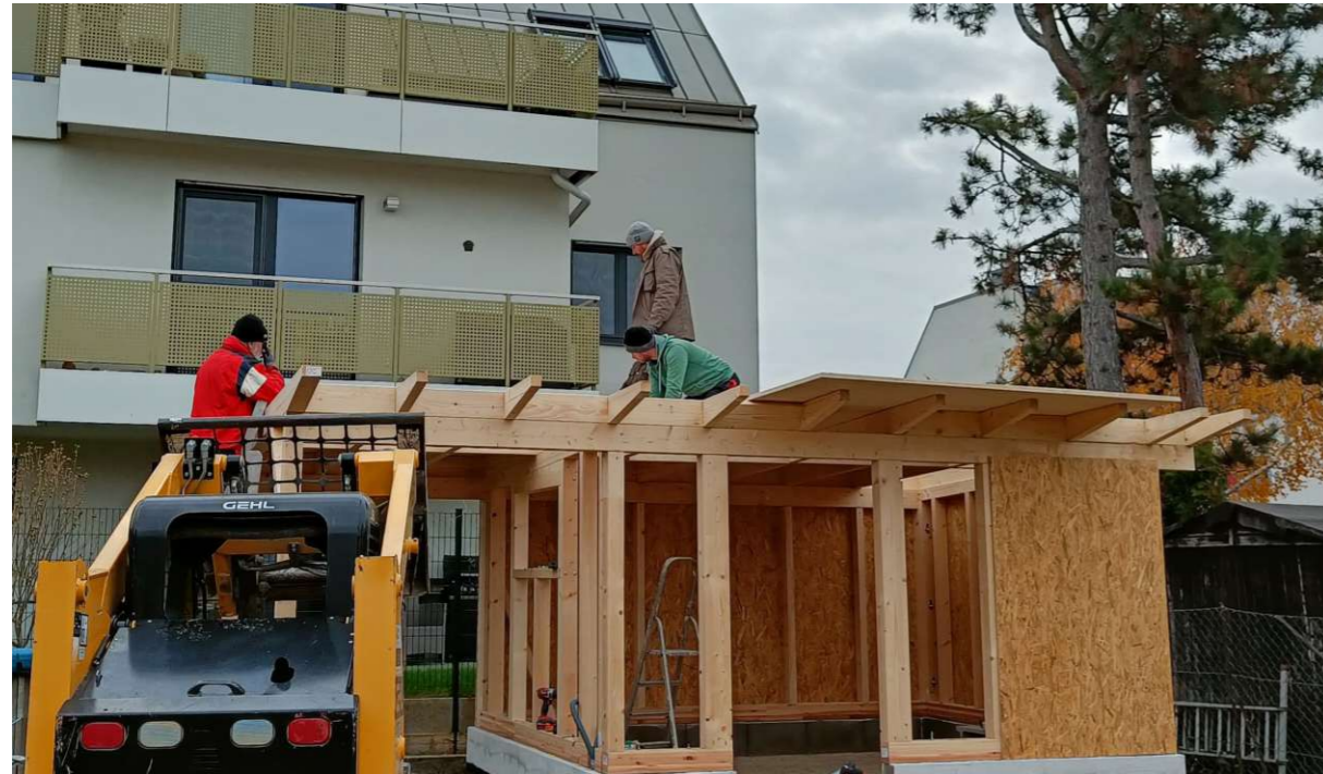
Anhang A.05 Verlegung OSB-Platten
