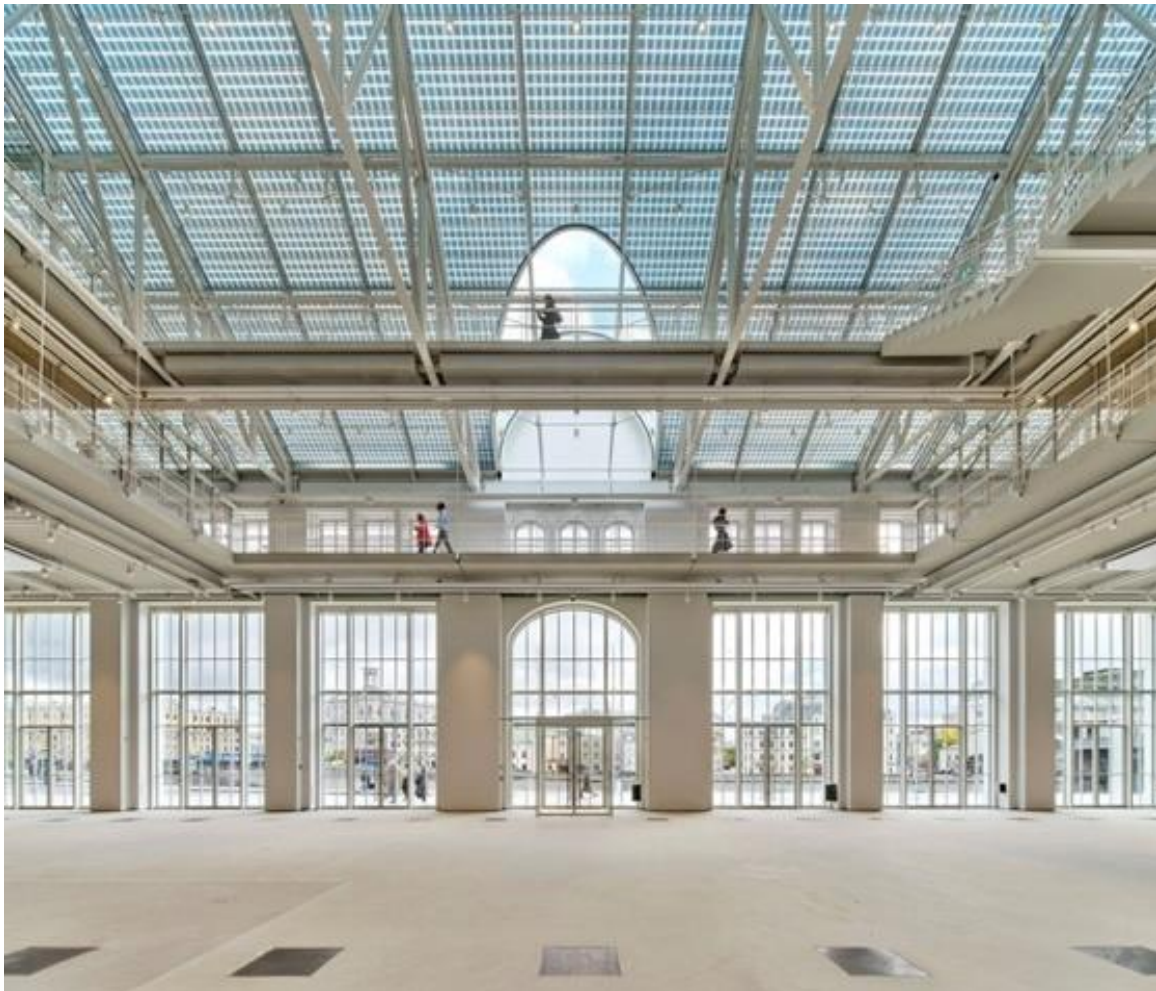
Abbildung 13: Glasdächer mit semitransparenten Solarmodulen, Museumshalle in Moskau, entworfen von Renzo Piano, Quelle: Sunovation GmbH
