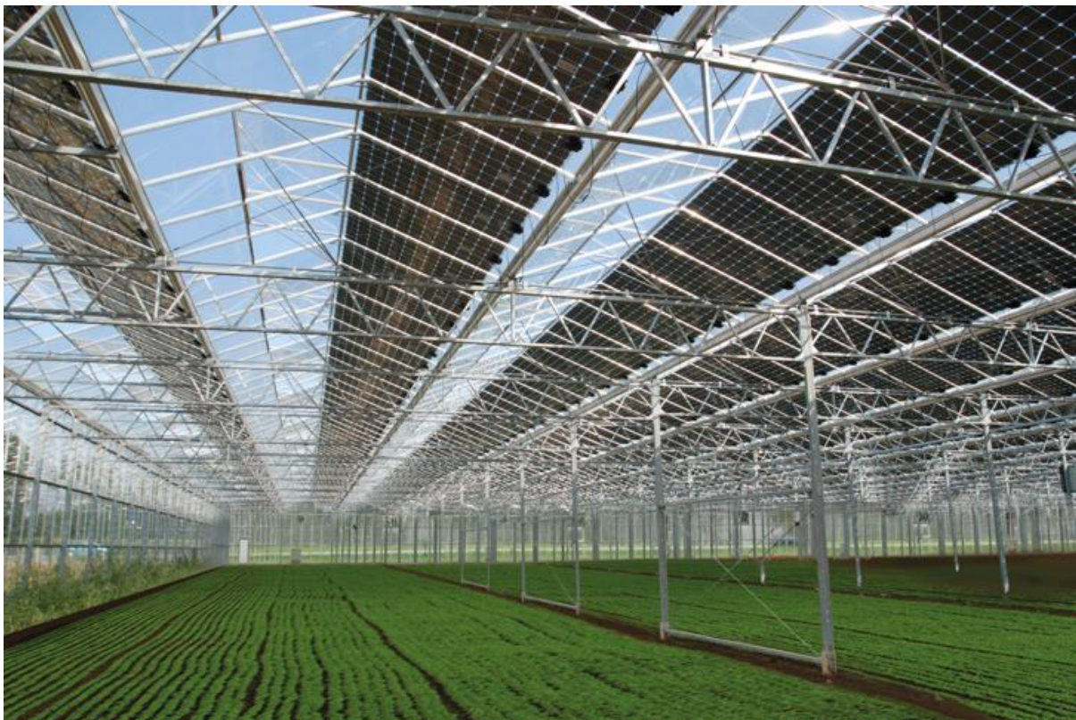
Abbildung 14: Großflächiges Gewächshaus mit semitransparenten Photovoltaikmodulen als Verschattungselemente, Quelle: Kioto Photovoltaics GmbH
