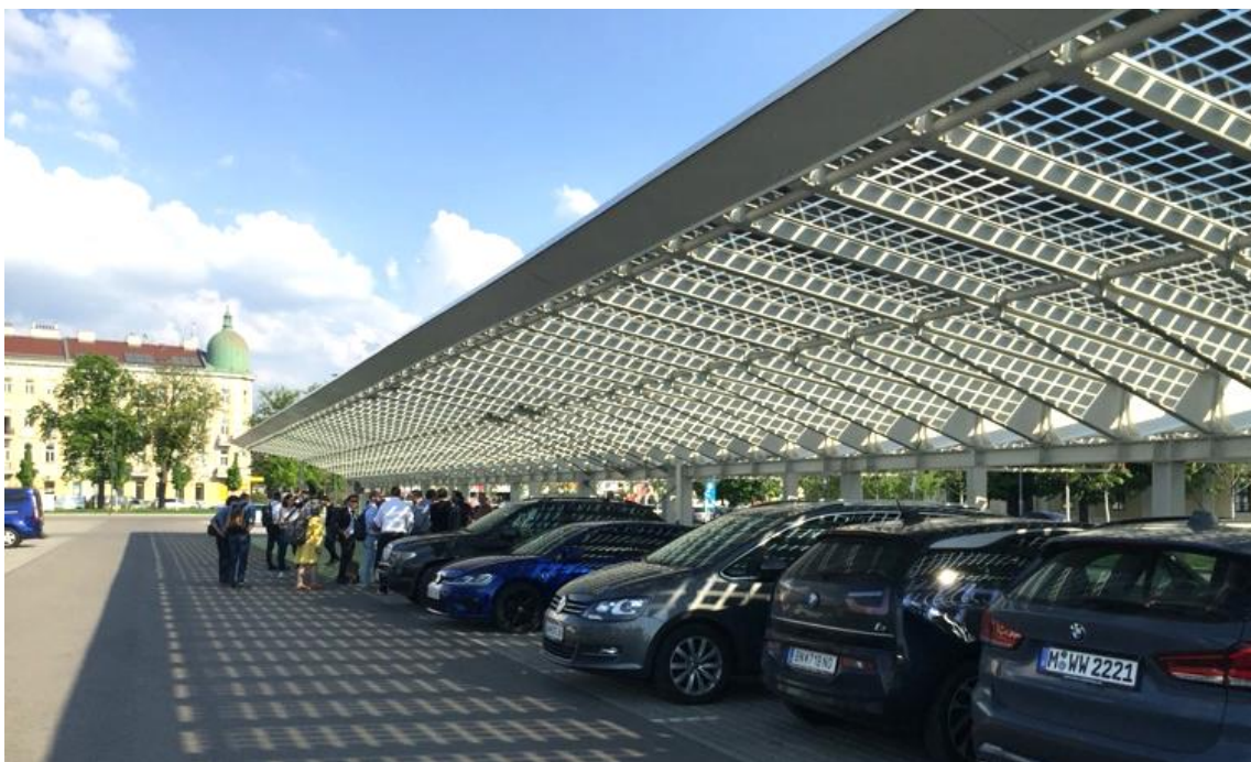
Abbildung 16: links: Parkplatzüberdachung in Wien Schönbrunn von Ertex Solar – Quelle Bild: Astrid Schneider;
