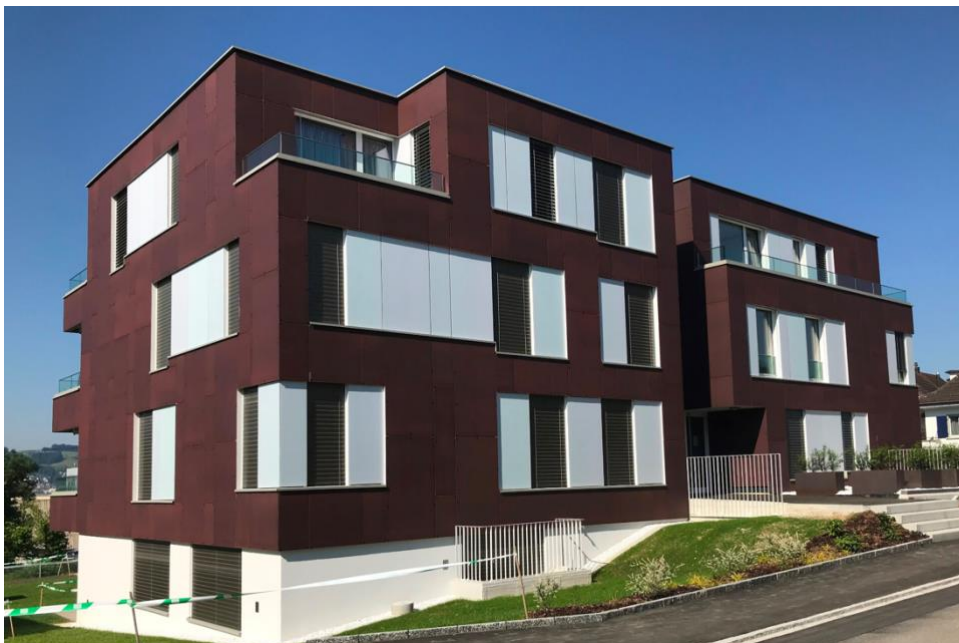
Abbildung 7: Wohngebäude in der Schweiz - Quelle: Solaxess
